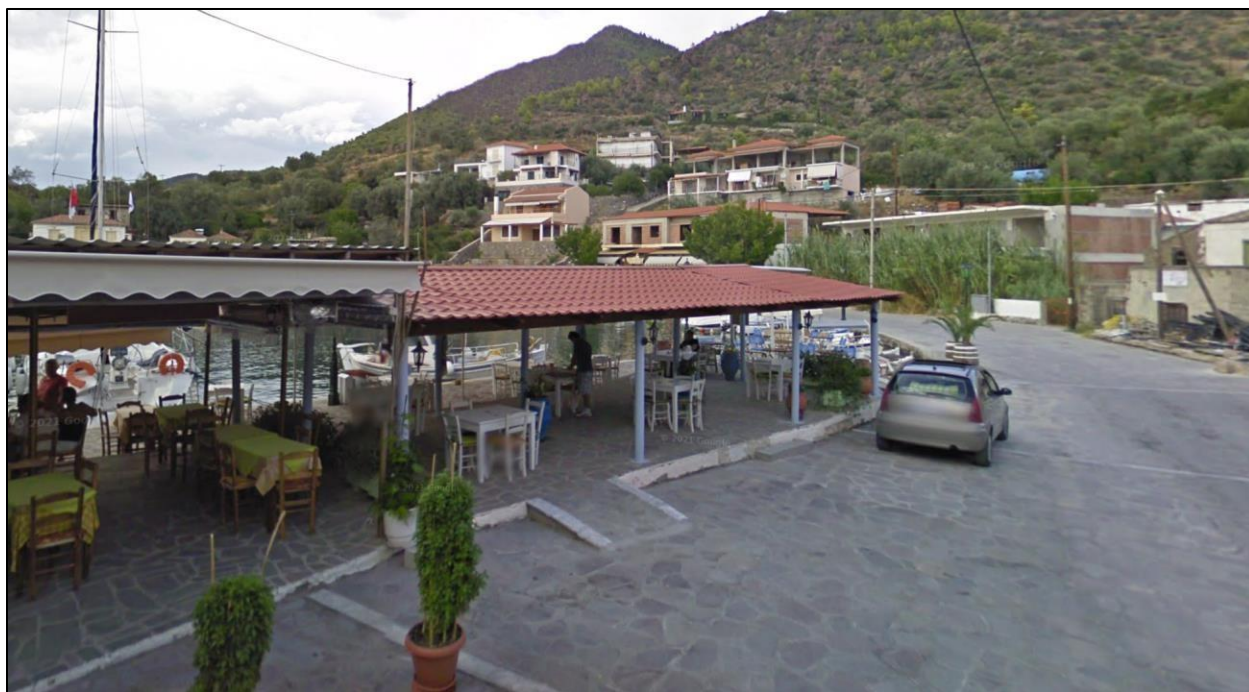
Εικόνα 56: Υφιστάμενο Εστιατόριο με ράμπα στον λιμένα του οικισμού Βαθύ Πηγή: Google Maps
