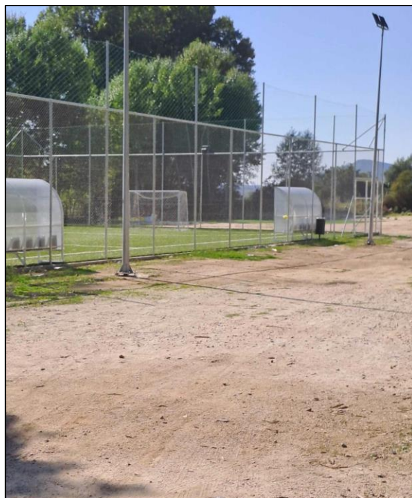
Εικόνα 35: Υφιστάμενη κατάσταση του δρόμου εντός του χώρου του γηπέδου Καρατζά (ιδία επεξεργασία)
