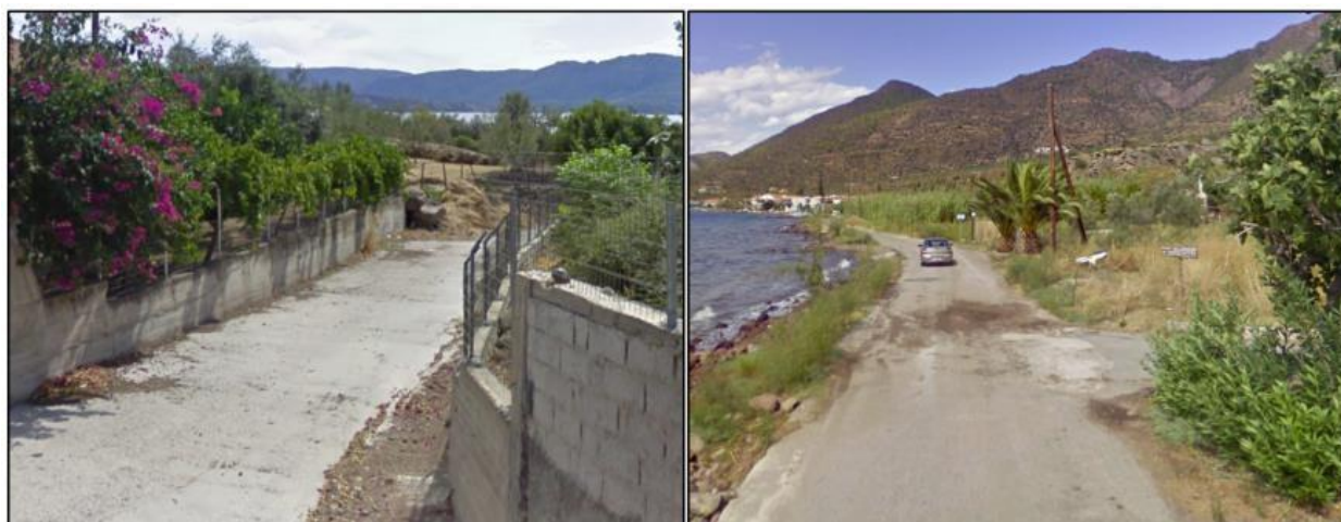
Εικόνα 48: Διαφορετική κατάσταση δρόμου εντός του οικισμού Βαθύ Πηγή: Google Maps
