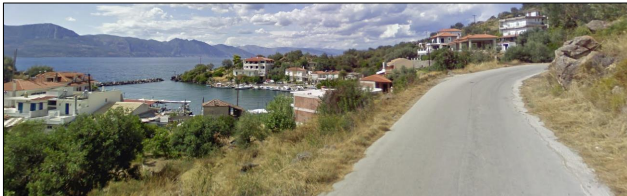
Εικόνα 53: Άποψη της συνέχειας της παραλιακής οδού εντός του οικισμού Βαθύ που οδηγεί στον οικισμό της Καμένης Χώρας Πηγή: Google Maps
