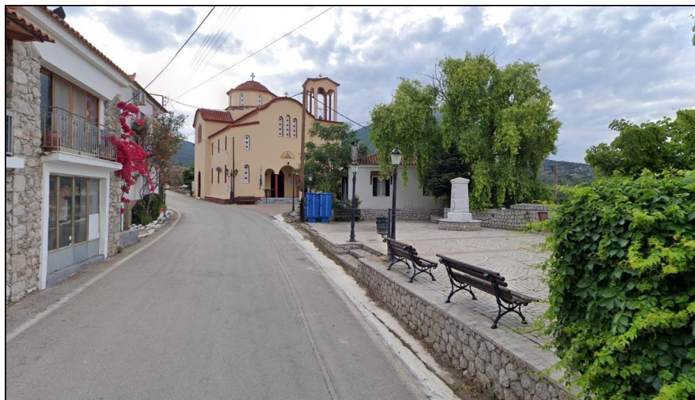
Εικόνα 37: Άποψη κατάστασης της κεντρικής οδού στην πλατεία του οικισμού Καρατζά Τροιζήνας Πηγή: Google Maps
