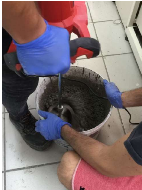
Εικόνα 12 - Επιτυχές μίγμα σκυροδέματος
