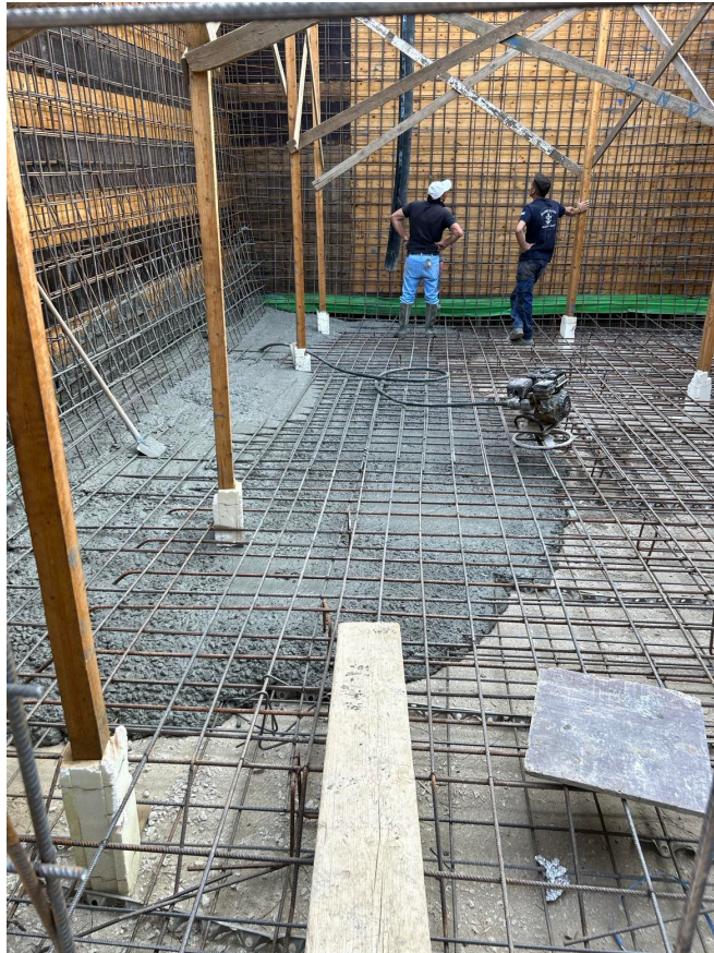
Εικόνα 22:Σκυροδέτηση πλάκας θεμελίωσης
