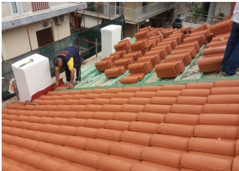
Εικόνα 51:Τοποθέτηση κεραμιδιών
