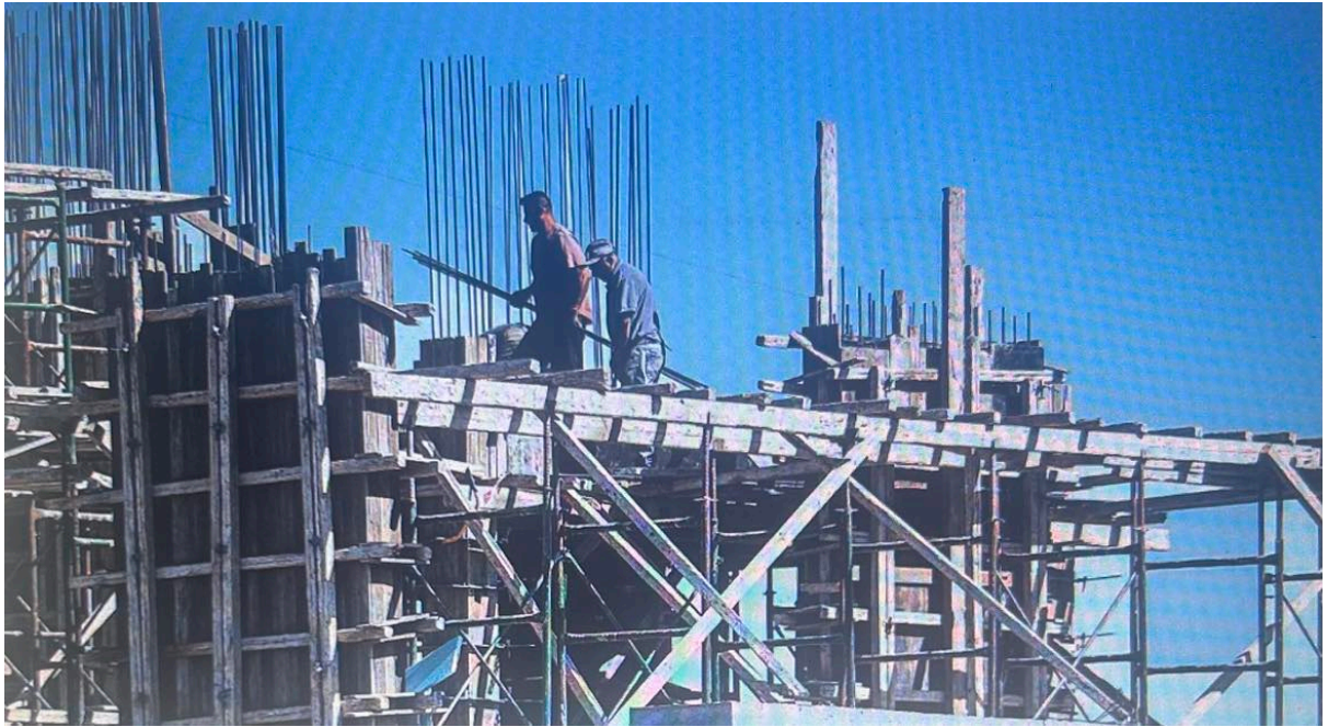
Εικόνα 21:Εργασίες τοποθέτησης ραβδών οπλισμού
