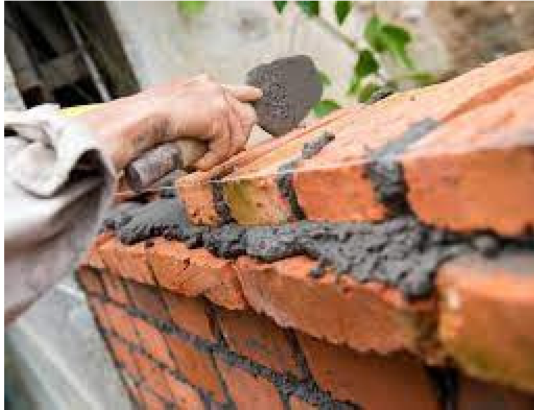
Εικόνα 33: Έλλειψη ευθυγράμμισης
