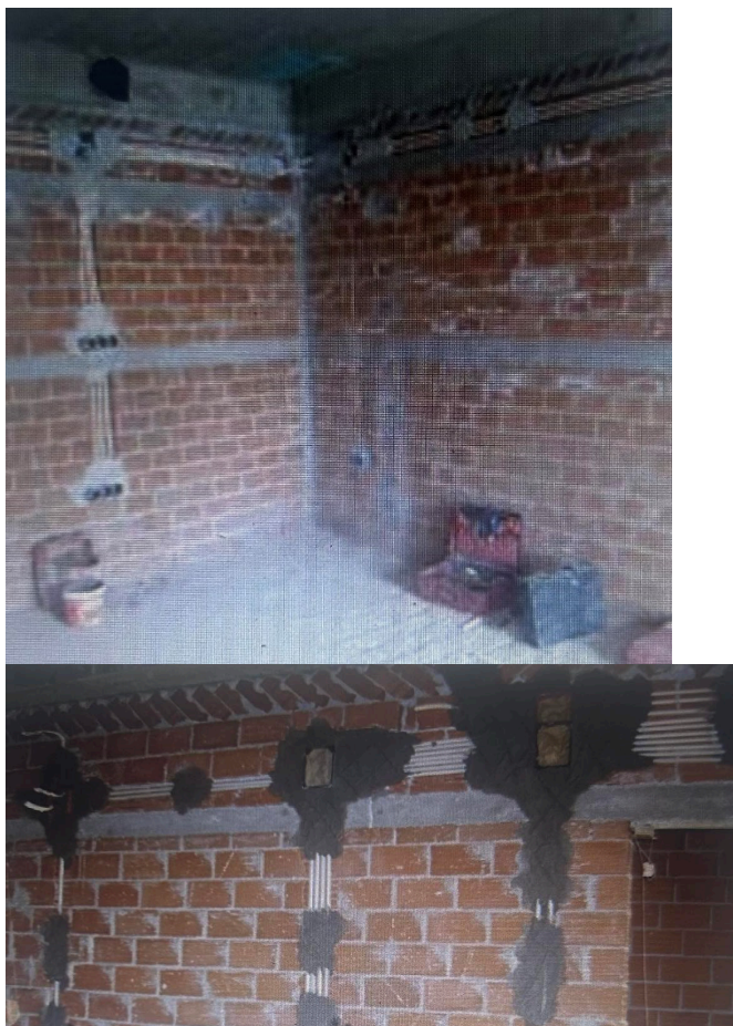
Εικόνα 39: Τοποθέτηση καναλιών αγωγών για την ηλεκτρική εγκατάσταση του οικήματος
