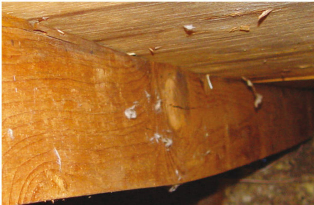
Εικόνα 48: Λάθος σχεδιασμού: Μη ορθή παραλαβή φορτίων από τον φέροντα οργανισμό
