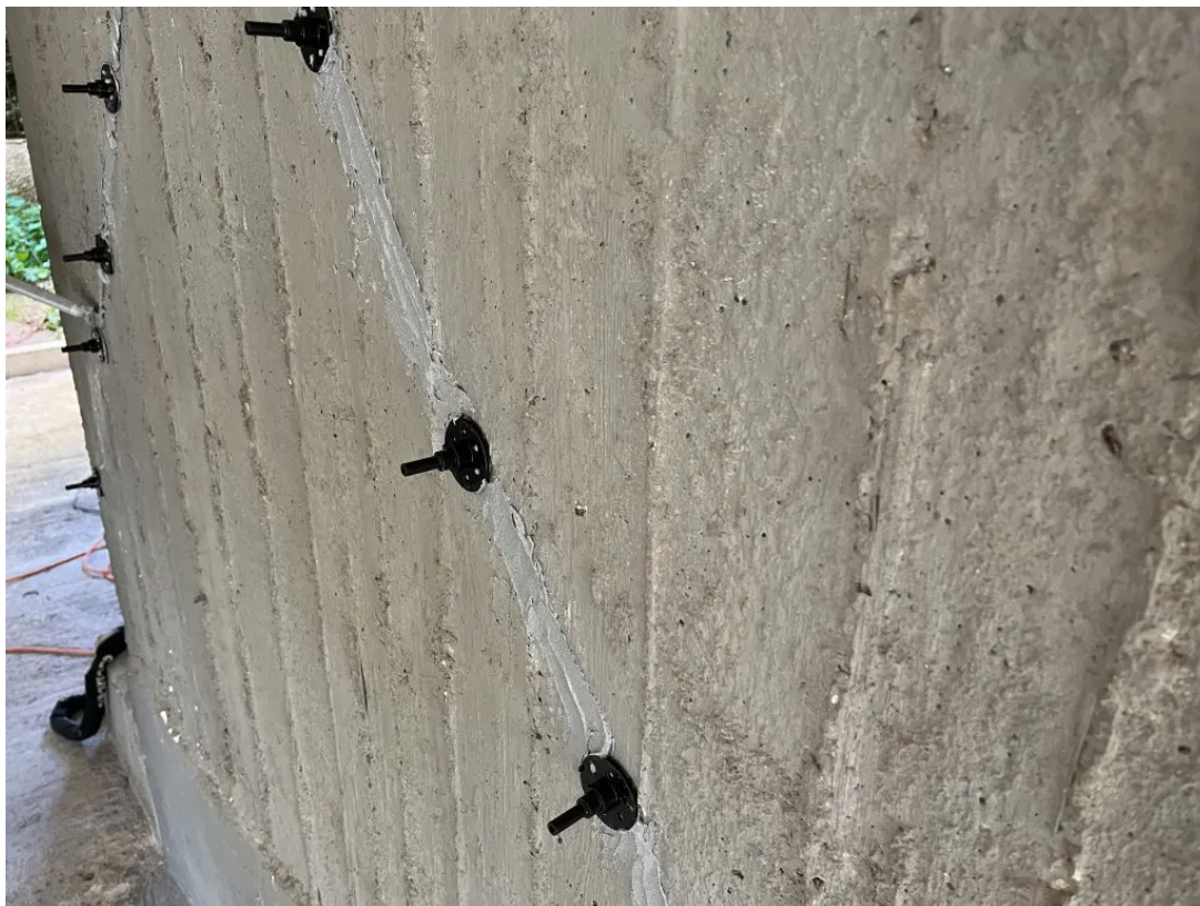
Εικόνα 19:Επιδιόρθωση ρωγμών
