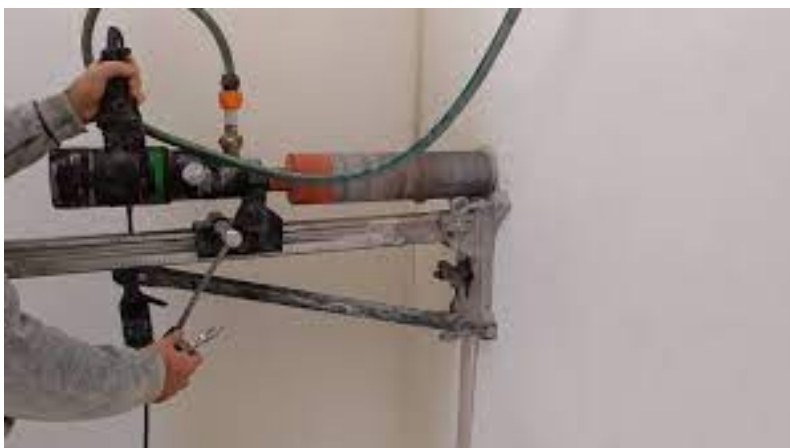
Εικόνα 14:Λήψη πυρήνων για έλεγχο σκληρυμένου σκυροδέματος
