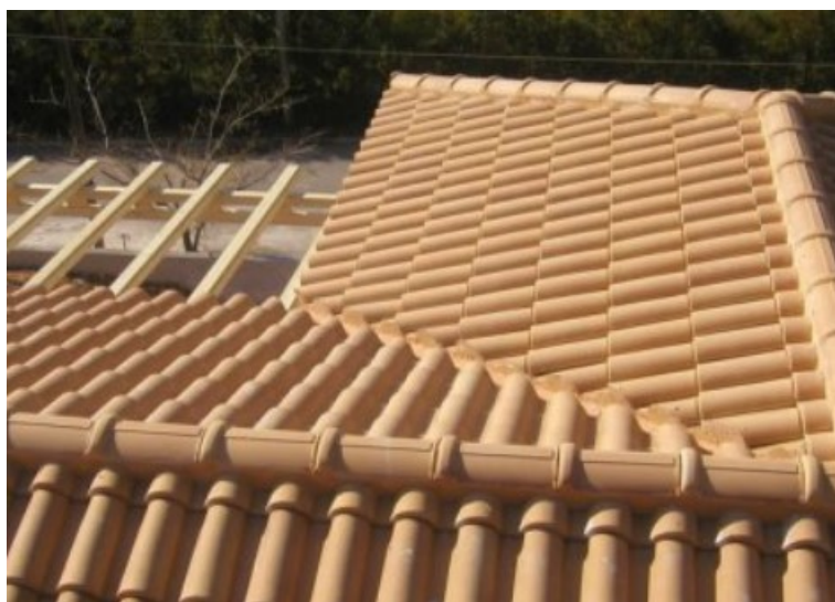
Εικόνα 50:Τοποθέτηση στέγης
