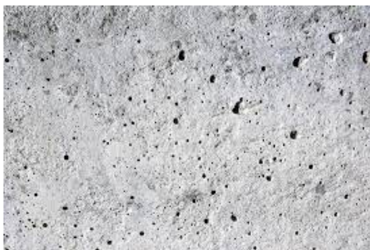
Εικόνα 27: Δημιουργία πόρων στην επιφάνεια του σκυροδέματος
