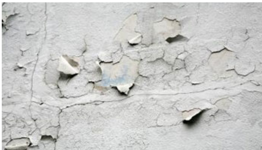
Εικόνα 46:Μικρές χαλαρές μάζες σχηματίζονται σε σοβατισμένες επιφάνειες λόγω αστοχίας συγκόλλησης μεταξύ των επιστρώσεων, γνωστή ως απολέπιση. Εάν ένα μικρό μέρος ξεκολλήσει από την επιφάνεια και σχηματιστεί ένα έμπλαστρο, γνωστό ως ξεφλούδισμα.
