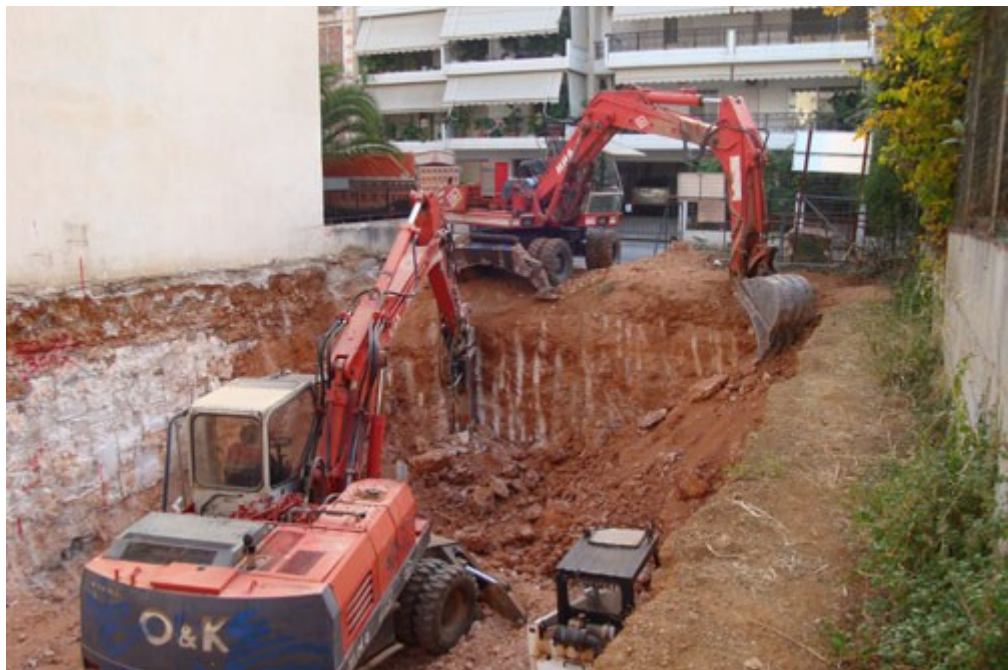
Εικόνα 5: Διενέργεια εκσκαφής με όμορα κτίρια χωρίς προσθήκη προστασίας
