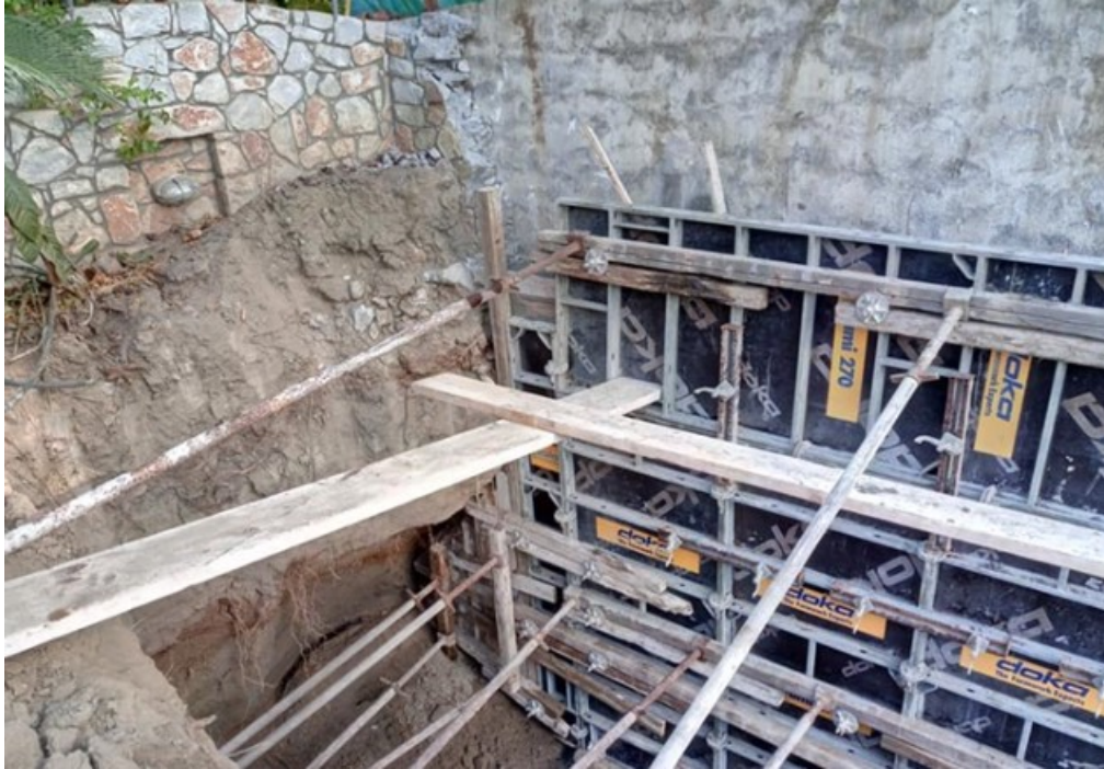
Εικόνα 4: Προστασία όμορου κτιρίου κατά τις εργασίες εκσκαφής
