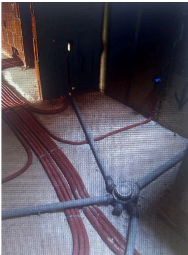
Εικόνα 60: Τοποθέτηση σωληνώσεων συστήματος θέρμανσης
