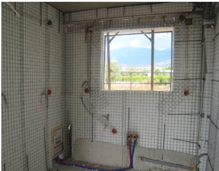
Εικόνα 57: Τοποθέτηση αναμονών και σωληνώσεων υδραυλικής εγκατάστασης σε μπάνιο της οικίας
