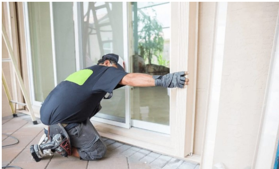
Εικόνα: 72 Έλεγχος κουφωμάτων
