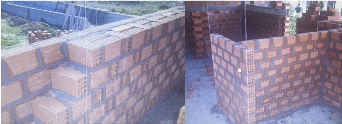
Εικόνα 36:Εργασίες τοιχοποιίας
