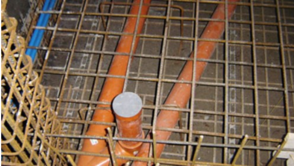
Εικόνα 56: Τοποθέτηση σωλήνων υδραυλικής εγκατάστασης στο πάτωμα του μπάνιου
