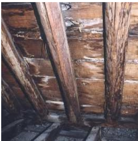
Εικόνα 54:Υγρασία λόγω κακής αδιαβροχοποίησης
