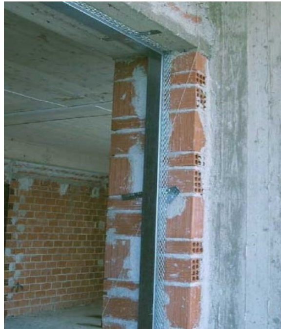
Εικόνα 70: Προετοιμασία για την τοποθέτηση κουφωμάτων
