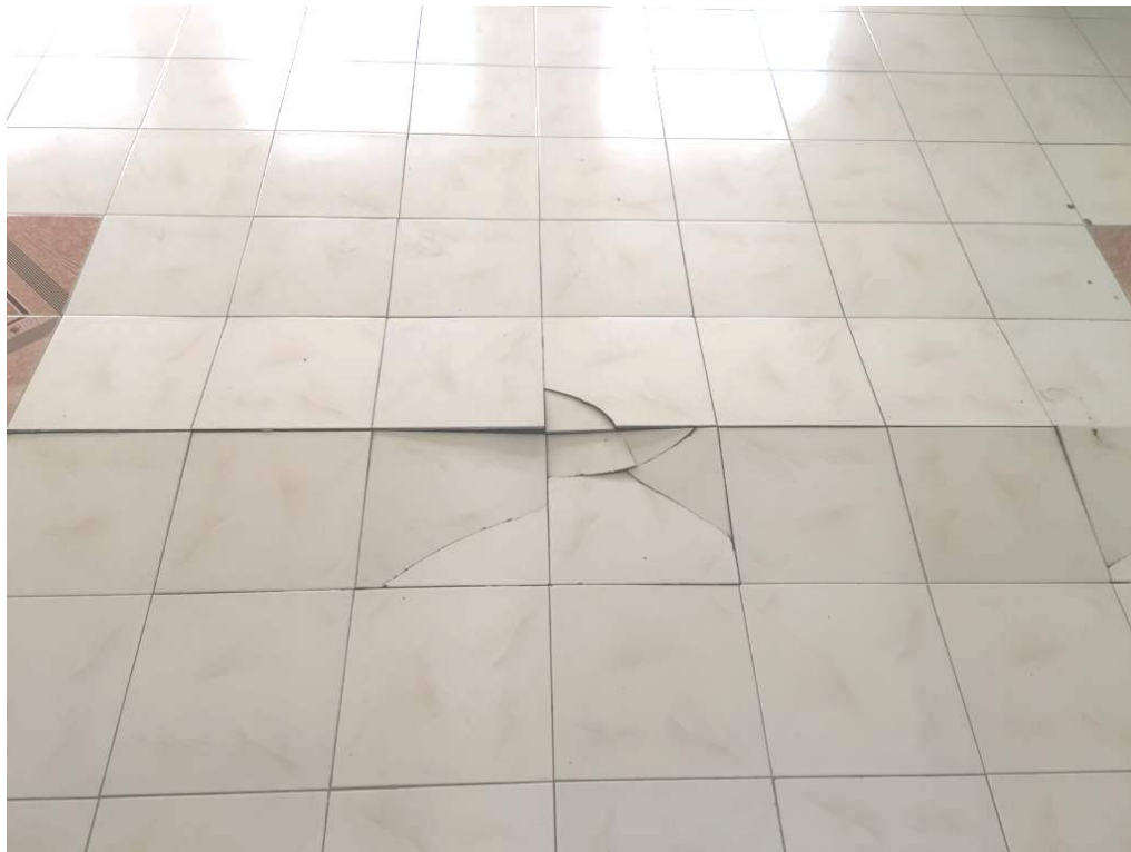
Εικόνα 63:Τοποθέτηση πλακιδίων πατώματος σε ανώμαλη επιφάνεια
