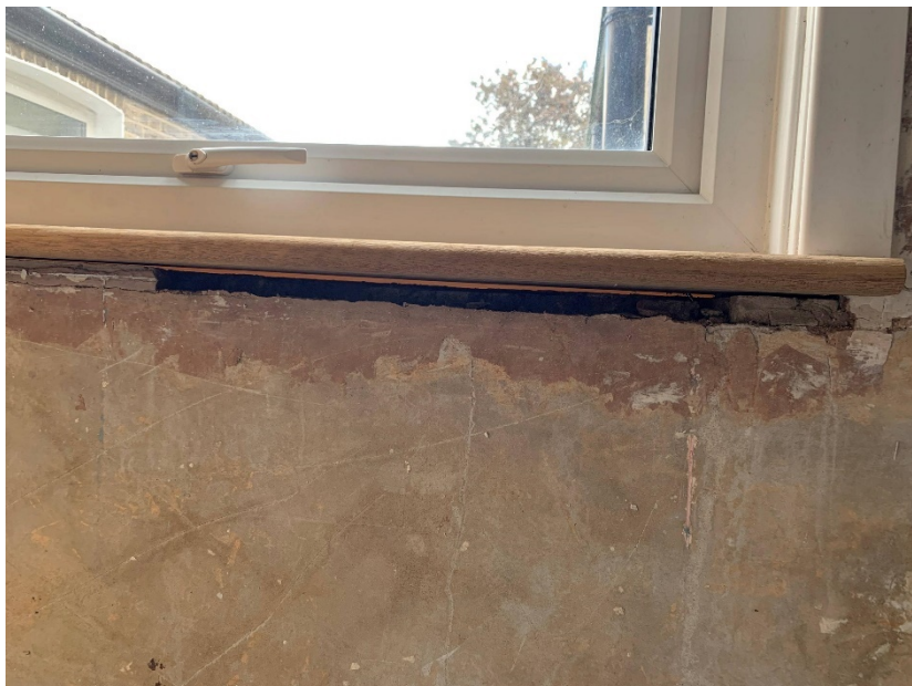
Εικόνα 69: Κενό από την διαφορά στο μέγεθος ανοίγματος και κουφώματος
