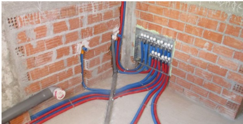
Εικόνα 61:Σύνδεση σωληνώσεων σε σύστημα θέρμανσης
