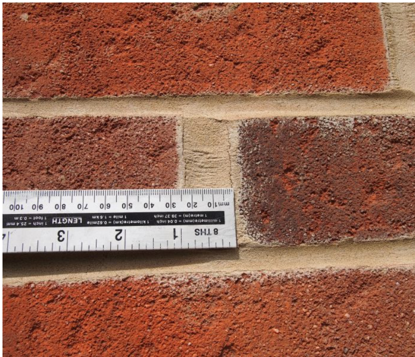
Εικόνα 38: Διαφοροποίηση στην τοποθέτηση των τούβλων στην τοιχοποιία
