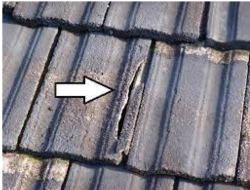
Εικόνα 52:Σπάσιμο κεραμιδιού
