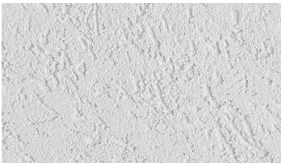
Εικόνα 40:Ανομοιομορφία σε σοβατισμένη επιφάνεια
