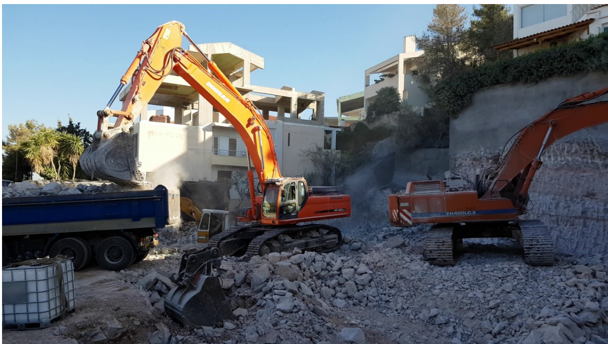
Εικόνα 6: Εκσκαφή σε βραχώδες έδαφος με χρήση τεχνικών μέσων
