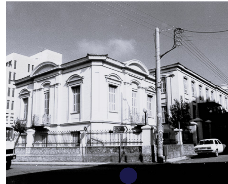
2.45 Εξωτερική άποψη του ξενώνα Παπαστράτου
