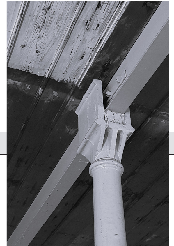
2.17 Μεταλλικά υποστυλώματα καπναποθήκης
