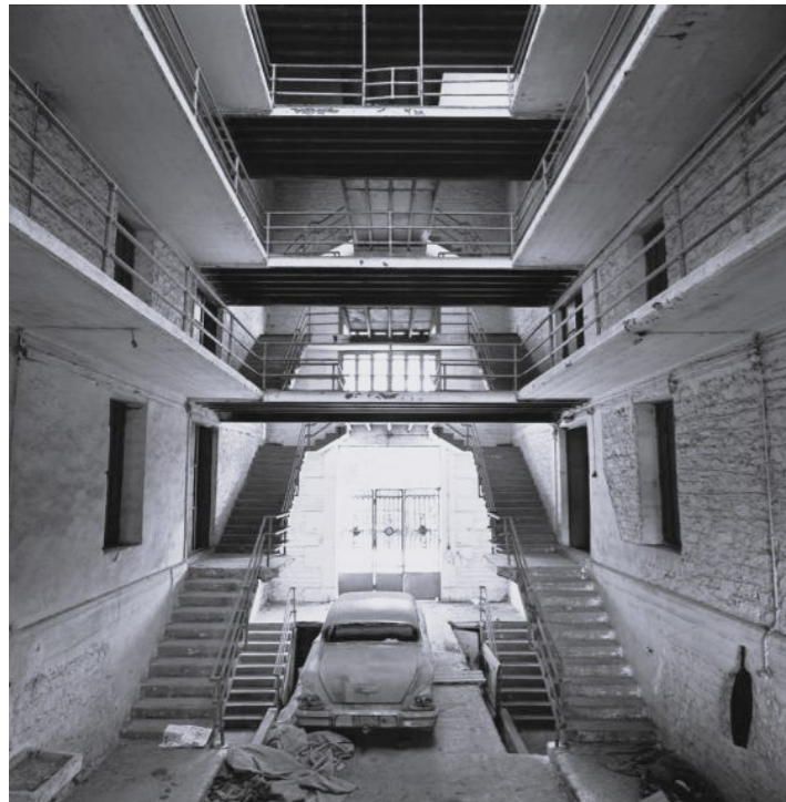
1.14 Κλιμακοστάσιο καπναποθήκης Παπαπέτρου
