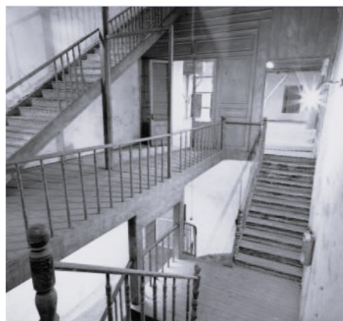
1.17 Κλιμακοστάσιο καπναποθήκης Παπαστράτου
