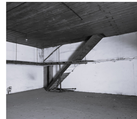
2.23 Εσωτερικός χώρος καπναποθήκης
