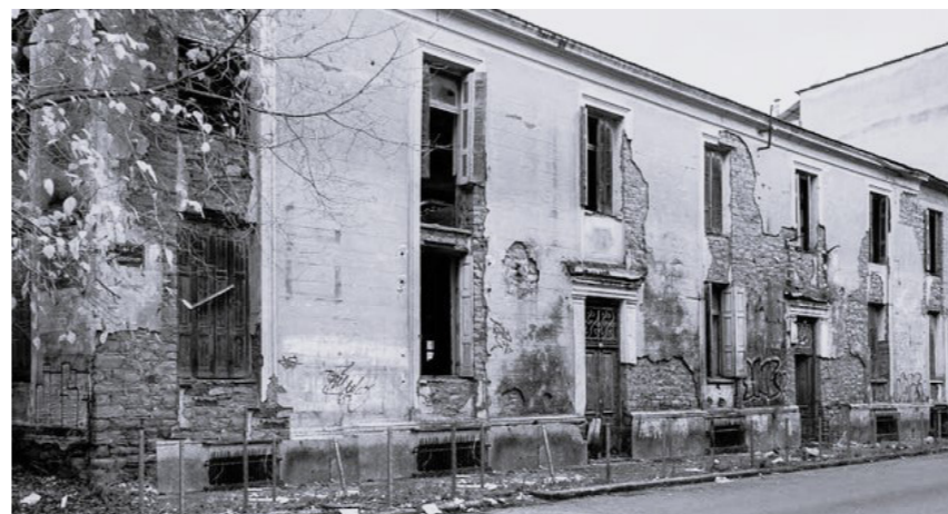
1.18 Όψη καπναποθήκης Ηλιού
