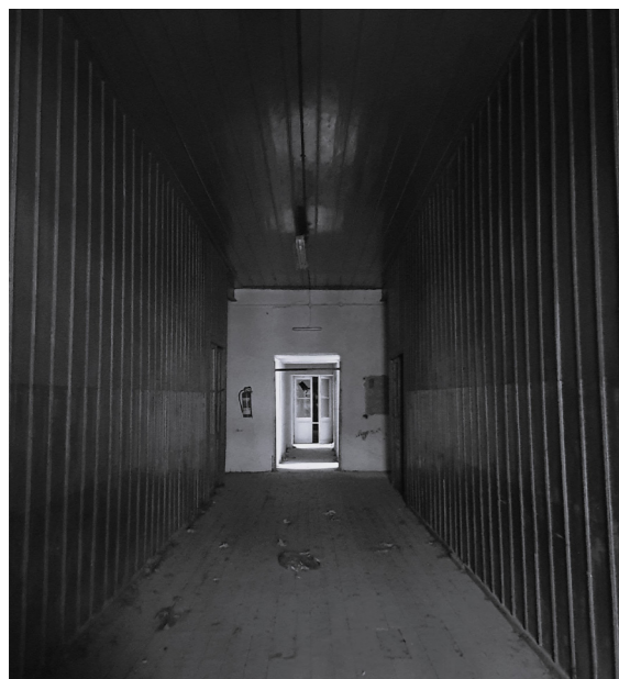
2.19 Διάδρομος καπναποθήκης με ξύλινη επένδυση
