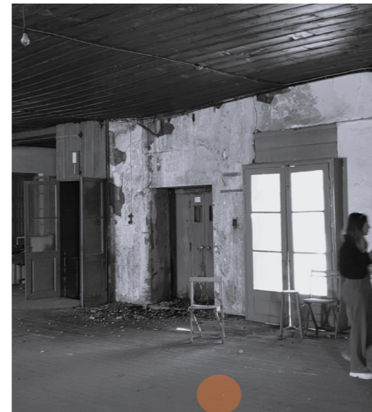
2.41 Εσωτερικός χώρος καπναποθήκης
