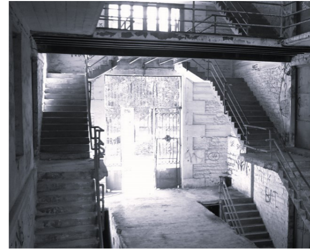
1.12 Κλιμακοστάσιο καπναποθήκης Παπαπέτρου
