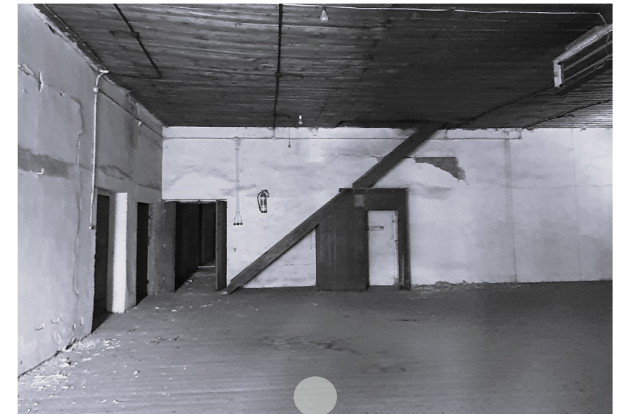
2.42 Εσωτερικός χώρος καπναποθήκης
