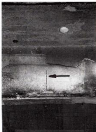
Απολείψεις επιχρισμάτων, έντονες καμπτικές και διατμητικές ρωγμές δοκών (στο άνοιγμα και στο στηρίγμα).
