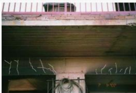
Χαρακτηριστικές πολλαπλές ρωγμές δοκών (καμπτικές και διατμητικές).
