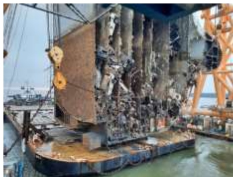
Εικ. 2.9. Κόψιμο πλοίου (Πηγή: https://www.iefimerida.gr/kosmos/fortigo-ploio-180-metron-ginetai-kommatia ).
