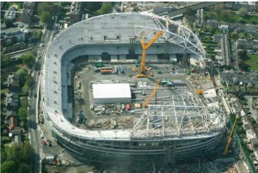
Τοποθέτηση ζευκτών (Peter Barrow Photography, i2-prod.dublinlive.ie)
