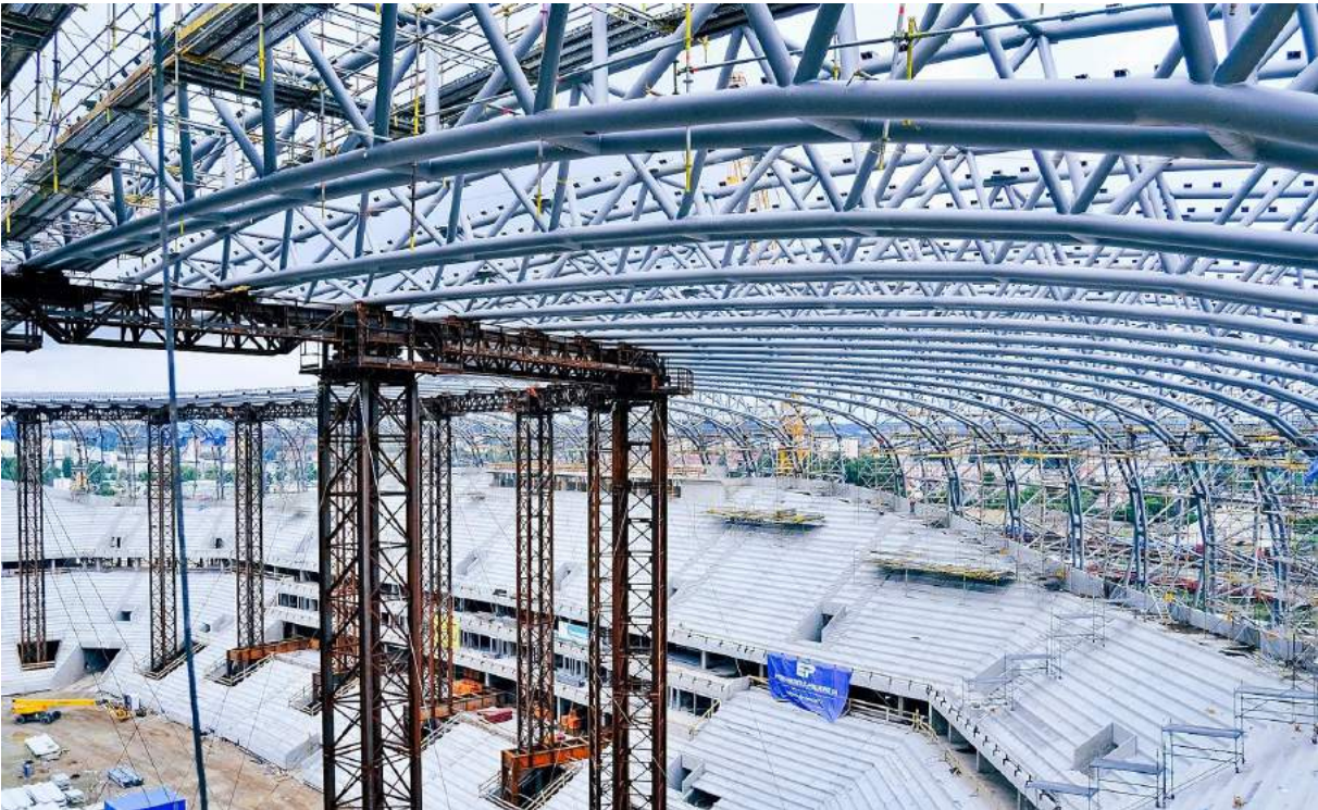
Προσωρινές στηρίξεις κατά τη διάρκεια τοποθέτησης των δοκών ( www.fotografbiznesowy.eu )
