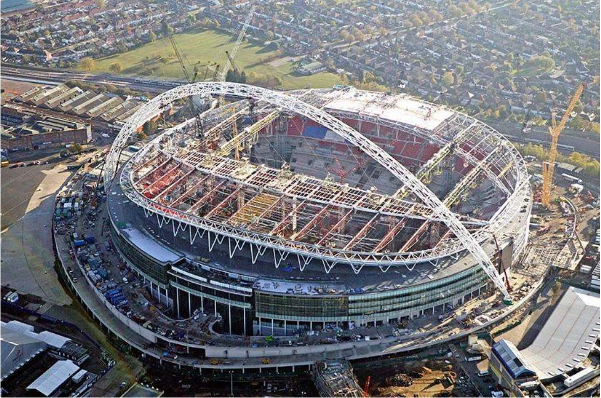
Κατασκευή οροφής ( www.tekla.com )
