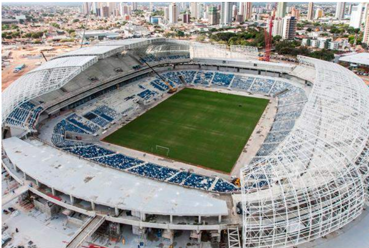
Εξωτερική όψη πλαισίων κατά τη φάση κατασκευής (files.structurae.net)
