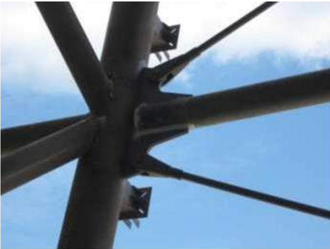
Συνδέσεις ακαμψίας με τη δοκό ( www.researchgate.net )
