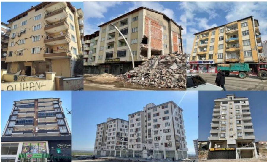
Εικόνα 2.7 Παραδείγματα κτιρίων με μέτριες βλάβες, Βαθμός 2 (Işık, E. et al,2023)
