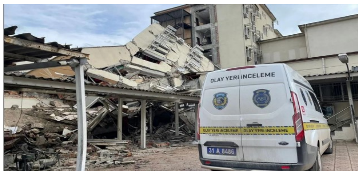
Εικόνα 2.27 Κατάρρευση νοσοκομείου Iskenderun State Hospital (Evangelia G. et al, 2023)
