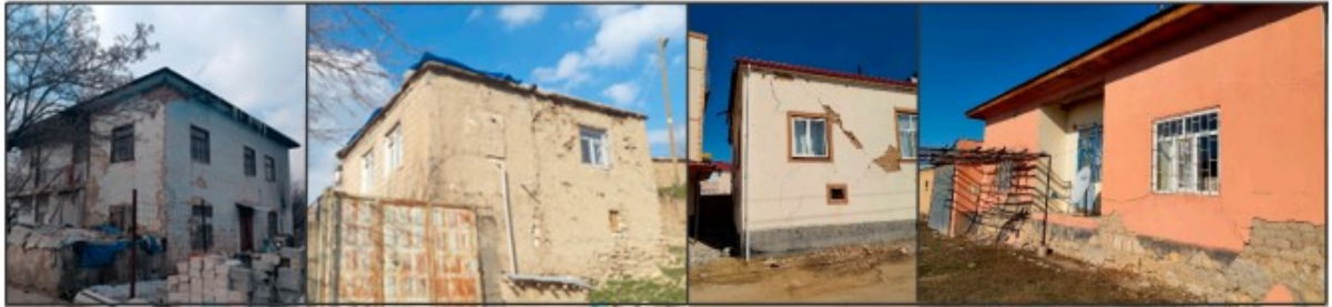
Εικόνα 2.22 Παραδείγματα κτιρίων από φέρουσα τοιχοποιία με αμελητέες ως ελαφρές βλάβες Βαθμός 1 (Ιşik, Ε.,2023)
