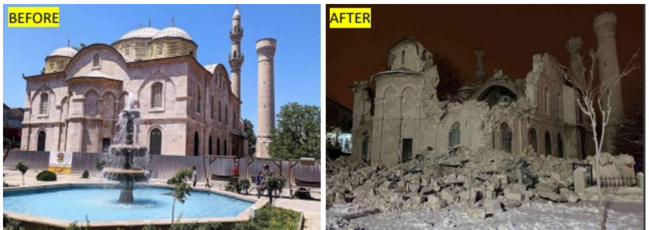
Εικόνα 2.31 Τζαμί Yeni Matalya πριν και μετά τον σεισμό (Evangelia G. et al, 2023)
