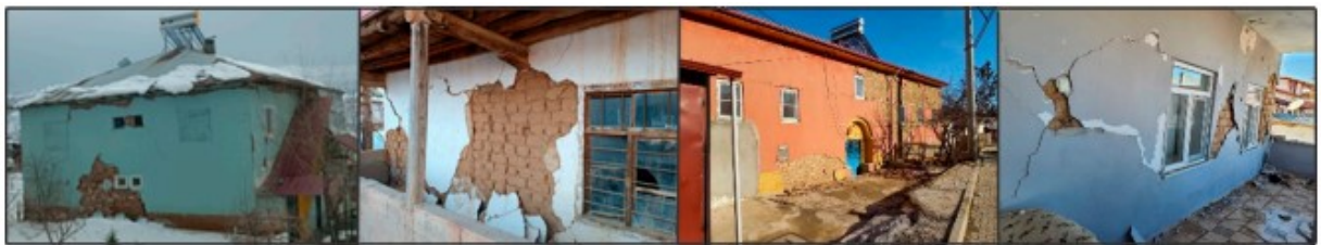
Εικόνα 2.23 Παραδείγματα κτιρίων από φέρουσα τοιχοποιία με μέτριες βλάβες Βαθμός 2 (Ιşik, Ε., 2023)
