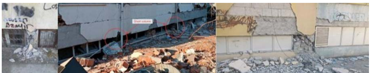
Εικόνα 2.2 Παραδείγματα αστοχιών λόγω κοντών υποστλωμάτων (Işık, E. et al,2023)
