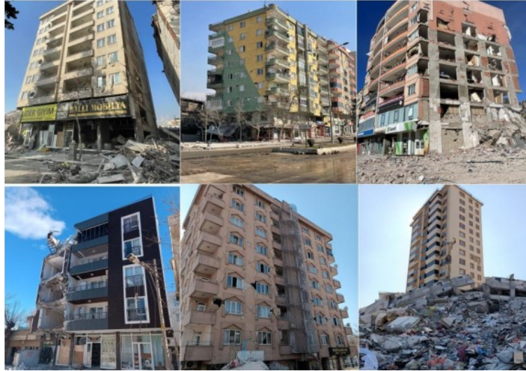
Εικόνα 2.8 Παραδείγματα κτιρίων με σημαντικές έως μεγάλες βλάβες, Βαθμός 3 (Işık, E. et al, 2023)
