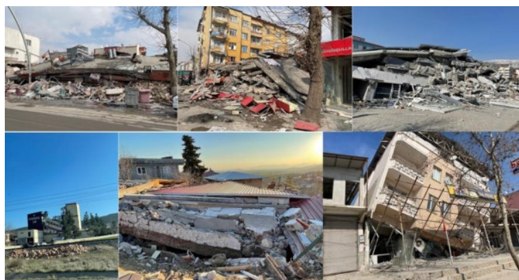
Εικόνα 2.10 Παραδείγματα κτιρίων με καταστροφικές βλάβες πολύ βαριές δομικές βλάβες, Βαθμός 5 (Işık, E. et al, 2023)
