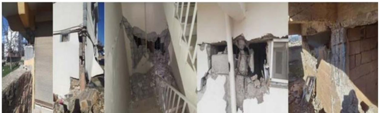
Εικόνα 2.5 Παραδείγματα αστοχιών σε επιμέρους δομικά στοιχεία (Işik, E. et al,2023)
