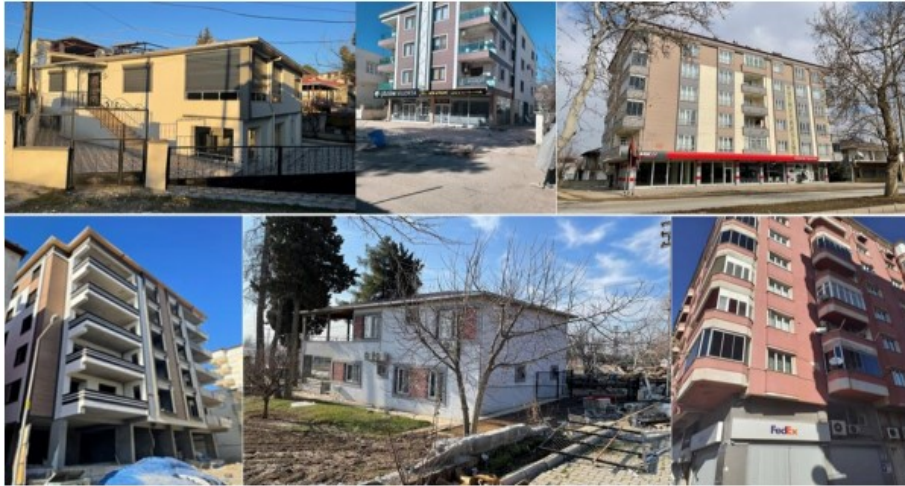
Εικόνα 2.6 Παραδείγματα κτιρίων με αμελητέες ως ελαφρές βλάβες, Βαθμός 1 (Işık, E. et al,2023)
