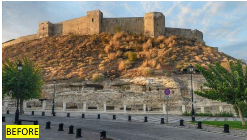
Εικόνα 2.33 Κάστρο Γκαζιαντέπ πριν τον σεισμό (Evangelia G. et al,2023)
