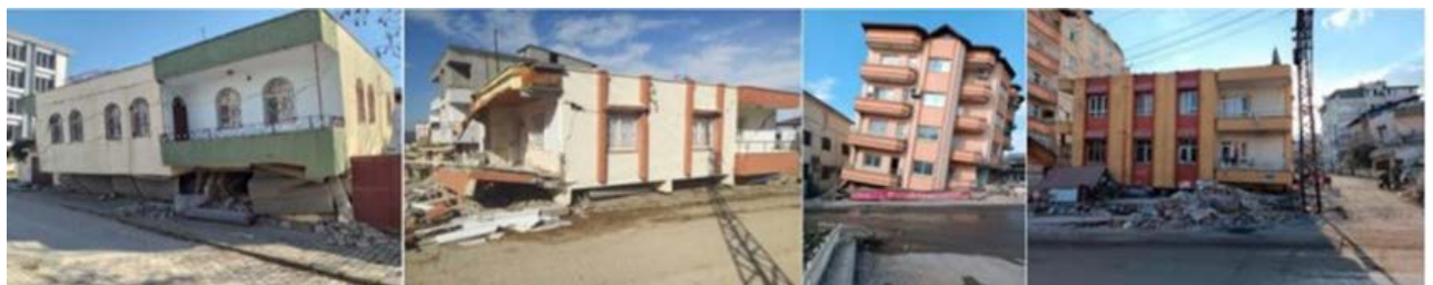
Εικόνα 2.1 Παραδείγματα αστοχιών κτιρίων λόγω ανοικτού ισόγειου ορόφου (Işık, E. et al,2023)
