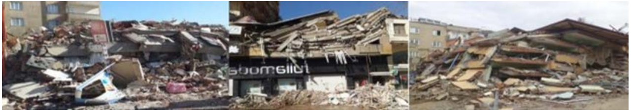
Εικόνα 2.3 Παραδείγματα ολικής κατάρρευσης κτιρίων λόγω ανεπαρκών πλαισίων (Işik, E. et al,2023)
