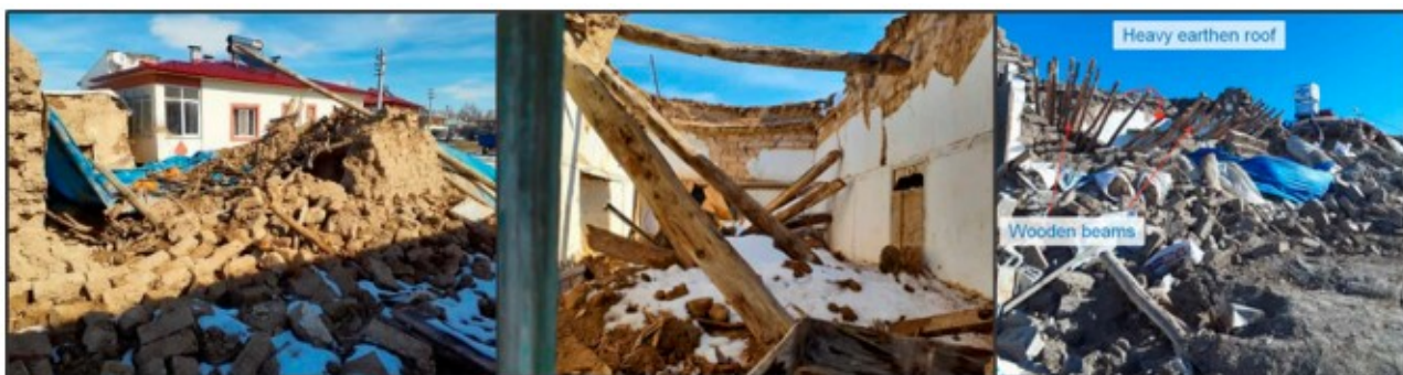
Εικόνα 2.14 Κατασκευές από πλινθοδομή όπου οι βαριές χωμάτινες στέγες κατέρρευσαν τελείως (Ιζικ, Ε.,2023)
