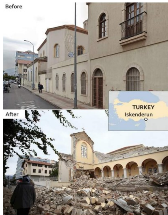
Εικόνα 2.28 Η εκκλησία της Iskenderun πριν και μετά τον σεισμό (Evangelia G. et al, 2023)
