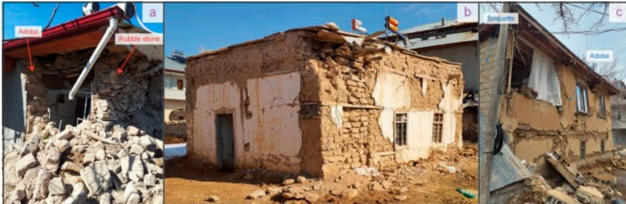
Εικόνα 2.13 Βλάβες σε κατασκευές από φέρουσα τοιχοποιία με διαφορετικούς τύπους λιθοσωμάτων (Ιζικ, Ε., 2023)
