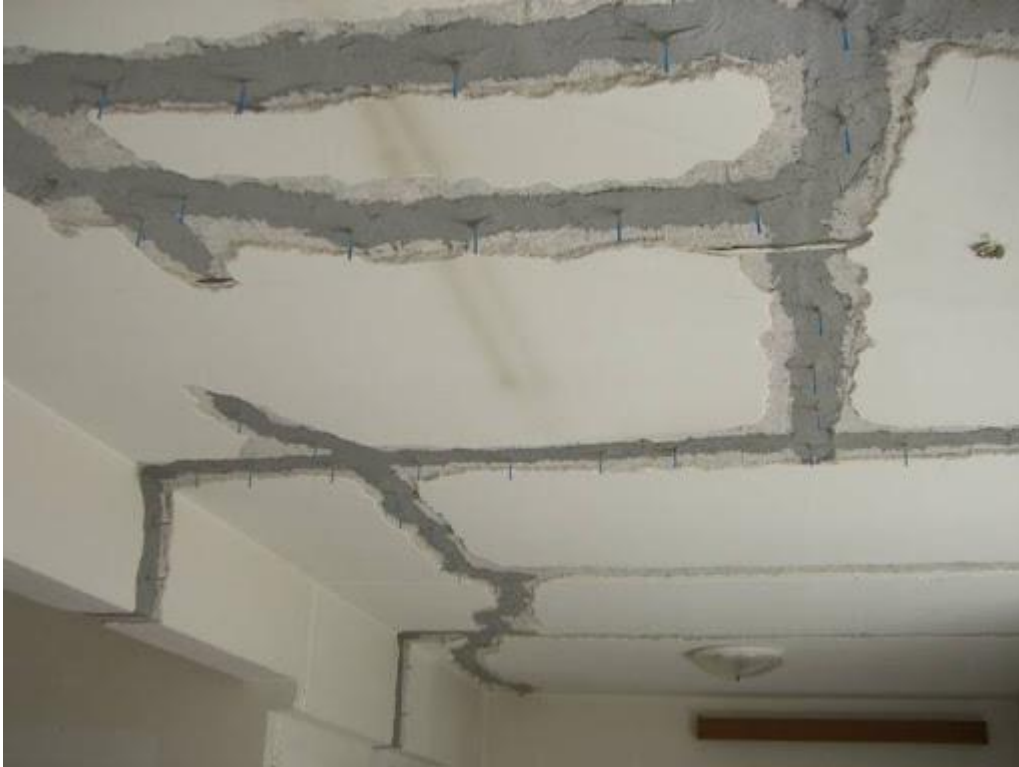
Ρητινενέσεις για συγκόλληση ρωγμών σε δοκό.
