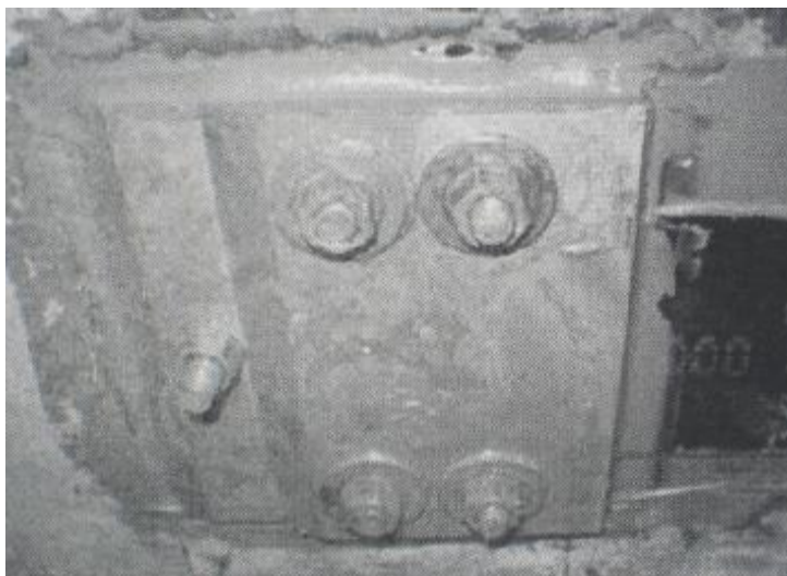
Εικόνα 7.10 Στην Εικόνα απεικονίζεται μία δοκός όπου γίνεται εφαρμογή της Αγκύρωσης, Εικόνα από Πετροπούλου Γεωργία, Τσαγγούρη Ελένη <<Μελέτη Αγκύρωσης ΙΟΠ (FRP) σε Ενισχύσεις Δοκών>>, 16 ο Φοιτητικό Συνέδριο Επισκευές των Κατασκευών
