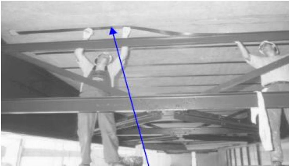
Εικόνα 5.27 Εικόνα που απεικονίζει την Επικόλληση Ελασμάτων για την Καμπτική Ενίσχυση Καταστρώματος Γέφυρας, Εικόνα από Αθ.Χ.Τριαντύφυλλου Ενισχύσεις Κατασκευών Σκυροδέματος και Τοιχοποιίας με Σύνθετα Υλικά
