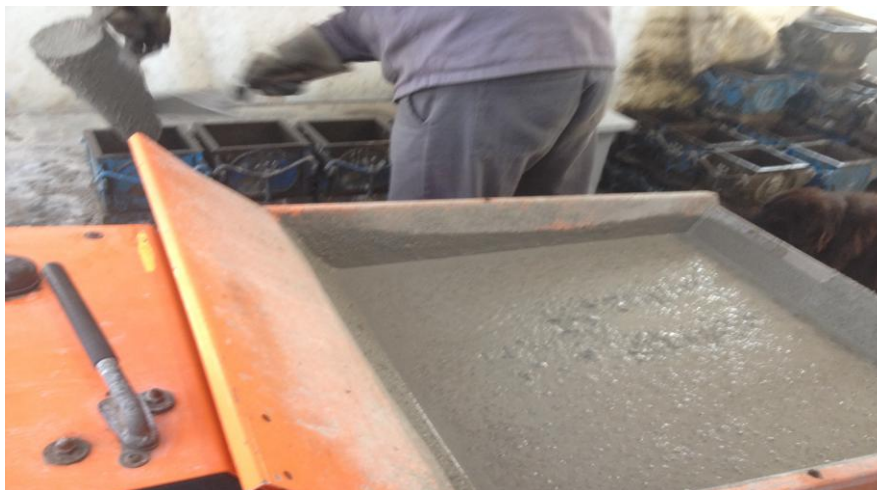
Εικόνα 14.2 Στις Εικόνες απεικονίζονται η Εκπαιδευτική Επίσκεψη στις Εγκαταστάσεις Παραγωγής Σκυροδέματος INTERMPIETON Α.Ε (Μεταμόρφωση Αττικής ) εσωτερικά στην μηχανή ανάδευσης του Τσιμέντου από την Εταιρεία ΤΙΤΑΝ και στο Εργαστήριο Ποιοτικού Ελέγχου Σκυροδέματος με την Τοποθέτηση του Σκυροδέματος στα Καλούπια Διαστάσεων 15*15*15 (Γκερδούκη Χριστίνα 14/10/2018).
