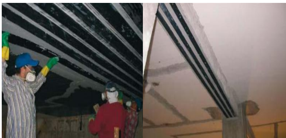
Εικόνα 5.22 Τοποθέτηση Στρώσεων Ινοπλισμένου Πολυμερούς στην Επιφάνεια του Δομικού Στοιχείου, Εικόνα από το 23 ο Φοιτητικό Συνέδριο Επισκευές των Κατασκευών Πάτρα Φεβρουάριος 2017 Κατσαμάκας Αντώνης, Μυλωνάς Αντώνης-Ιωάννης
