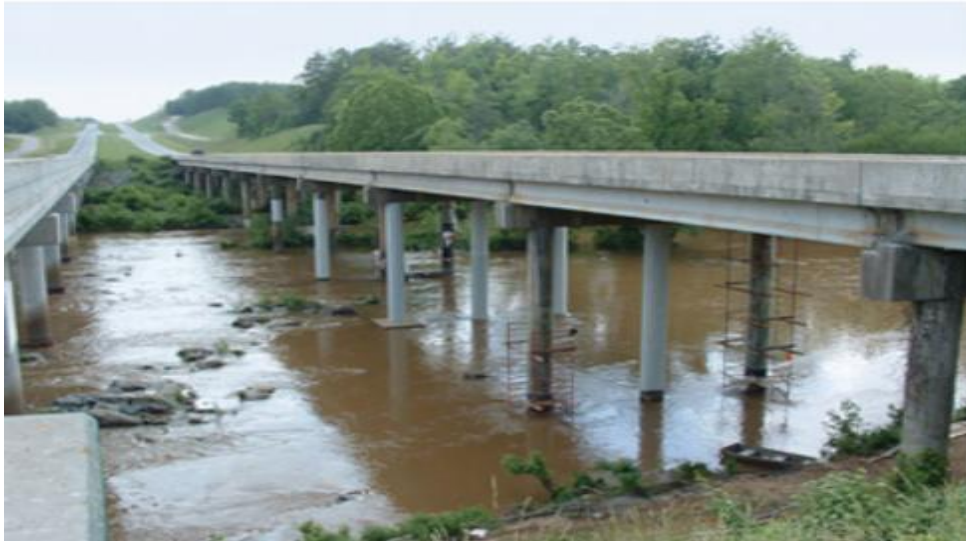
Εικόνα 5.15 Η μία όψη της γέφυρας Chatham County Bridge όπου βρίσκεται στα τελικά στάδια στάδια της περικάλυψης της με την χρήση των ινοπλισμένων πολυμερών και τα στάδια του βαψίματος. Το ανοιχτό γκρι χρώμα είναι η ολοκληρωμένη εργασία, Εικόνα από το 13 ο Φοιτητικό Συνέδριο Επισκευές των Κατασκευών Πάτρα Φεβρουάριος 2007 Παπασεραφειμ Αναστασία
