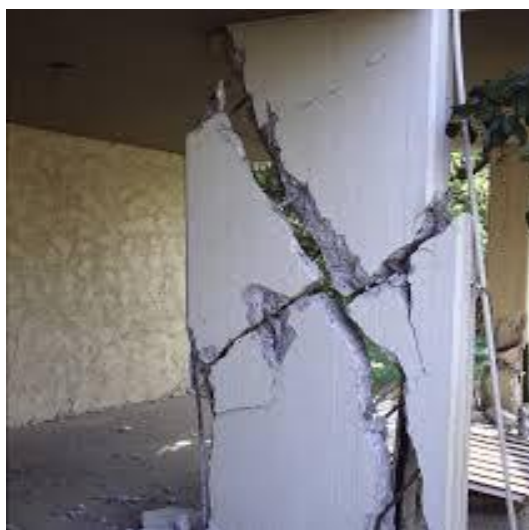
Εικόνα 3.3 Διατμητική Αστοχία Τοιχώματος με χιαστή μορφή ρηγμάτωσης, Εικόνα από Γιανόπουλος Ιωάννης Βλάβες από τον Σεισμό της Αθήνας(1999)
