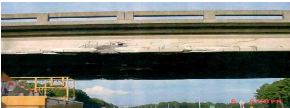
Εικόνα 5.15 Η μία όψη της γέφυρας Chatham County Bridge όπου βρίσκεται στα τελικά στάδια στάδια της περικάλυψης της με την χρήση των ινοπλισμένων πολυμερών και τα στάδια του βαψίματος. Το ανοιχτό γκρι χρώμα είναι η ολοκληρωμένη εργασία, Εικόνα από το 13 ο Φοιτητικό Συνέδριο Επισκευές των Κατασκευών Πάτρα Φεβρουάριος 2007 Παπασεραφειμ Αναστασία
