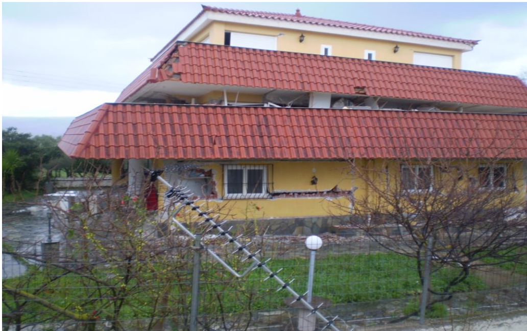
Εικόνα 2.5 Μεγάλο κατασκευαστικό λάθος σε τριώροφο κτήριο,κατέρρευσε ο πρώτος όροφος μη αντέχοντας το μεγάλο σεισμικό φορτίο (Εικόνα από την εφημερίδα Βήμα για το Σεισμό της Κεφαλονιάς)
