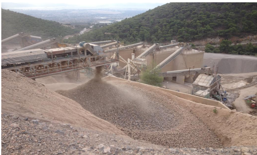
Εικόνα 15.1 Στις Εικόνες απεικονίζονται το Εργαστήριο Ποιοτικού Ελέγχου Αδρανών Υλικών του Λατομείου Ξηρορέματος ως Υπεύθυνη Εργαστηρίου στην Διάρκεια της Πρακτικής Άσκησης και την Μονάδα Διαχωρισμού των Αδρανών Υλικών (Γκερδούκη Χριστίνα 14/10/2018).
