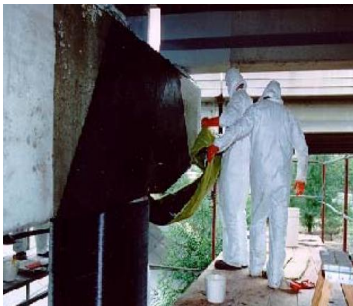
Εικόνα 6.1 Ενίσχυση Υποστυλώματος με χρήση Μανδύα από FRP,Εικόνα από Ρέζου
