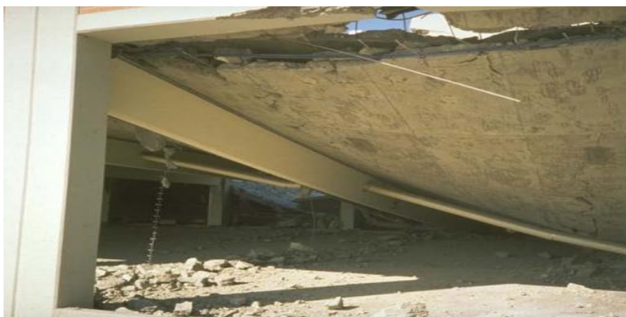
Εικόνα 3.6 Βλάβη σε πλάκες σε χώρο στάθμευσης όπου η πλάκα ξεκόλλησε από το πλαίσιο, Σεισμός Northridge 1994, Εικόνα από Γιάννακα Νικόλαο Διδάσκων Επισκευές και Ενισχύσεις Τεί Κρήτης
