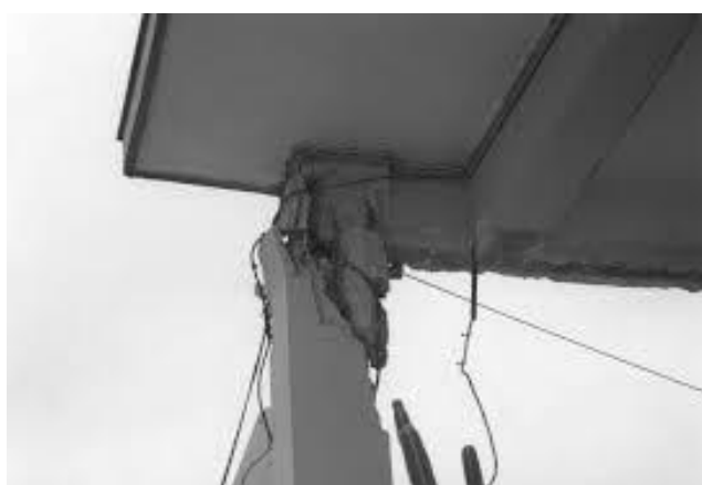
3.5 Βλάβη σε εξωτερικό γωνιακό κόμβο με συντριβή σκυροδέματος στην κάτω παρειά και λύγισμα των διαμήκων οπλισμών των υποστυλωμάτων, Εικόνα από Γαρυφάλη Άγγελος 6 ο Φοιτητικό Συνέδριο <<Επισκευές Κατασκευών 2000>> Φεβρουάριος 2000
