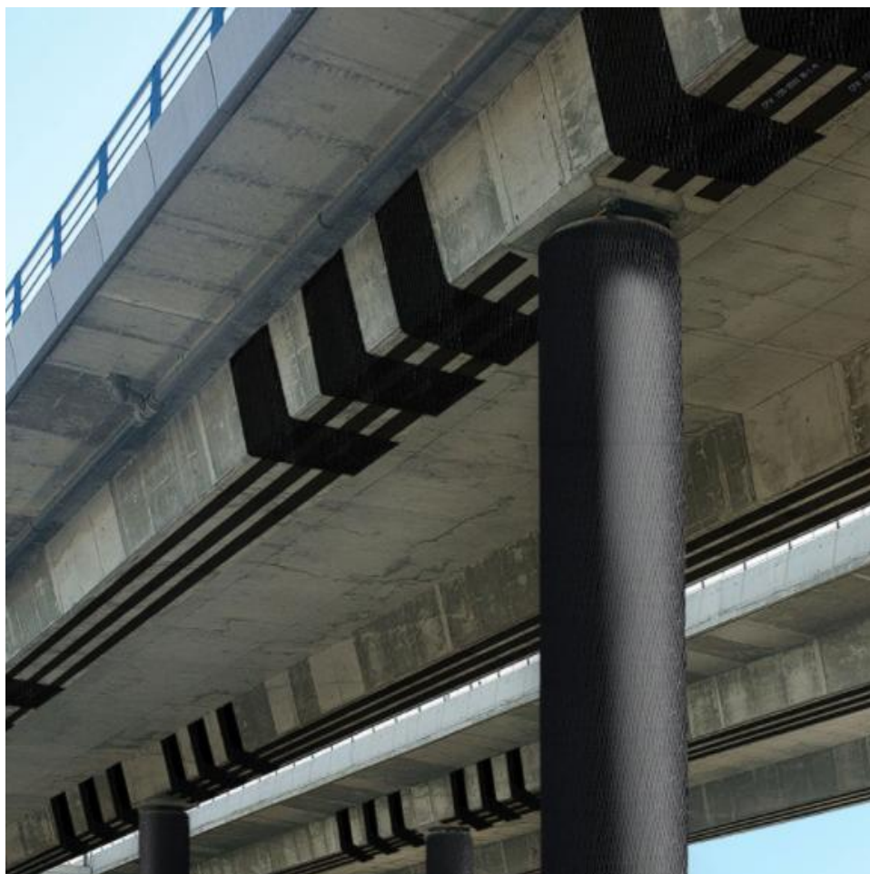
Εικόνα 8.20 Στην εικόνα απεικονίζεται το Ανθρακούφασμα FRP για την Ενίσχυση Δομικών Στοιχείων Γέφυρας, Εικόνα από Ιστοσελίδα Εταιρείας Ενισχύσεων Simpson Strong-Tie Composite Strengthening Systems (CSS).
