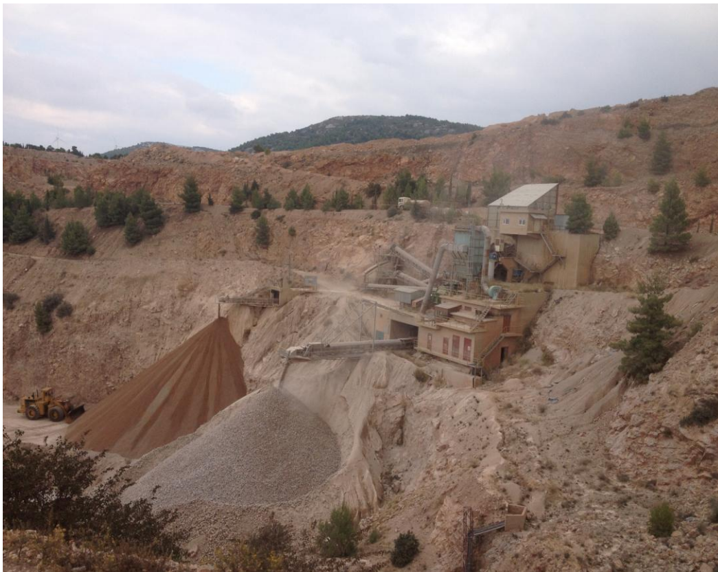
Εικόνα 15.2 Στις Εικόνες απεικονίζονται οι Εγκαταστάσεις Παραγωγής Αδρανών Υλικών του Λατομείου Ξηρορέματος ως Υπεύθυνη Εργαστηρίου στην Διάρκεια της Πρακτικής Άσκησης και την Μονάδα Διαχωρισμού των Αδρανών Υλικών (Γκερδούκη Χριστίνα 14/10/2018).
