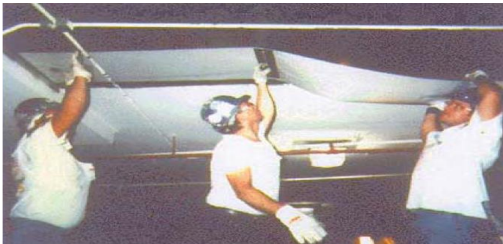
Εικόνα 5.23 Στάδιο Πρώτο Εφαρμογής Σύνθετων Υλικών όπου Ξετυλίζουν και Τεντώνουν το Νήμα από FRP,Εικόνα από Θεοδοδωρόπουλο Χρήστο Ενίσχυση Δοκών με Ινοπλισμένα Πολυμερή Πλαστικά FRP
