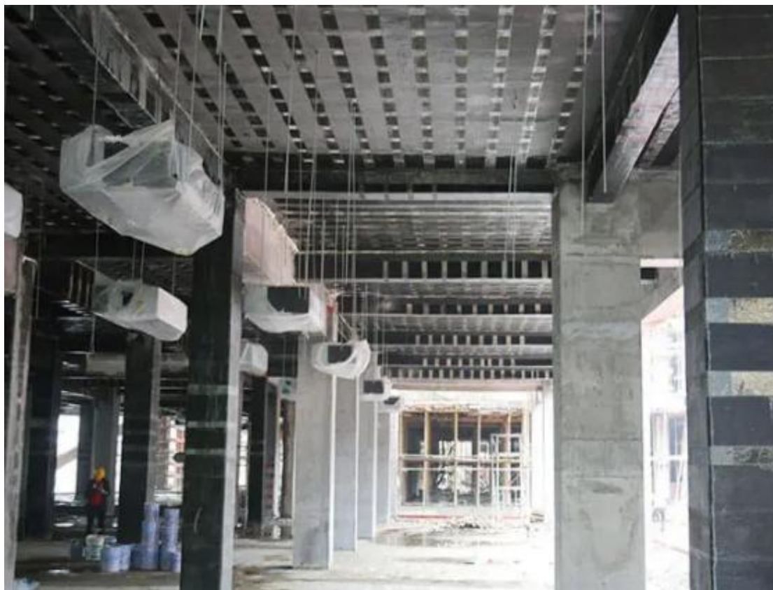
Εικόνα 8.19 Στην εικόνα απεικονίζεται το Ανθρακοϋφασμα FRP για την Ενίσχυση Δομικών Στοιχείων Υποστυλωμάτων, Δοκών και Πλακών της Κατασκευής, Εικόνα από Ιστοσελίδα Εταιρείας Ενισχύσεων ORSE.
