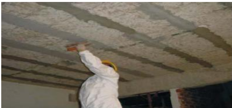
Εικόνα 5.21 Επάλειψη Επιφάνειας Δομικού Στοιχείου με Εποξική Ρητίνη, Εικόνα από το 23 ο Φοιτητικό Συνέδριο Επισκευές των Κατασκευών Πάτρα Φεβρουάριος 2017 Κατσαμάκας Αντώνης, Μυλωνάς Αντώνης-Ιωάννης
