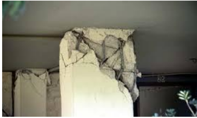
Εικόνα 3.1 Διατμητική Αστοχία Υποστυλώματος με θραύση λεπτών και αραιών συνδετήρων και λυγισμό ράβδων, Εικόνα από Γιανόπουλους Ιωάννης Βλάβες από τον Σεισμό της Αθήνας (1999)
