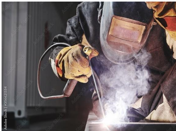
Εικόνα 109 Διαδικασία Συγκόλλησης Μεταλλικών Κουφωμάτων - Ηλεκτροσυγκόλληση με Ηλεκτρόδιο
