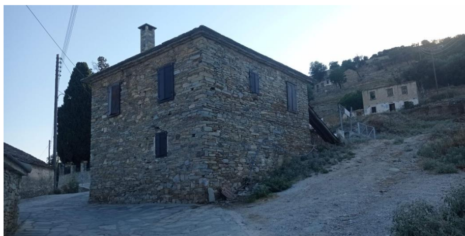
Σχήμα 5.7 Ανατολική και βόρεια όψη, θέση λήψης 2
