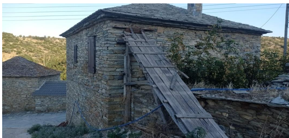
Σχήμα 5.8 Δυτική και βόρεια όψη, θέση λήψης 3
