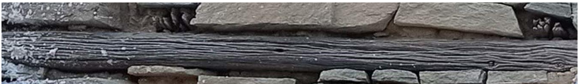
Σχήμα 5.11 Όψη της ξυλοδεσιάς στην στάθμη του δαπέδου του α ορόφου.
