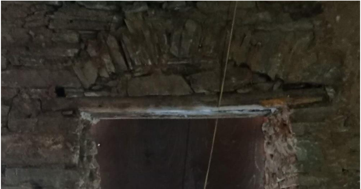
Σχήμα 5.12 Όψη ελκυστήρων πάνω από τα ανοίγματα.
