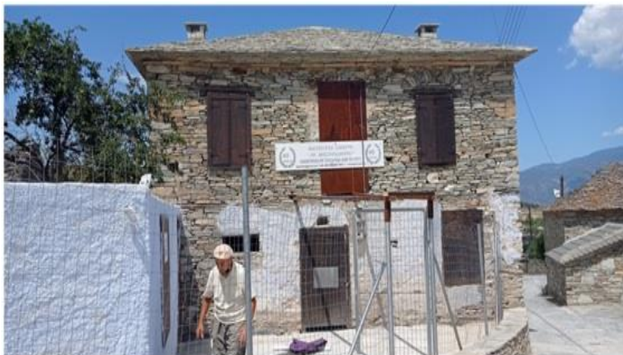
Σχήμα 5.6 Νότια όψη-πρόσοψη, θέση λήψης 1
