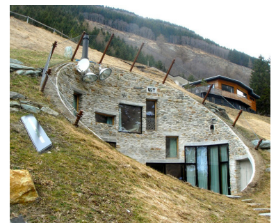
Εικ. 53_ Ενσωμάτωση της κατοικίας στο τοπίο, Villa Vals, Ελβετία, Bjarne Mastenbroek - Christian Müller, 2009
