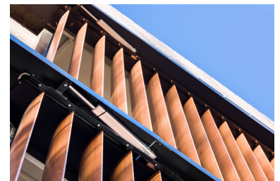
Εικ. 8α, 8β_ α) Σταθερές περσίδες (πάνω), β) Κινητές περσίδες (κάτω)
