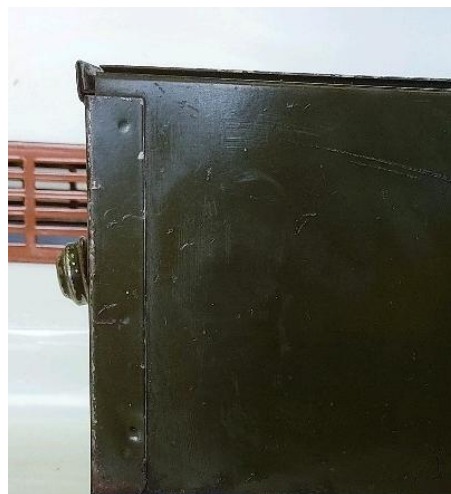
Εικόνα 2.3.2: Λεπτομέρεια από τα σημάδια της διαδικασίας :pressjoining: στο συρτάρι του αντικειμένου Φωτογραφία των Ιστορικό Αρχείο ΕΥΔΑΠ- Εργαστήριο Μεταλλικών Αντικειμένων(ΠΑΔΑ), Ροπόκη Αρτεμης- Χαντζιάρα Αρχοντούλα ©
