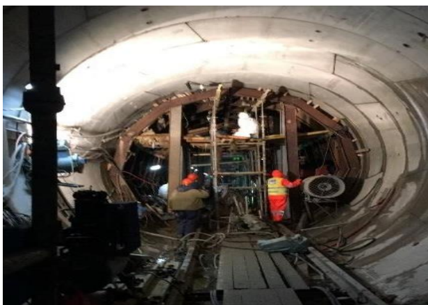
Εικόνα 1.11 Παράδειγμα ατυχήματος: Καθιζήσεις της τμηματικής επένδυσης που προκαλούνται από παρουσία φτωχού στρώματος εδάφους κάτω από τη σήραγγα (Khokhlov, 2021).
