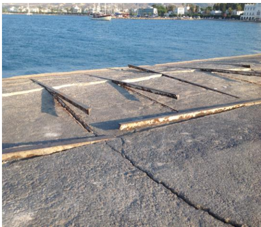
Εικόνα 3 : Ενδεικτικές ζημιές από το σεισμό στο λιμένα Κω (Τεχνική Έκθεση, 2018, Ανάδ. Μ. Φράγκου)
