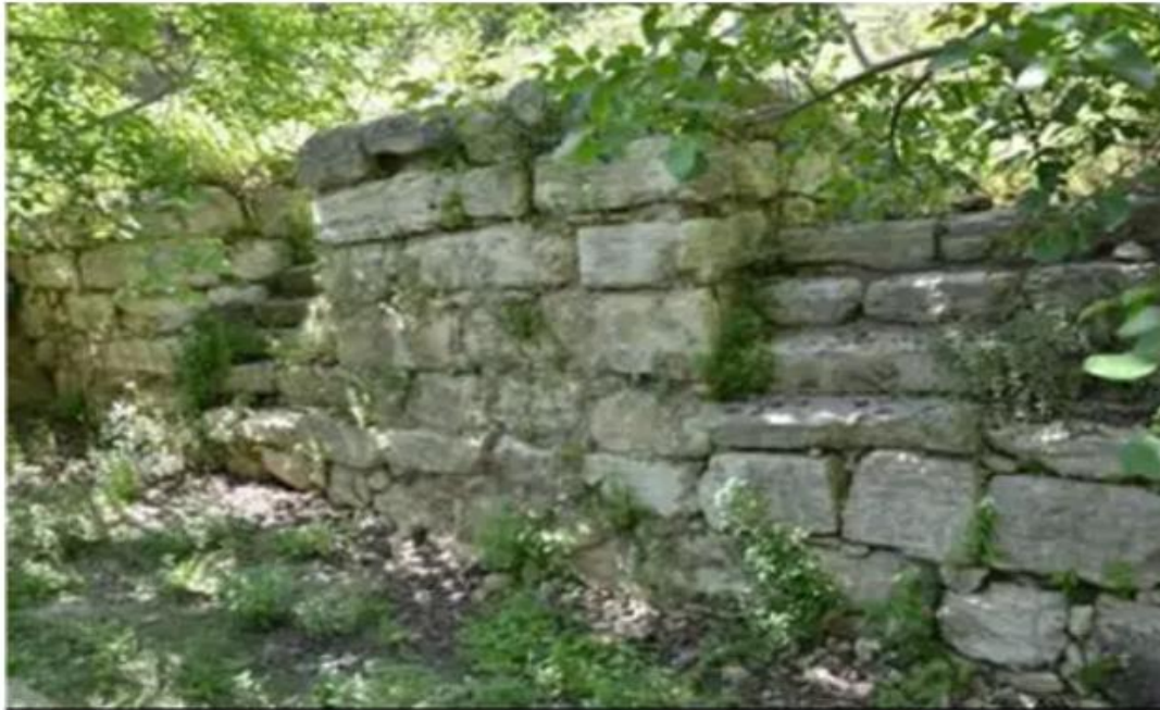
Εικόνα 16: Τμήμα του αρχικού τοίχου της ‘Μηνωικής Οδογέφυρας’ με τα βαθμιδωτά ανοίγματα. (Φωτογραφίες Angelakis). Πηγή: https://link.springer.com/article/10.1007/s11069-020-03898-w
