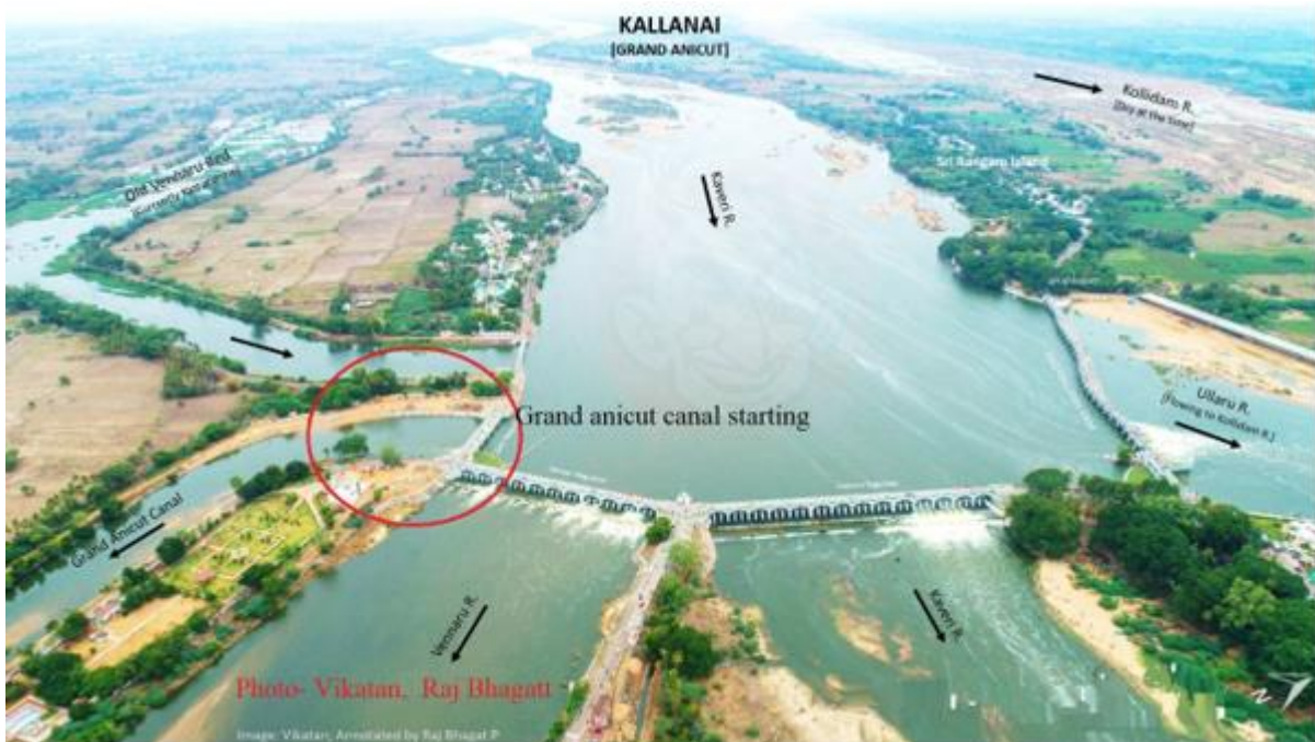
Εικόνα 36 : Φράγμα Kallanai, όπως ανακατασκευάστηκε από τον Krishnan από περιγραφές γύρω στο 1777. Ευγενική προσφορά του Chitra Krishnan, «Tank and Anicut Irrigation Systems: An Engineering Analysis» (Ph.D. diss., Indian Institute of Technology, 2003). Πηγή φωτογραφίας: Grand Anicut Canal (Raman, 2004), και Φράγμα Kallanai (Bijker, 2007).
