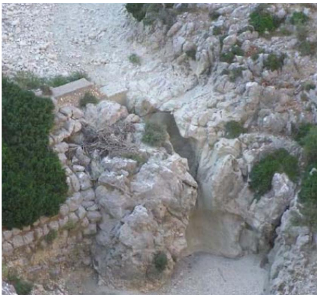
Εικόνα 25: Φυσικός υπερχειλιστής στο αριστερό αντέρεισμα. Πηγή: (Γρίβα, 2008).
