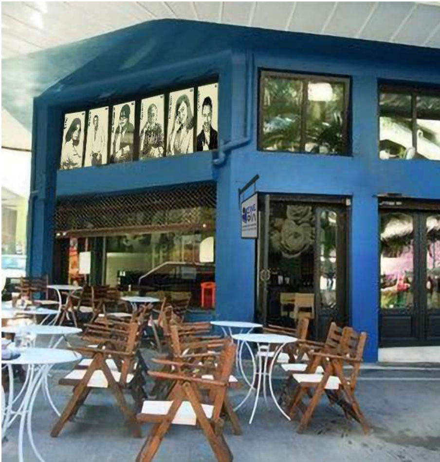
εικ. 83 | Εξωτερική όψη της λέσχης-καφέ με τις αφίσες και την ταμπέλα τοποθετημένα
