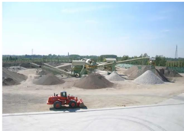
Εικόνα 3.3 , μονάδα επεξεργασίας αδρανών υλικών , Πηγή : ANPAR 2008
