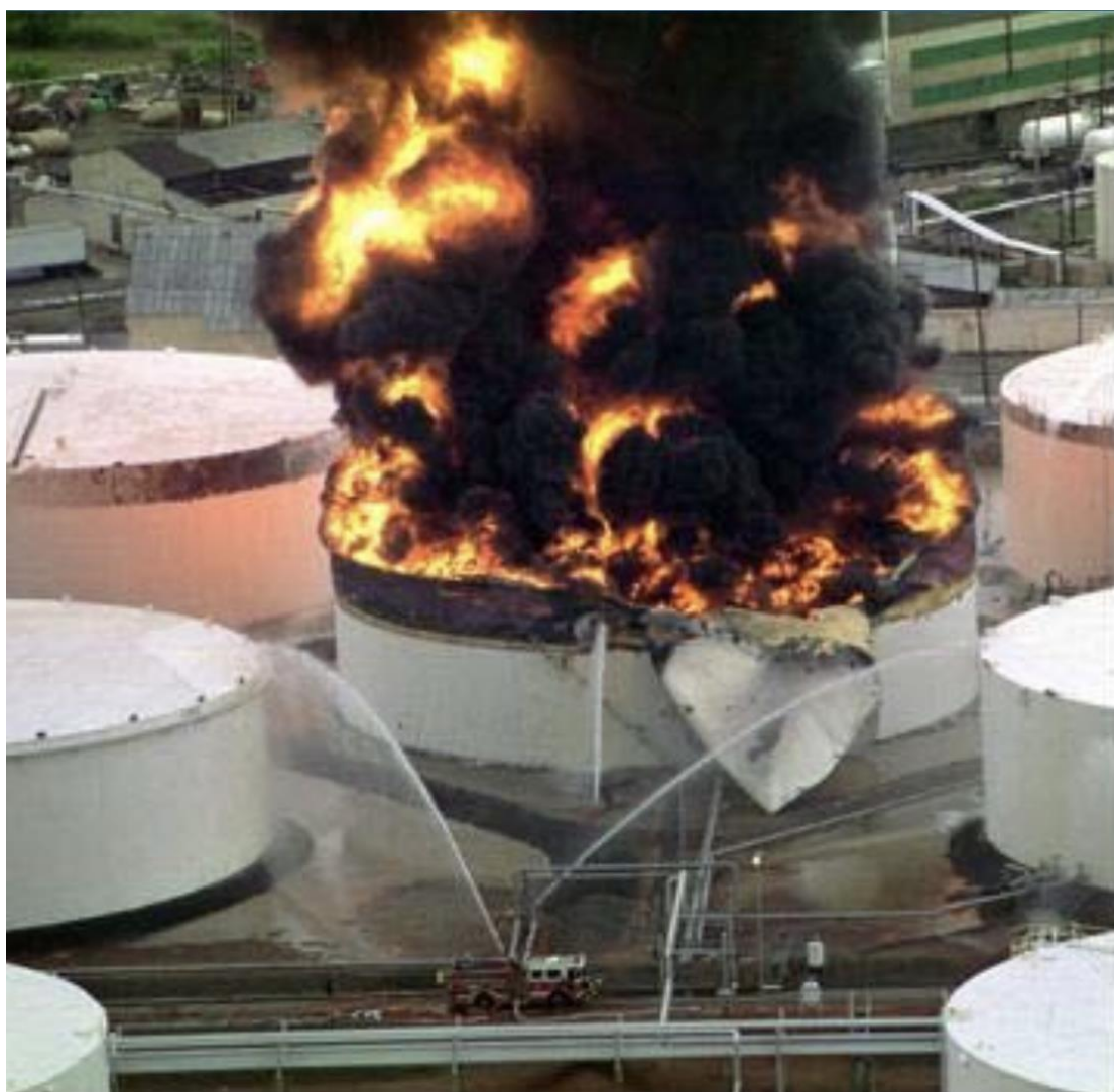
Σχήμα 17: Φωτιά Οροφής Δεξαμενής Εύφλεκτου Υγρού
