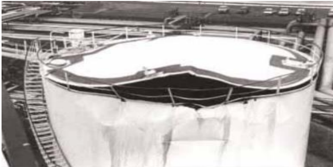
Σχήμα 5: Λειτουργία Ευάλωτης Αρθρώσεως Δεξαμενής
