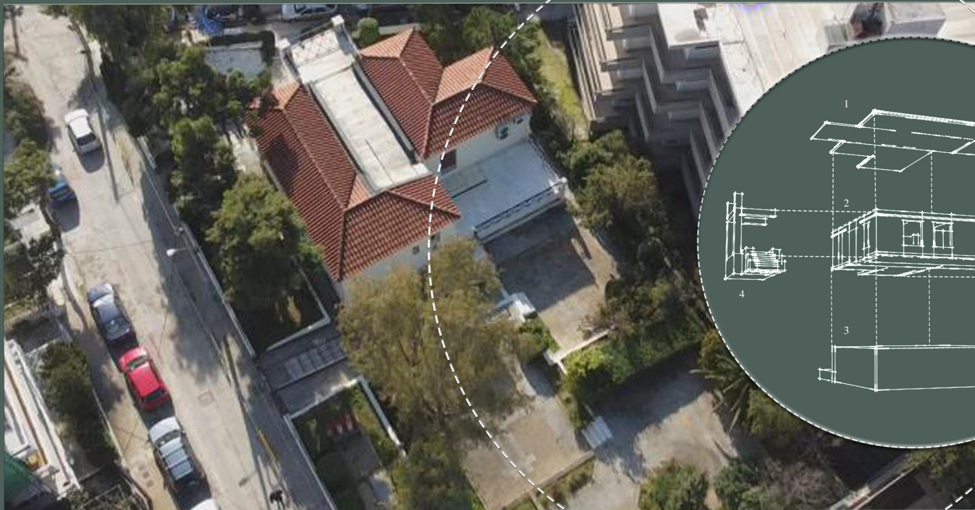
Πανοραμική φωτογραφία κτιρίου «Βίλλα Στέλλα» | tasosbmd
