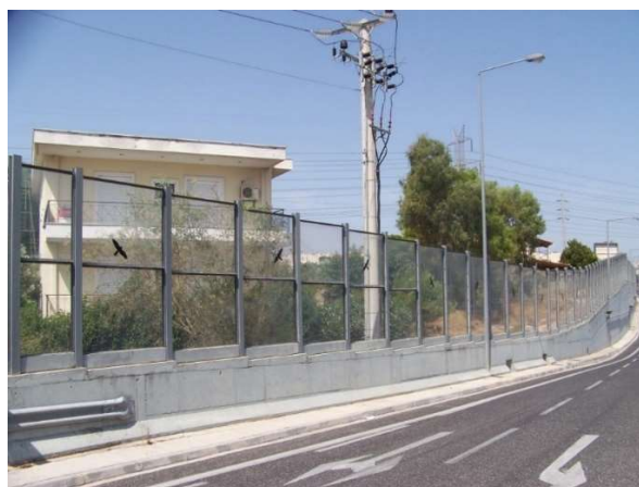
Εικόνα 2.9 Εγκατάσταση διάφανων ηχοπετασμάτων σε αυτοκινητόδρομο στην Αττική, Ελλάδα [132]
