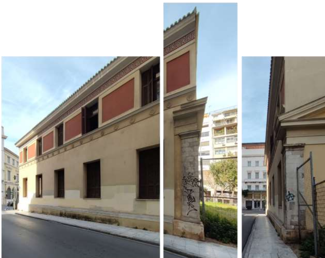
Εικόνα 64,65,66. Φωτογραφίες όψης οδού Αρσάκη.
