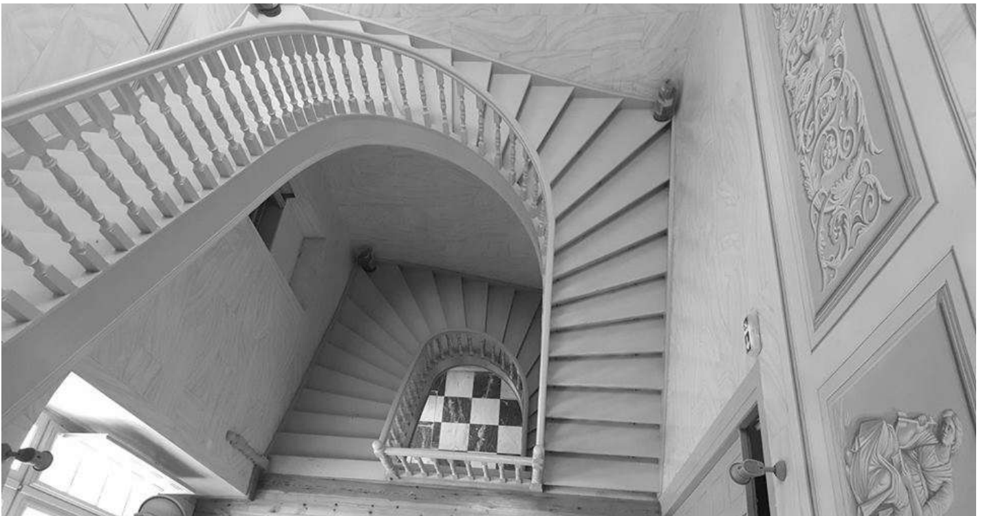
Εικόνα 19. Άποψη του ξύλινου κλιμακοστάσιου του αρχοντικού Βελισσαρόπουλου. Σύρος.
