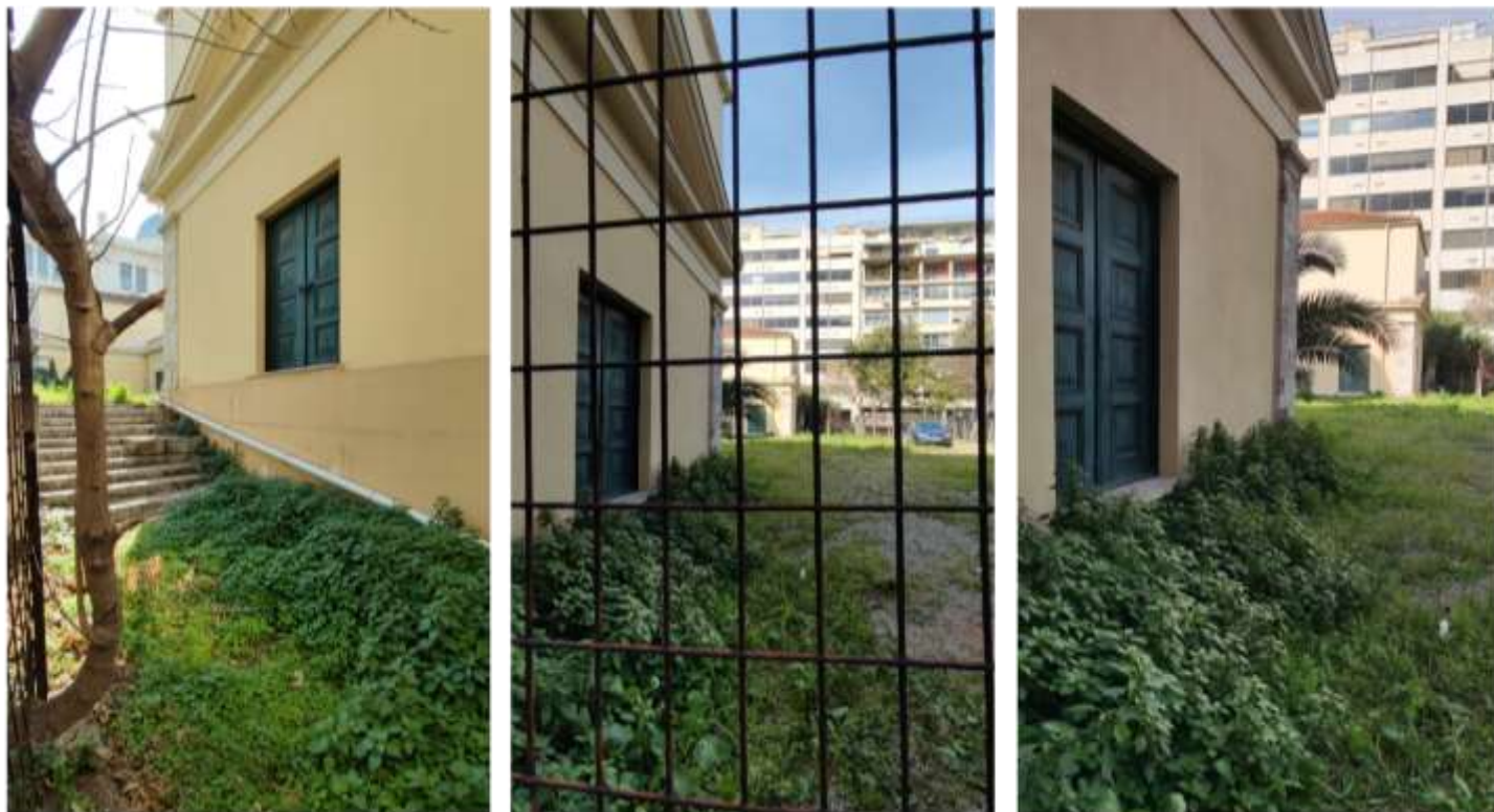
Εικόνες 61,62,63. Φωτογραφίες πλαϊνών εισόδων όψης πλατείας.
