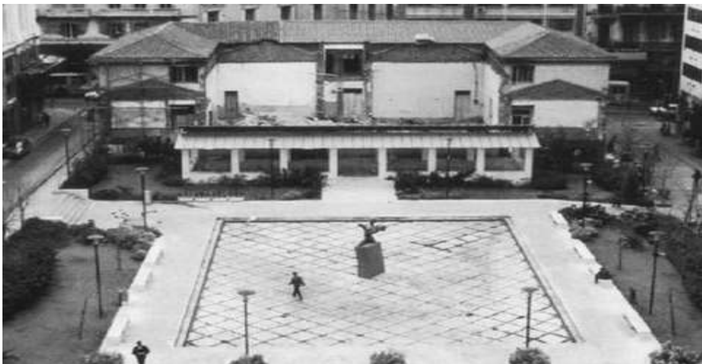
Εικόνα 45. Πίσω μέρος του κτιρίου μετά τις προσθήκες του 1890. Πηγή: archaiologia.eie.gr
