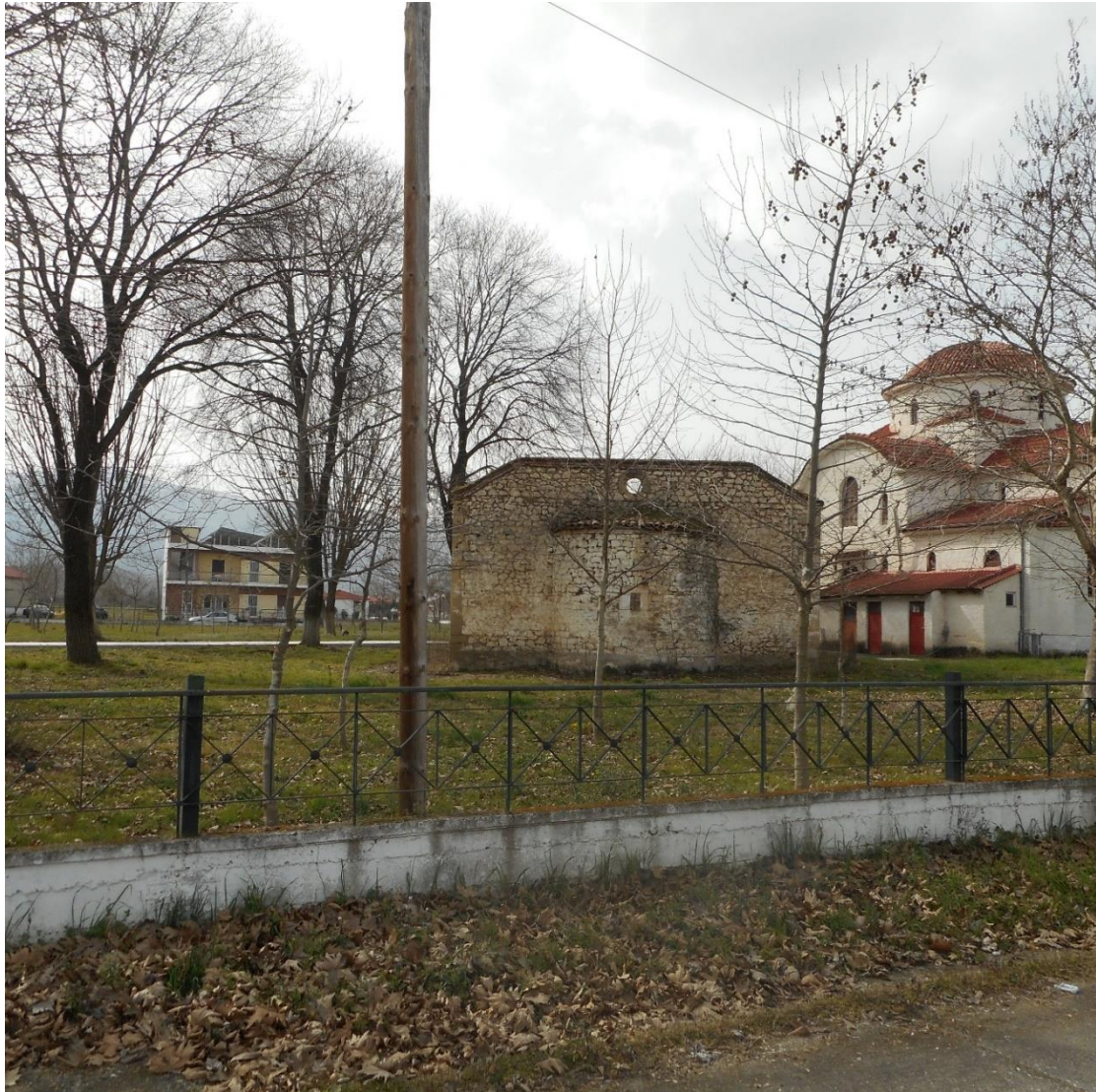
Εικόνα 17. Ο αύλιος χώρος του ναού είναι περιμανδρωμένος με τοίχιο από οπλισμένο σκυρόδεμα όπου στην στέψη του φέρει μεταλλικό κιγκλίδωμα.
