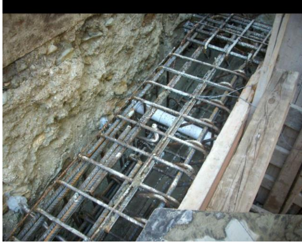
Σχήμα 39. Ενίσχυση θεμελίωσης με οπλισμένο σκυρόδεμα.
