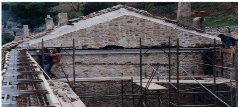
Σχήμα 31. Οριζόντιο διάζωμα στην στέψη τοίχου. Διακρίνονται οι θέσεις έδρασης των δοκών που θα αποτελέσουν το φέρων οργανισμό της στέγης
