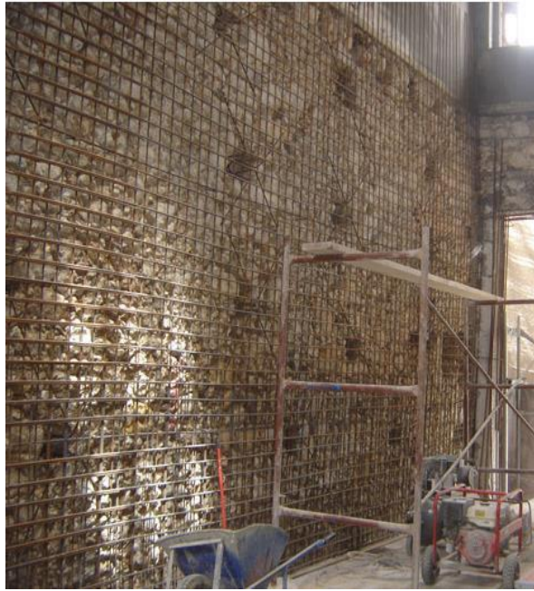
Σχήμα 29. Ενίσχυση τοιχοποιίας με εφαρμογή μανδύα οπλισμένου σκυροδέματος
