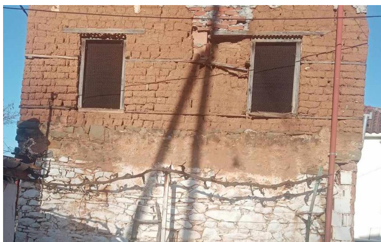
Εικόνα 8. Κατασκευή από ωμόπλινθο.
