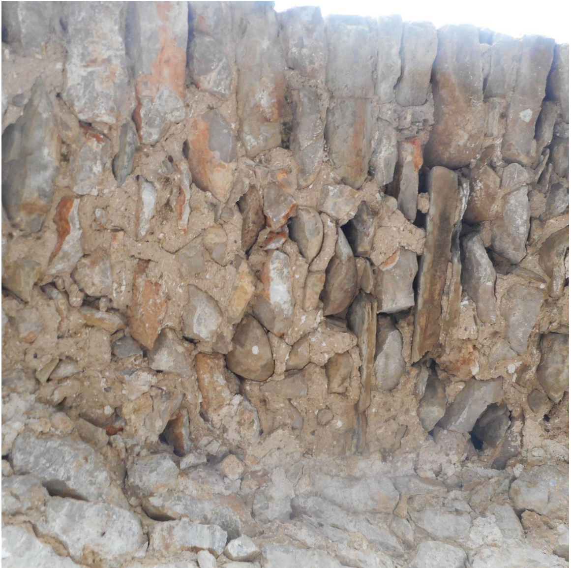
Εικόνα 35. Εκτεταμένη απώλεια συνδετικής κονίας και επιχρισμάτων
