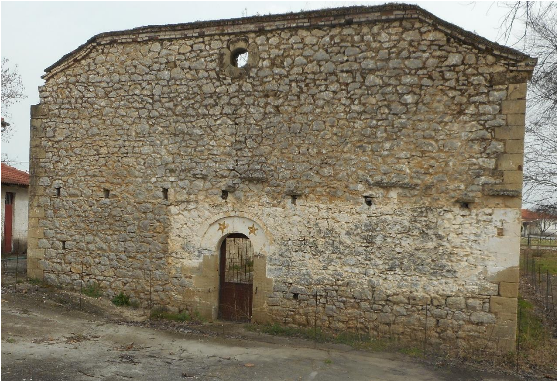
Εικόνα 21. Κεντρική είσοδος του Ναού.(διακρίνονται οι δοκοθήκες).
