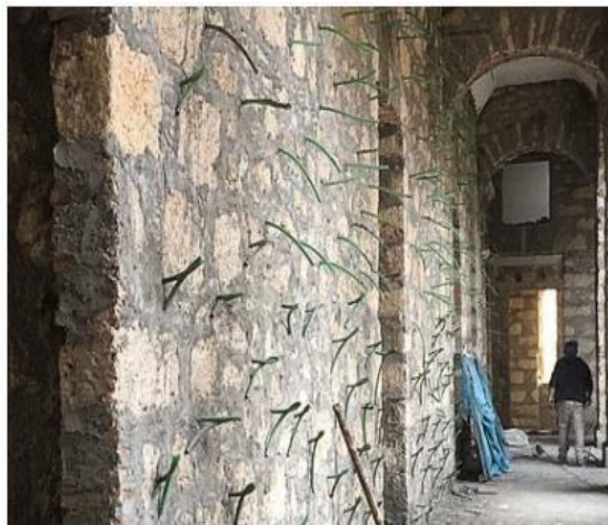
Σχήμα 34. Εκτέλεση ενεμάτων, πηγή Διαδίκτυο
