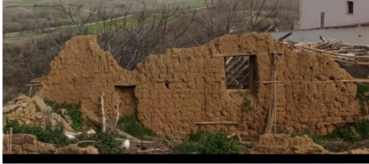
Εικόνα 9. Τοιχοποιία από ωμόπλινθο διαβρωμένη από τη βροχή.
