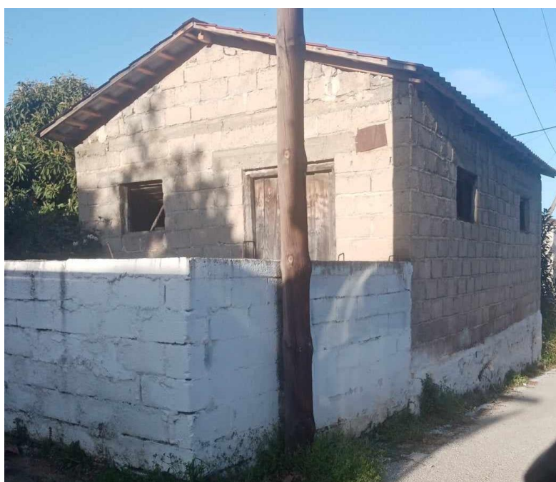
Εικόνα 11. Κατασκευές από τσιμεντολιθοδομές.
