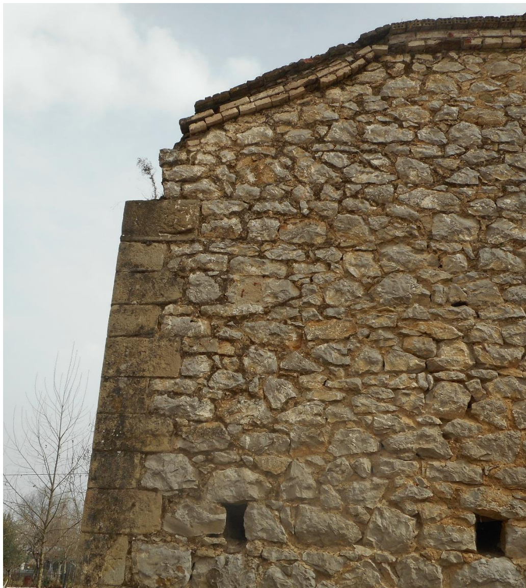
Εικόνα 31. Βορειοδυτική γωνία του κτιρίου
