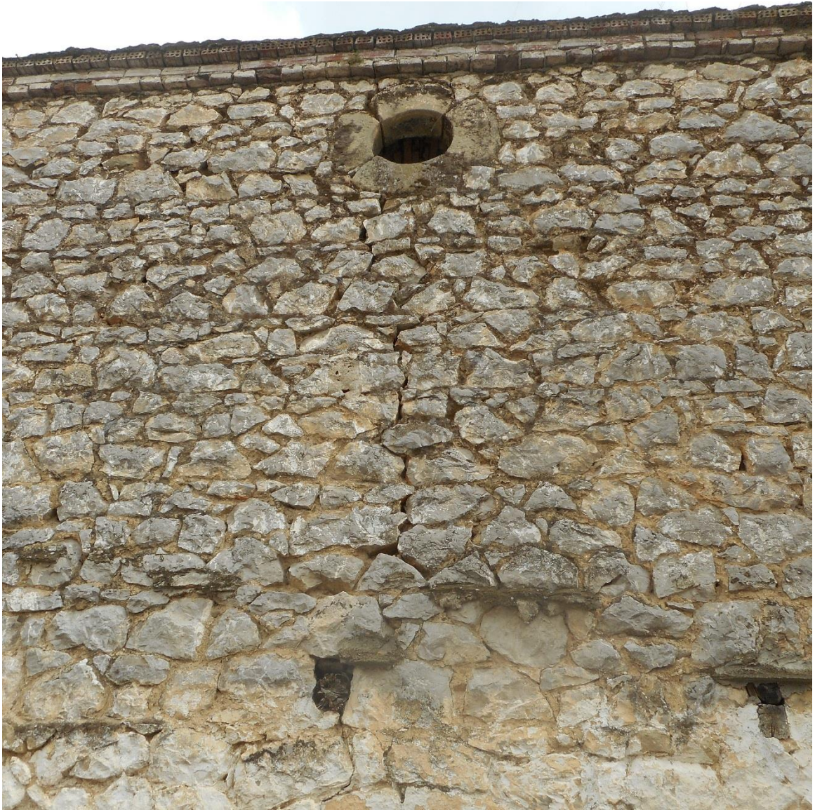
Εικόνα 34. Έντονη ρηγμάτωση
