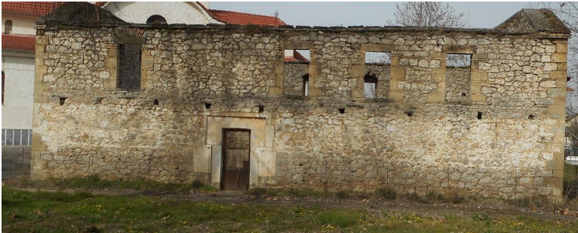
Εικόνα 22. Νότια είσοδος του Ναού. (διακρίνονται οι δοκοθήκες).
