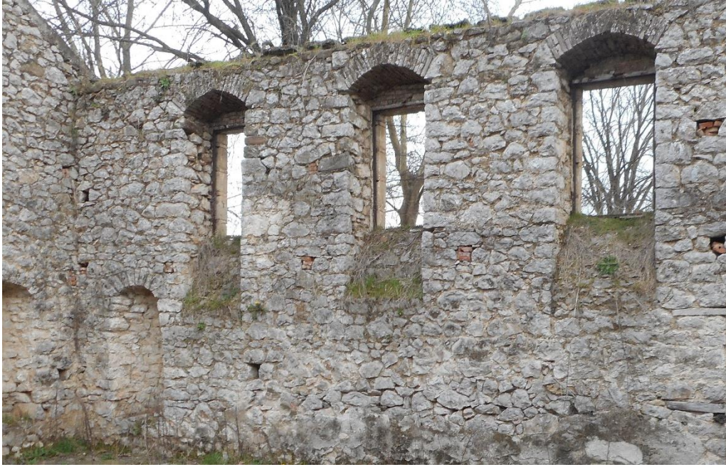
Εικόνα 29. Τοξωτών υπερθύρων από πλίνθους εσωτερικά
