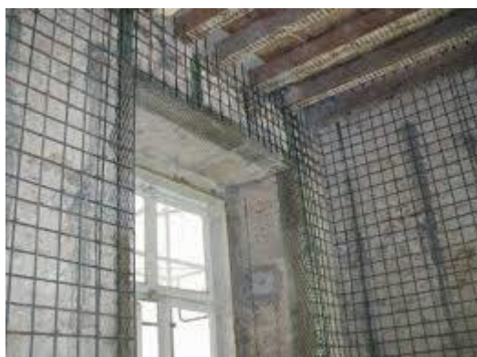
Σχήμα 28. Ενίσχυση τοιχοποιίας με εφαρμογή οπλισμένου επιχρίσματος.
