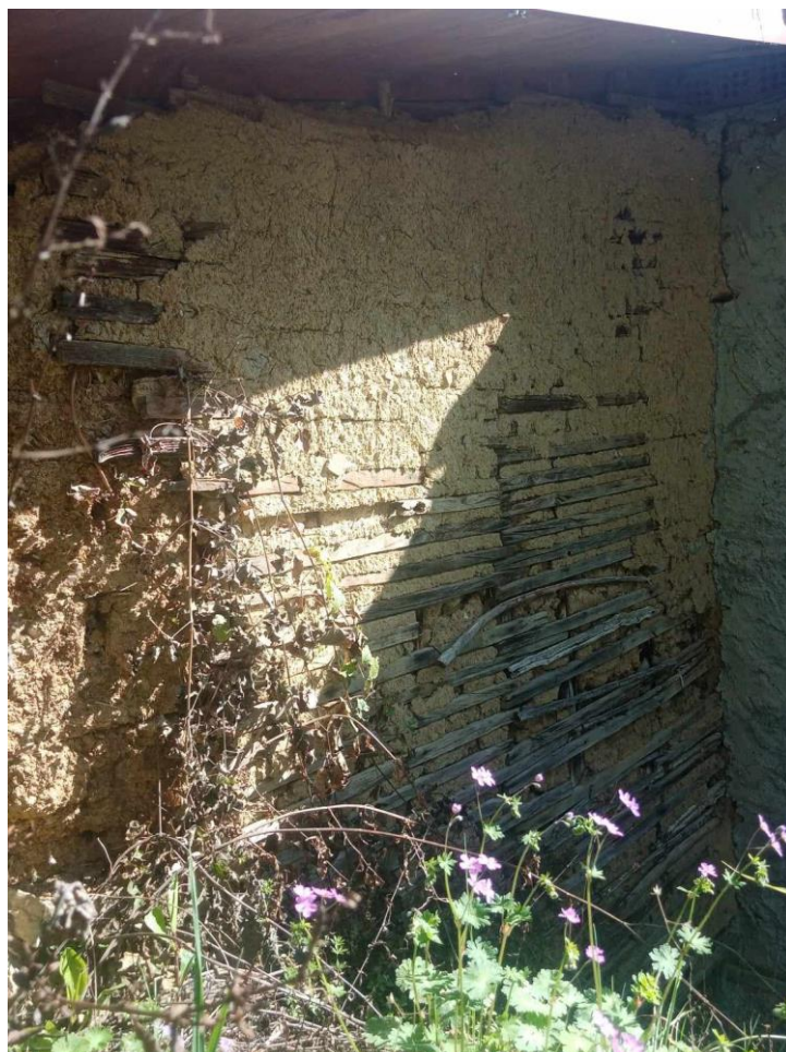
Εικόνα 1. κατασκευή τοιχοποιίας από τσατμά (μπαγδατί).
