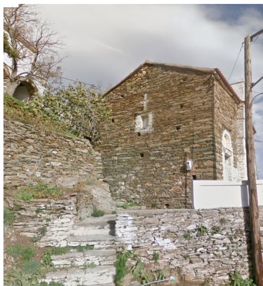
Εικόνα 7. Κατασκευή από πλακοειδής λιθοδομή.
