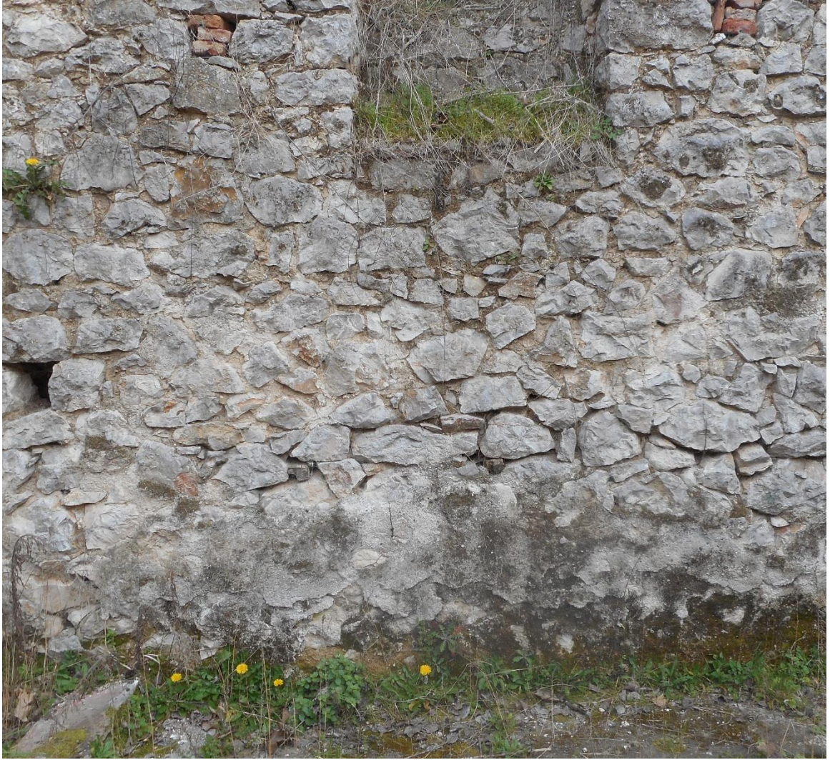
Εικόνα 36. Αποσαθρωμένο επίχρισμα
