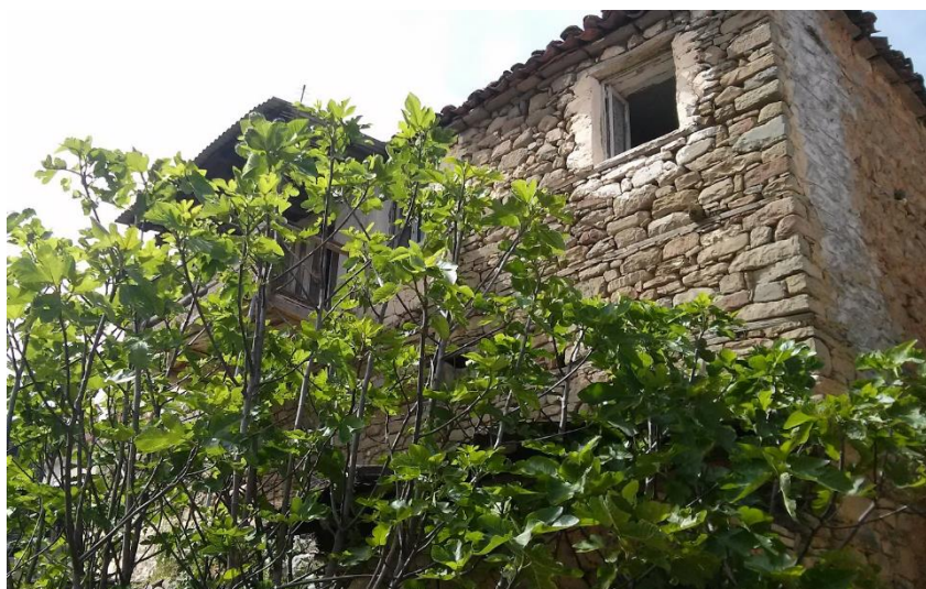
Εικόνα 4. Κτίριο από αργολιθοδομή.
