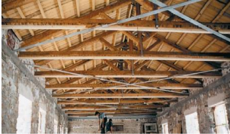
Σχήμα 36. Ενίσχυση στέγης με χιαστί λάμες, ΒΑ πτέρυγα κελλιών Ι. Μονής Οσίου Λουκά.
