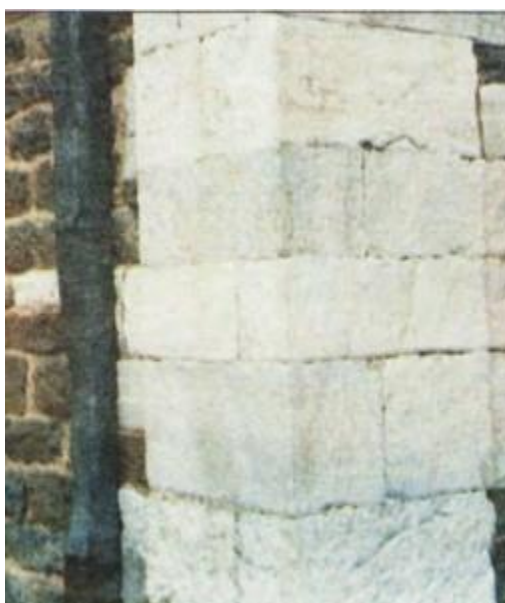
Εικόνα 6. Κατασκευή με λαξευτή λιθοδομή
