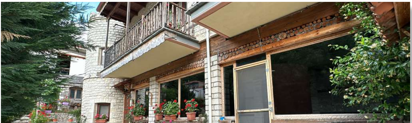
Εικόνα 7: Εξωτερική όψη του ξενώνα Πασιθέη
