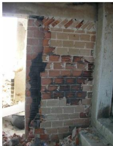
Αποφλοίωση τοίχων πλήρωσης, αποσύνθεση κονιάματος, ρηγματώση.
