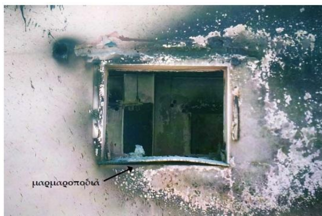
Η ξύλινη μαρκίζα κάηκε πλήρως. Οι υαλοπίνακες έσπασαν και εκτινάχτηκαν, ενώ τα αλουμινένια πλαίσια και παραθυρόφυλλα έλιωσαν. Η μαρμαροποδιά κάμφθηκε προς τα άνω.
