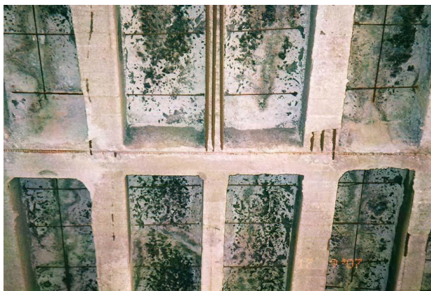
Δοκίδες/ νευρώσεις χωρίς συνδετήρες, πιο γρήγορη αστοχία των πιο λεπτών απ' αυτές.
