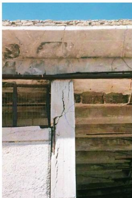
Θραύση υποστυλωμάτων με ανεπαρκείς συνδετήρες, χαρακτηριστικές ρωγμές προβόλων και δοκών.
