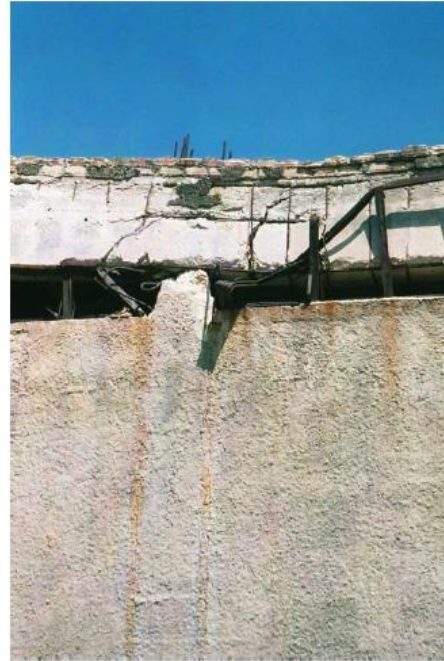
Θραύση κοντών υποστυλωμάτων, και κατάρρευση.
