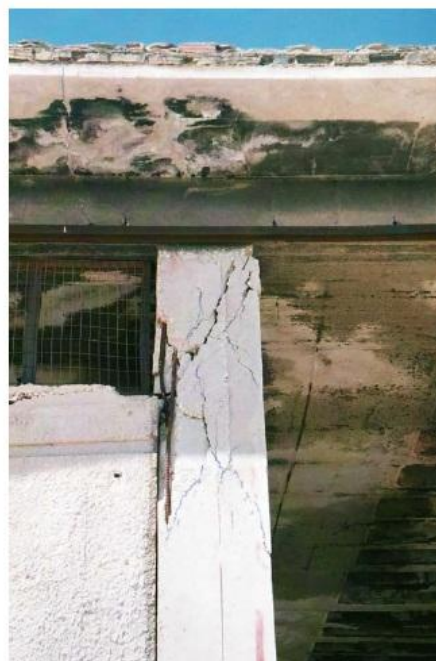
Θραύση υποστυλωμάτων με ανεπαρκείς συνδετήρες, χαρακτηριστικές ρωγμές προβόλων και δοκών.
