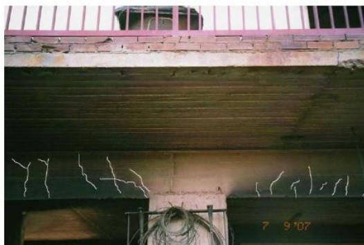
Χαρακτηριστικές πολλαπλές ρωγμές δοκών (καμπτικές και διατμητικές).
