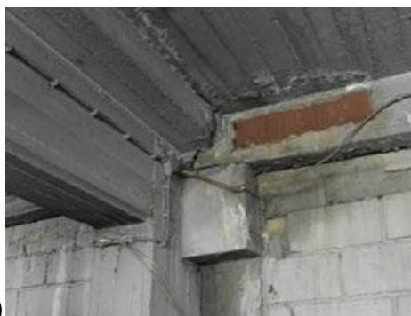
Εικ. 4 Συντριβή άκρου δοκού εδραζόμενης σε “φορούσια”
