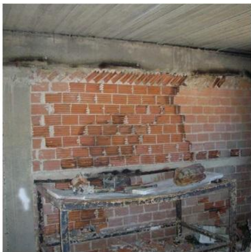
Αποφλοίωση τοίχων πλήρωσης, αποσύνθεση κονιάματος, ρηγματώση.
