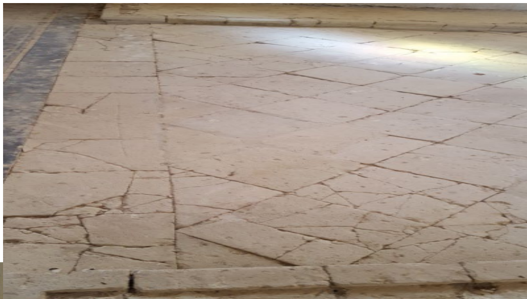
Εικόνα 118. Απώλειες υλικού στα σκαλοπάτια.
