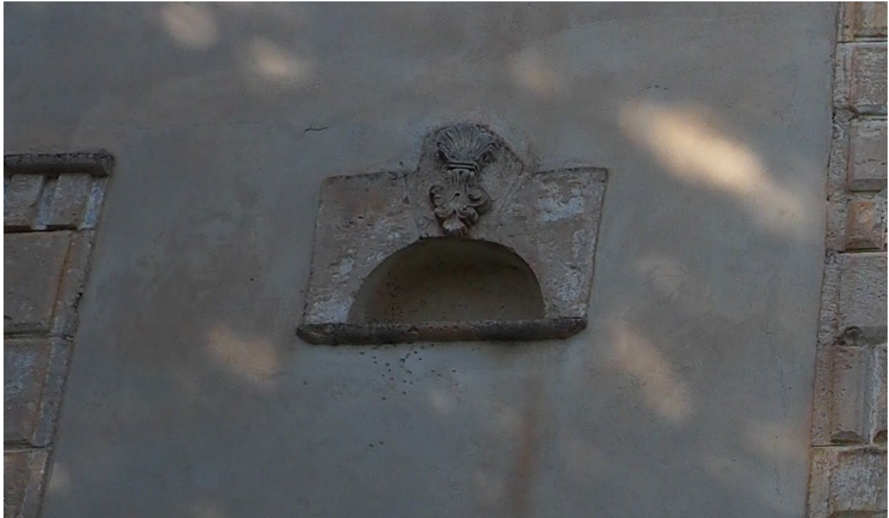
Εικόνα 43. Λεπτομέρεια ανατολικής όψης, διακοσμητικό πλαίσιο.
