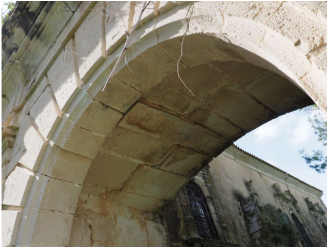
Εικόνα 143. Μετατόπιση του λίθου στην κορυφή του τόξου της καμάρας του διαβατικού.
