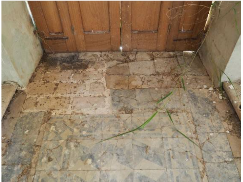
Εικόνα 121. Κακή επανατοποθέτηση πλακών.
