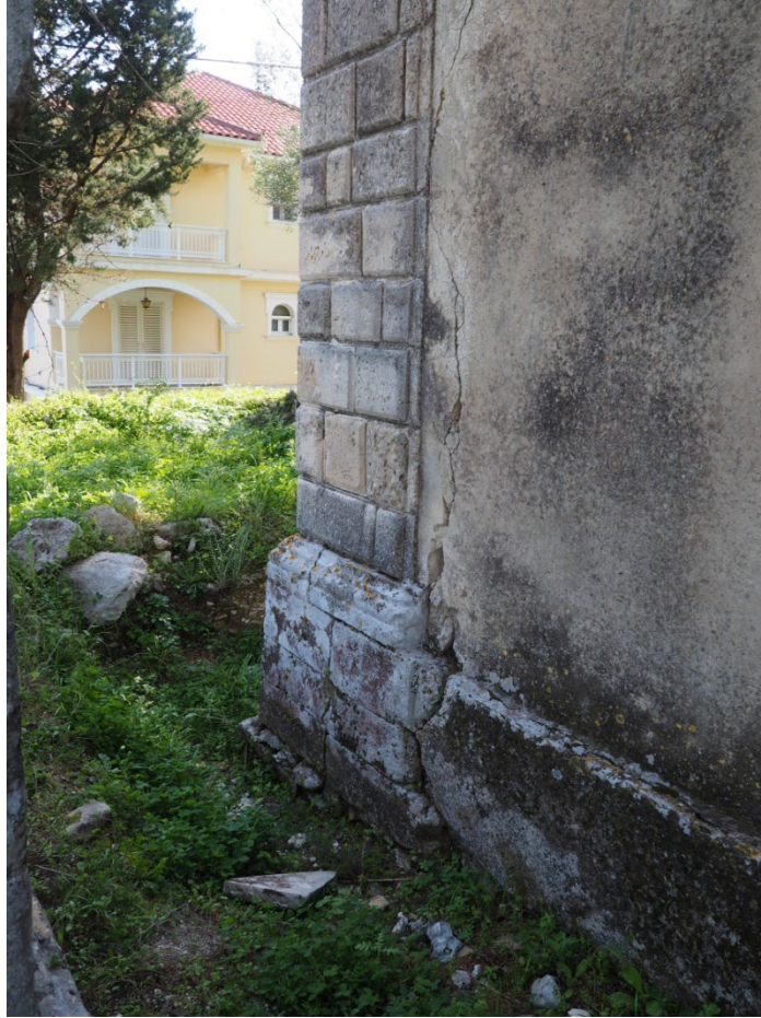
Εικόνα 106. Σκάμμα στη βορειοανατολική γωνιά του ναού.
