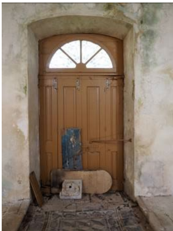
Εικόνα 21. Εσωτερική όψη βόρειας θύρας ναού.
