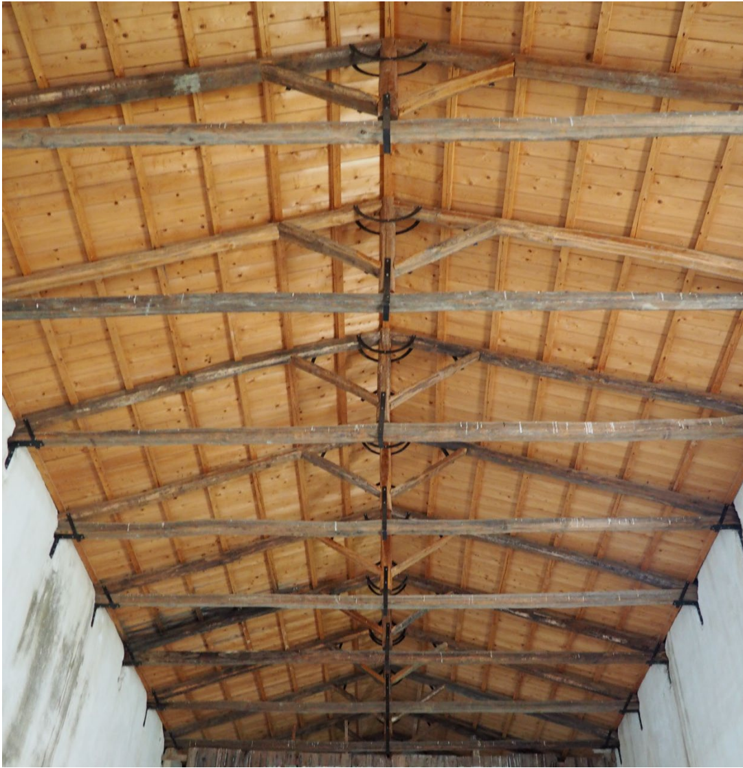
Εικόνα 94. Αντικατάσταση της στέγης από την 6η Εφορεία Βυζαντινών Αρχαιοτήτων.
