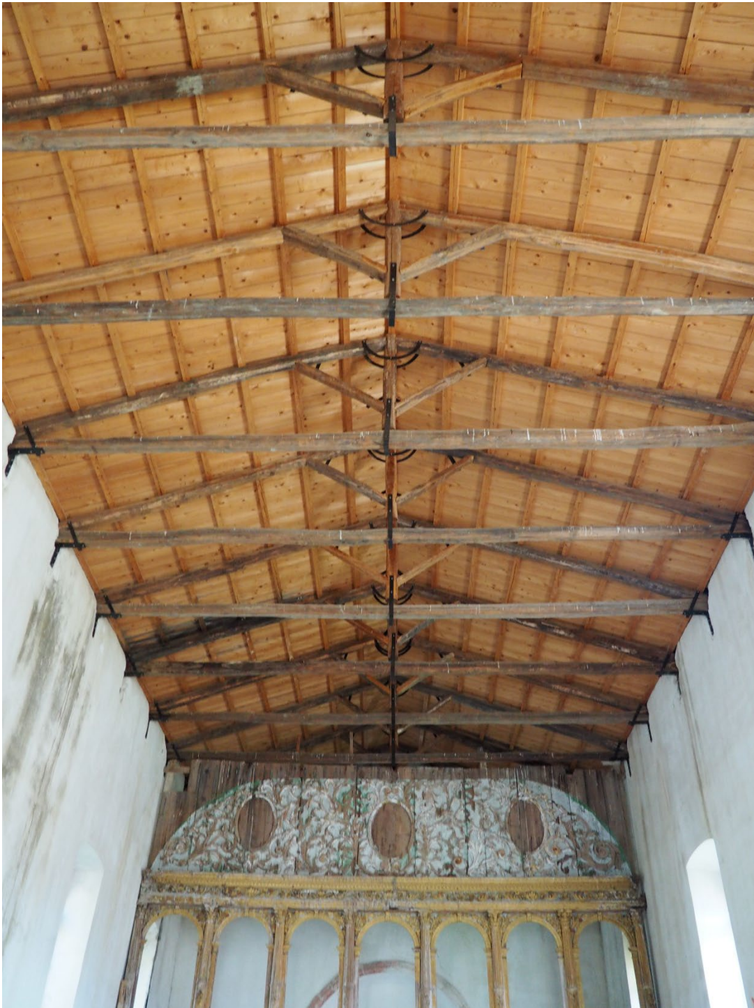
Εικόνα 8. Ξύλινα ζευκτά οροφής.
