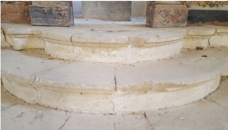
Εικόνα 118. Απώλειες υλικού στα σκαλοπάτια.
