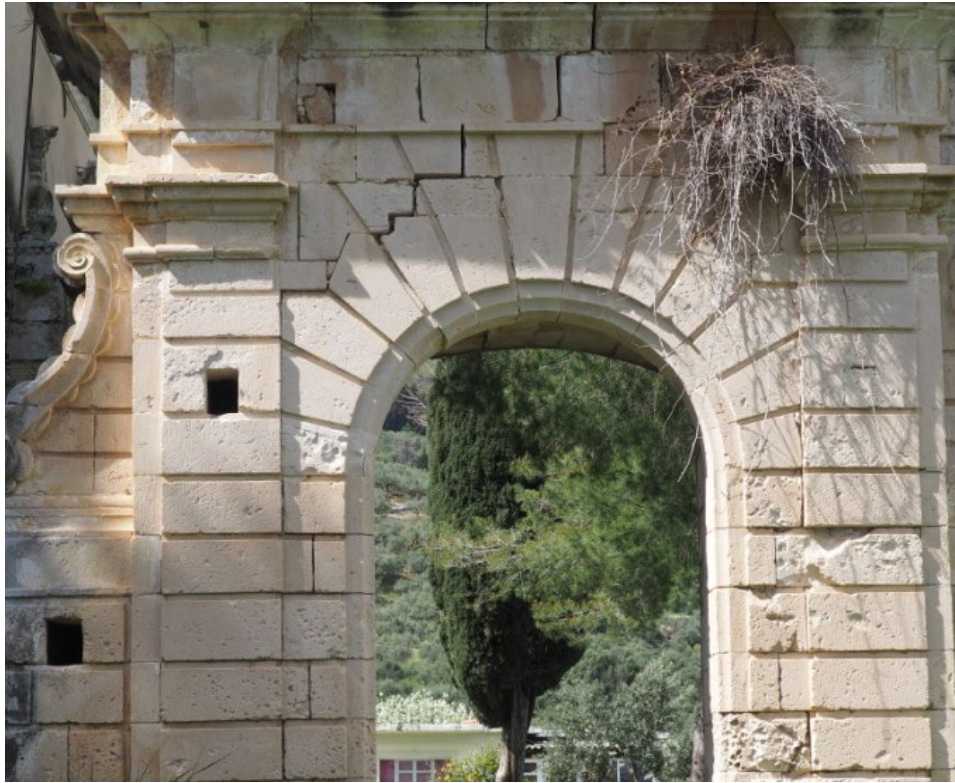
Εικόνα 138. Ρηγματώσεις, αποσάθρωση λίθου, απώλεια υλικού ,υγρασία βιολογικές επικαθίσεις παρατηρούνται στο κωδωνοστάσιο.
