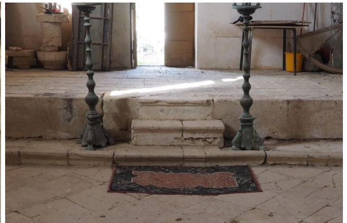
Εικόνα 118. Απώλειες υλικού στα σκαλοπάτια.
