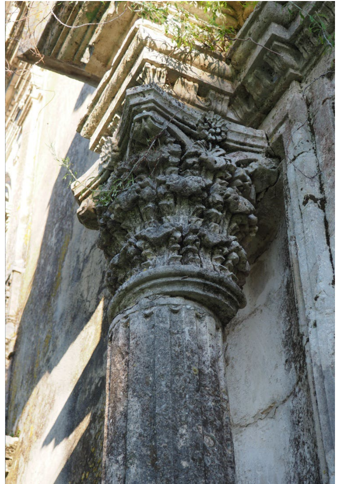
Εικόνα 108. Μετατόπιση λίθου στον αριστερό κίονα της κυρίας εισόδου.
