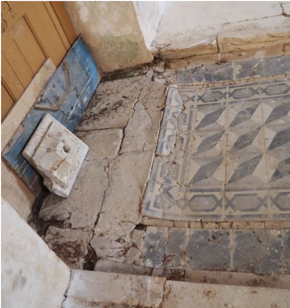
Εικόνα 121. Κακή επανατοποθέτηση πλακών.
