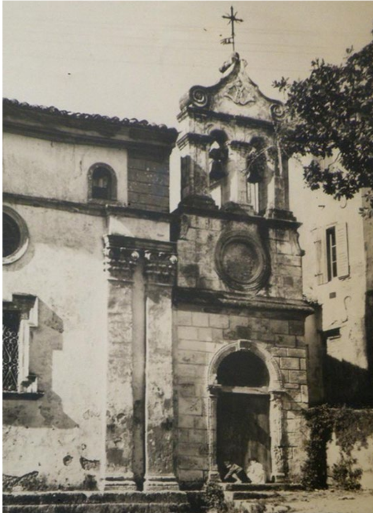
Εικόνα 137. Το σεισμικό καμπαναριό του Αγίου Νικολάου των Γερόντων της Ζακύνθου. (πηγή: N. Δ. Βαρβιάνη, Η ΖΑΚΥΝΘΟΣ ).
