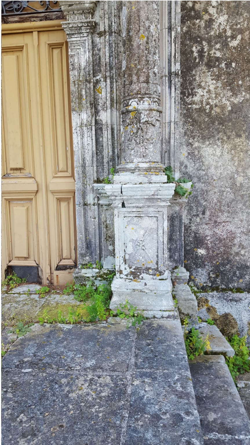
Εικόνα 109. Βιολογικές επικαθίσεις και φυτά στην κυρία είσοδο.
