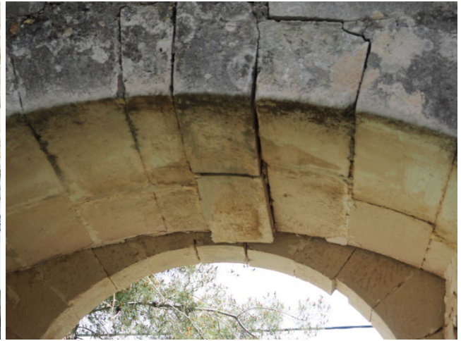
Εικόνα 143. Μετατόπιση του λίθου στην κορυφή του τόξου της καμάρας του διαβατικού.
