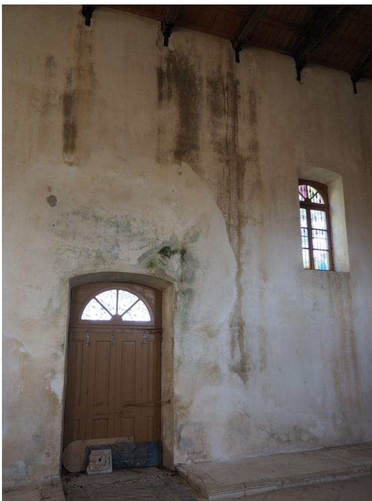
Εικόνα 115. Υγρασία και βιολογικές επικαθήσεις.
