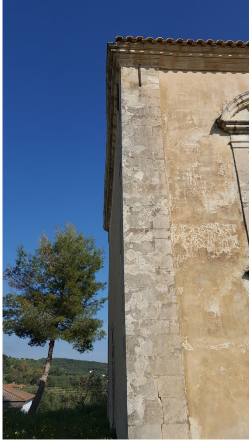
Εικόνα 36. Καθ' ύψος ακμή του ναού, κατασκευασμένη από λίθινο λαξευτό γωνιόλιθο.
