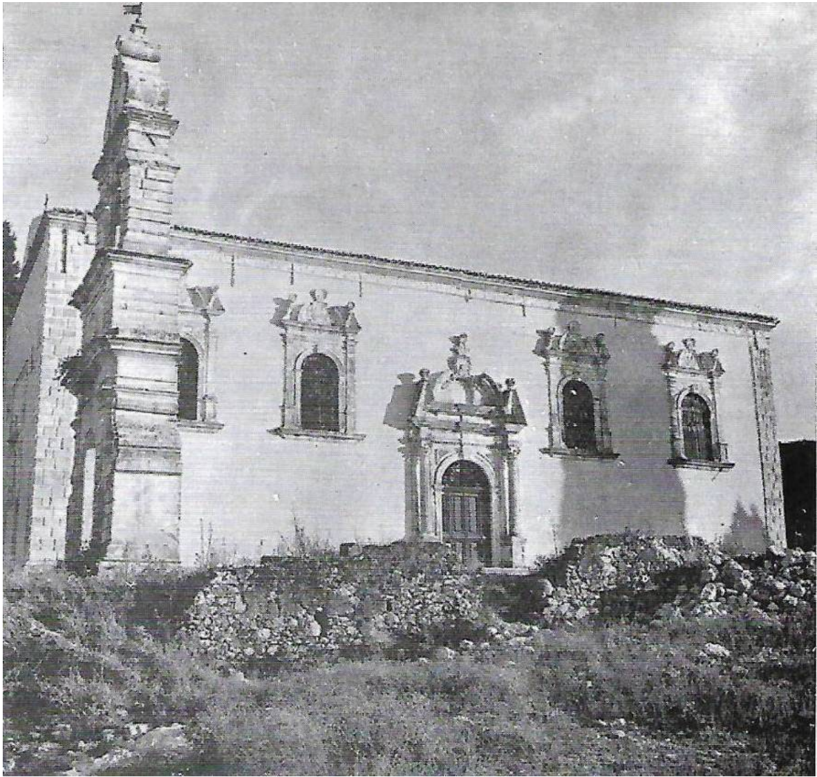
Εικόνα 5. Υπαπαντή Μαχαιράδου, βορεινή όψη, φωτ. 1968 (πηγή: Δ. Ζήβας, η Αρχιτεκτονική της Ζακύνθου, από τον ΙΣΤ΄ μέχρι τον ΙΘ΄ αιώνα).
