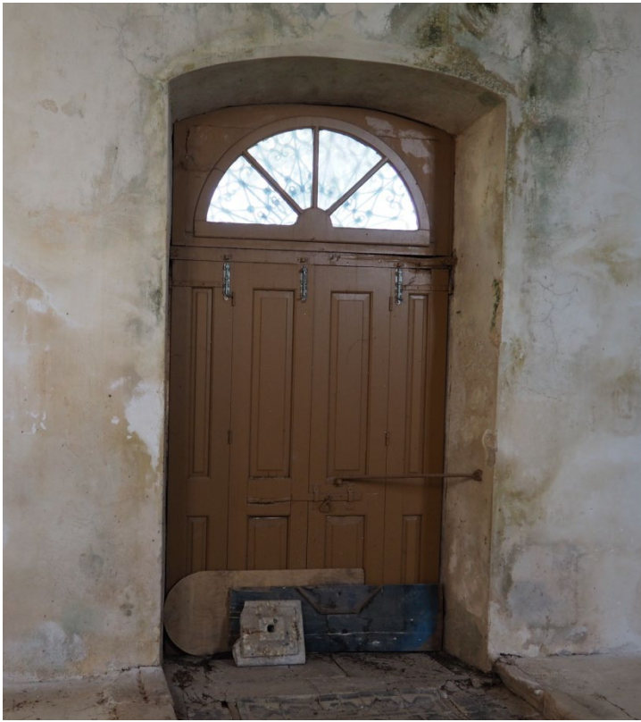
Εικόνα 122. Φθορές στις πόρτες.
