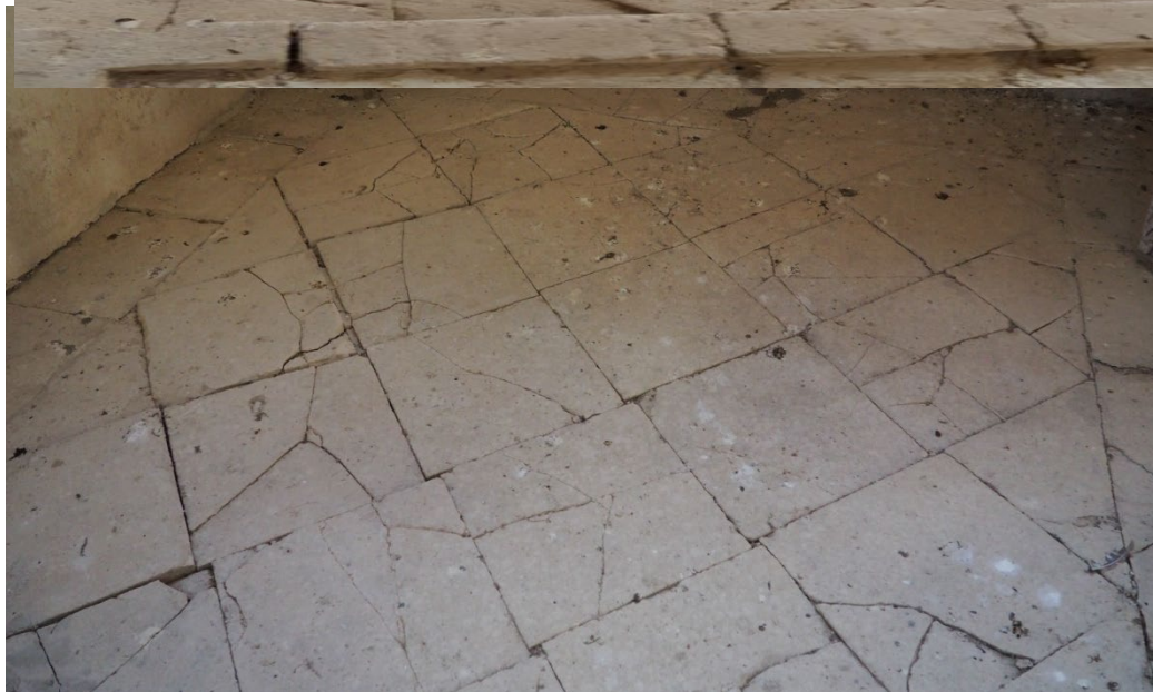
Εικόνα 119. Ραγισμένες πλάκες.
