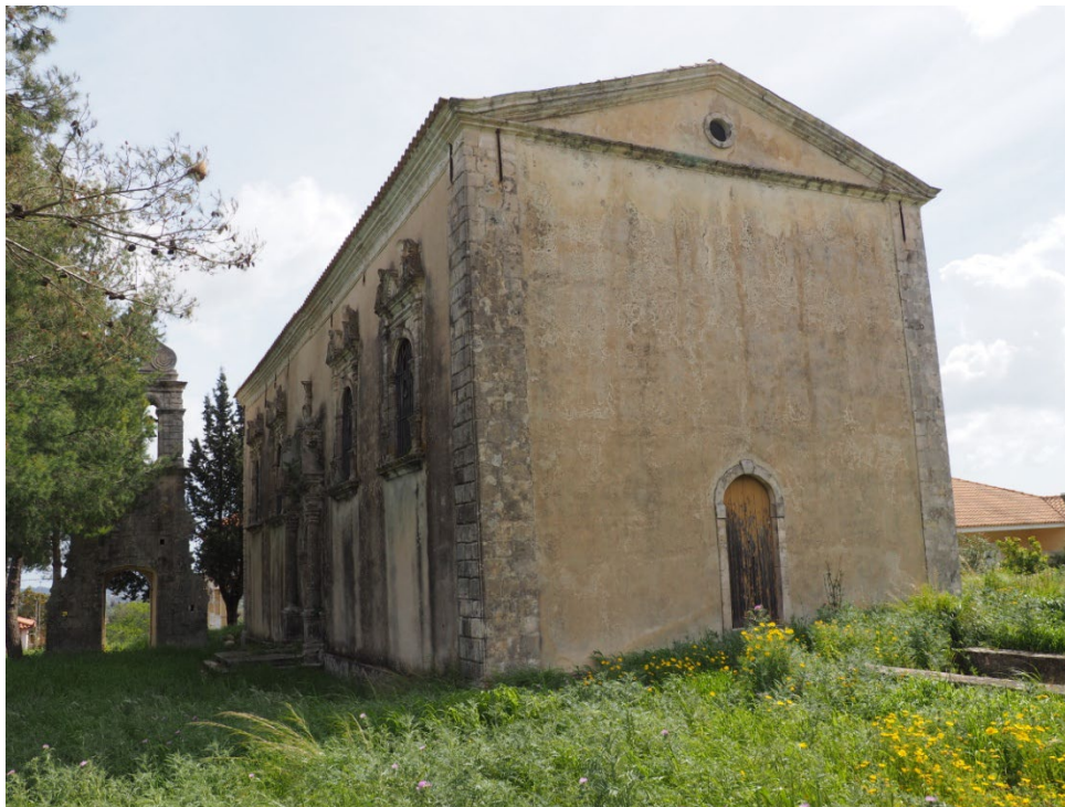
Εικόνα 33. Γείσο περιμετρικά του ναού και στο αέτωμα της δυτικής πλευράς μόνο.
