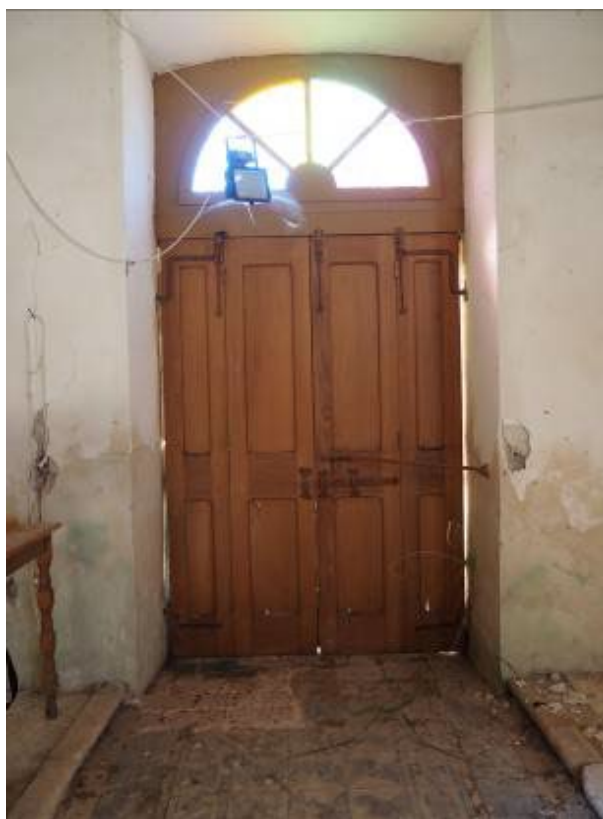
Εικόνα 22. Εσωτερική όψη νότιας θύρας ναού.
