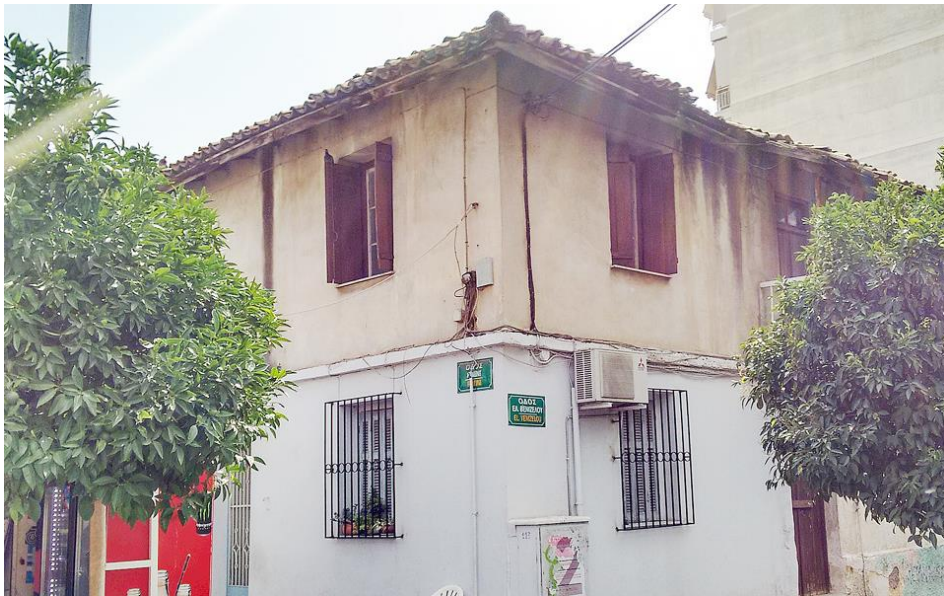
Εικόνα 4.3: Παλιό κτίριο στη Νέα Ιωνία
