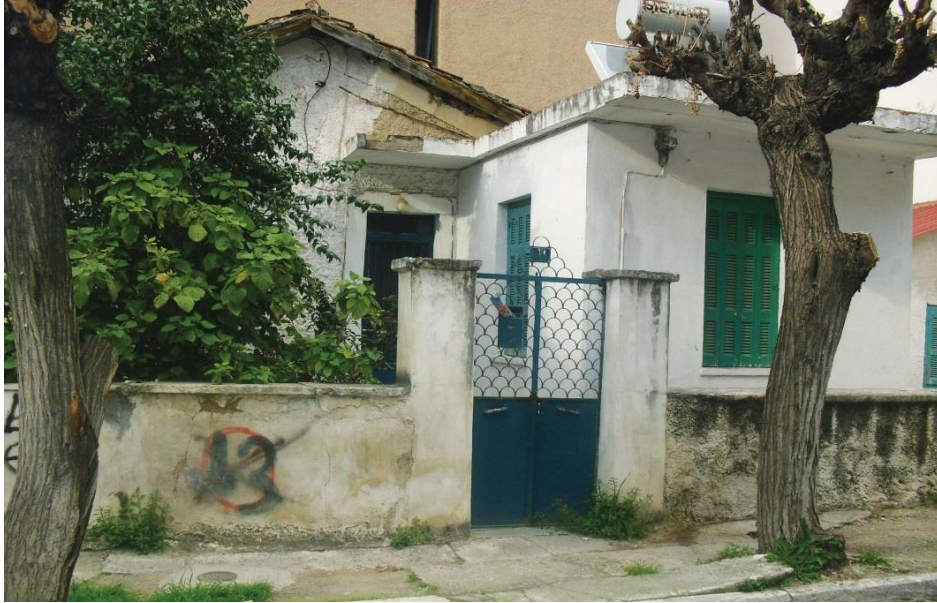
Εικόνα 4.2: Παλιό κτίριο στη Νέα Ιωνία
