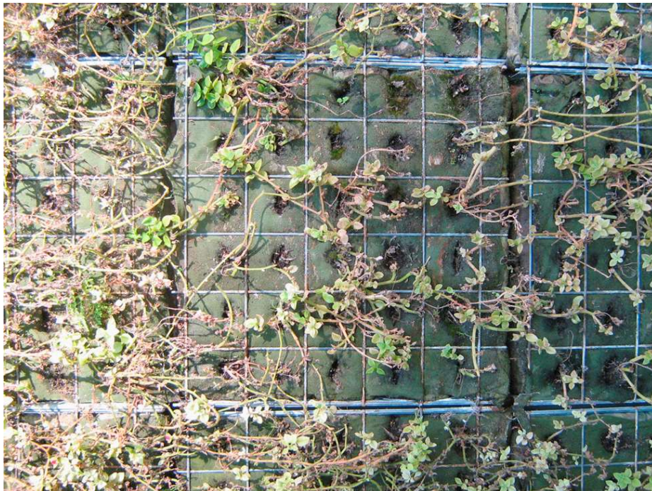
Εικόνα 4.39 Δομή στήριξης αρθρωτών συστημάτων ζωντανού τοίχου[115].
