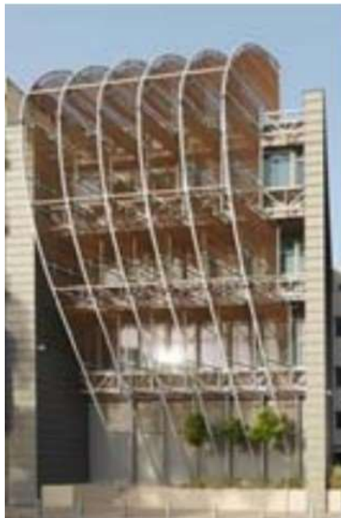
Εικόνα 4.27: Κάθετη, σταθερή σκίαση από ξύλο. Γραφεία στο Πειραιά, Αθήνα 2012 «Σκίαση σαν πανιά» από Agnes Kouvelas Architects.
