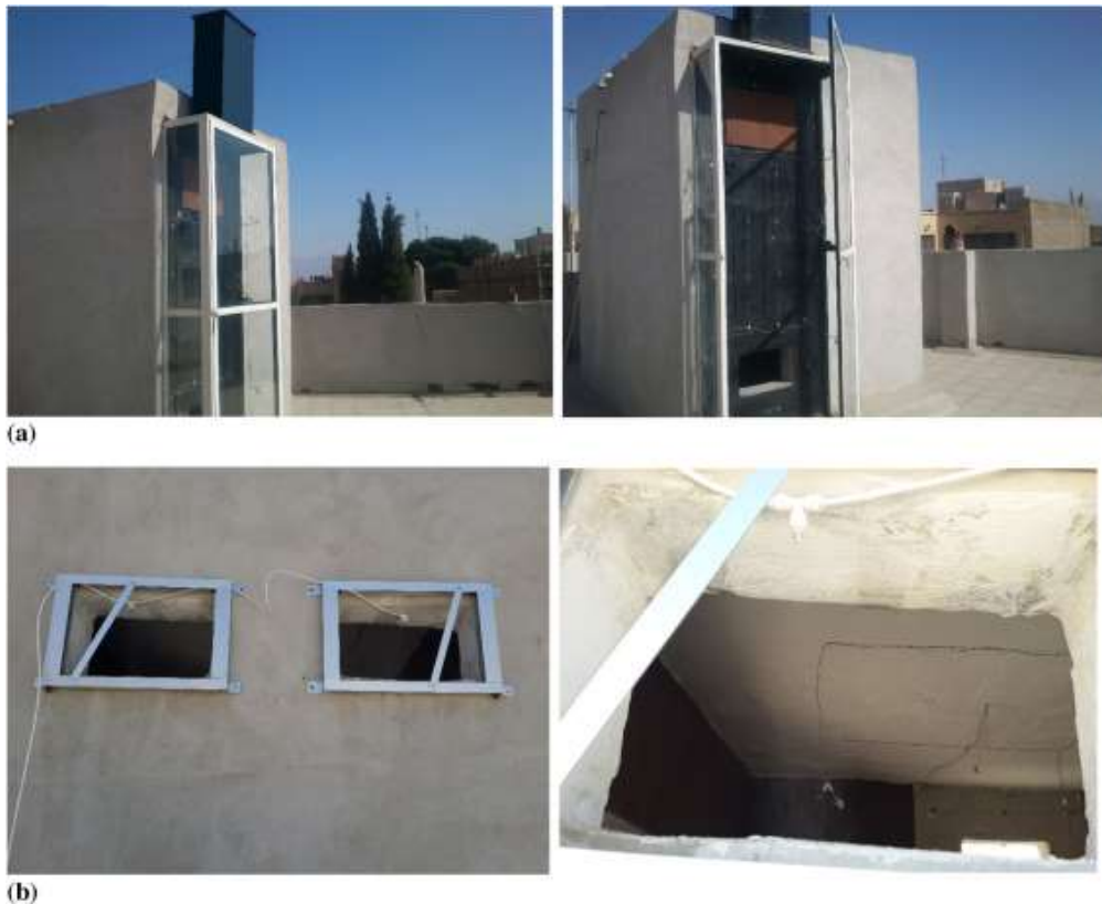
Εικόνα 4.21:α) Συνδυασμός τοίχου Trombe και ηλιακής καμινάδας. β) Το σύστημα ψεκάσμού νερού-WSS στο πίσω μέρος του δωματίου. 99
