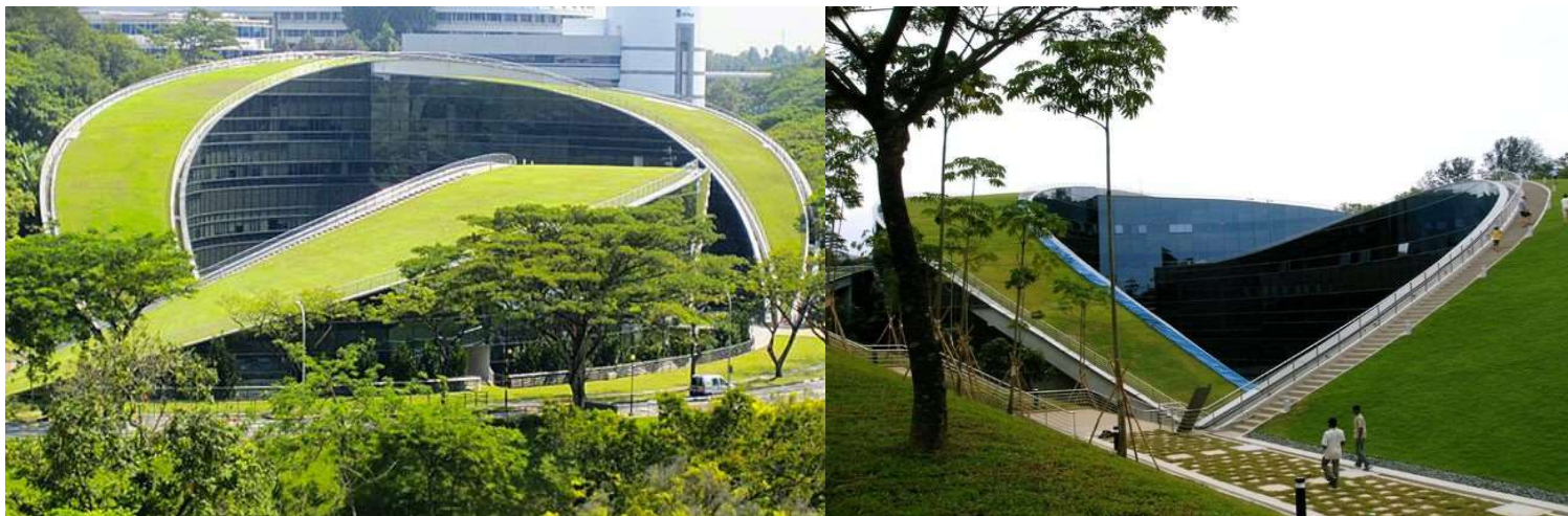
Εικόνα 4.43: NANYANG TECHNOLOGICAL UNIVERSITY, SINGAPORE, SCHOOL OF ART DESIGN AND MEDIA, Αρχιτεκτονική εταιρεία CPG Consultants. Πηγή: https://www.goodnet.org/articles/5-impressive-green-roofs-from-across-globe
