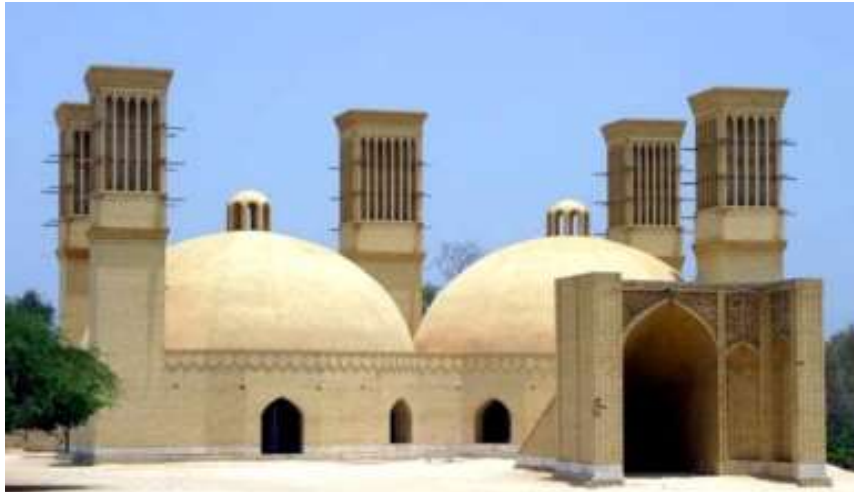
Εικόνα 4.20: Φυσική ψύξη και αερισμός με τη χρήση πύργου ανέμου. Γιάζντ, Ιράν [99].
