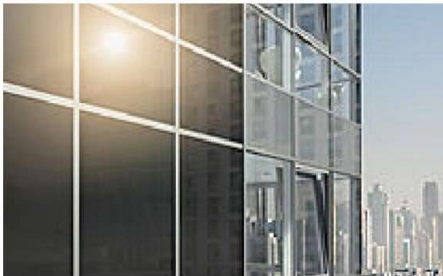
Εικόνα5.7:Υψηλής απόδοσης ηλεκτροχρωματικός υαλοπίνακας. Πηγή: utunisphere.com
