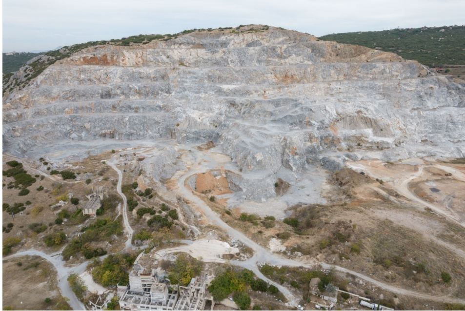
Εικ.17, Λατομείο #1, Ασβεστοχώρι 40.651424, 23.016340,
