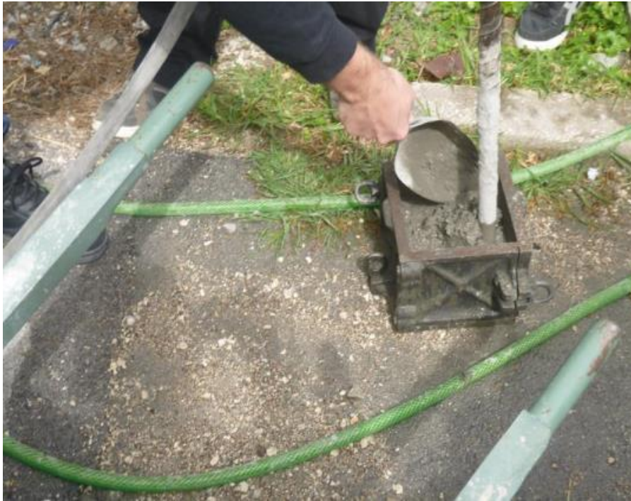
Εικόνα 21: Συμπύκνωση σκυροδέματος με την βοήθεια ράβδου [52]
