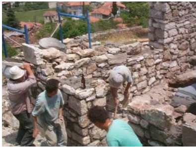
Εικόνα 12. Κατασκευή παραδοσιακής κατοικίας [69]
