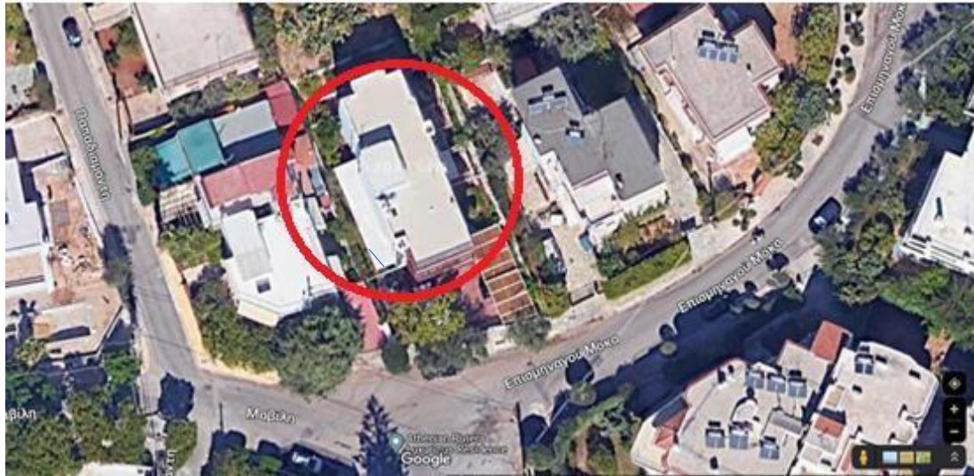
Εικόνα 6. 1: Κάτοψη της πολυκατοικίας από αεροφωτογραφία (GoogleEarth)
