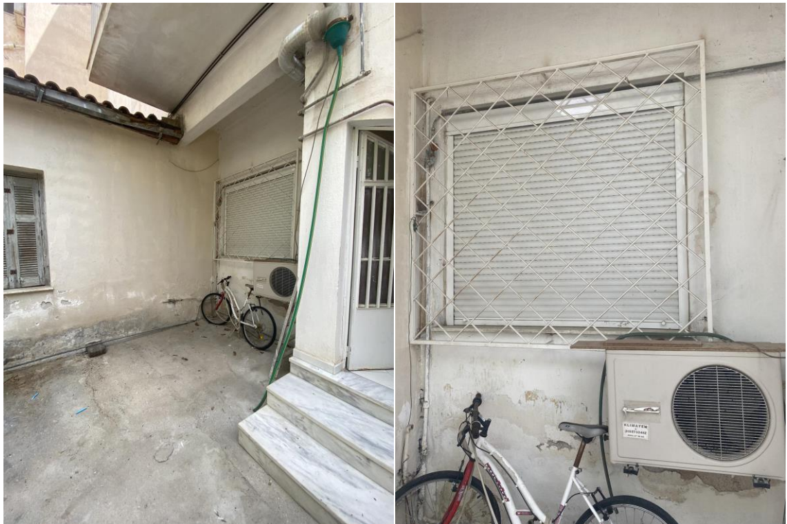
Εικόνα 5-14: Κουφώματα ισογείου – οπίσθια όψη
