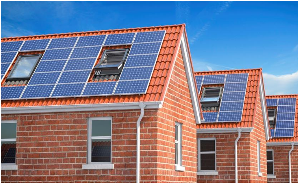
Εικόνα 4-3: Φωτοβολταϊκά συστήματα σε στέγες κατοικιών [43]
