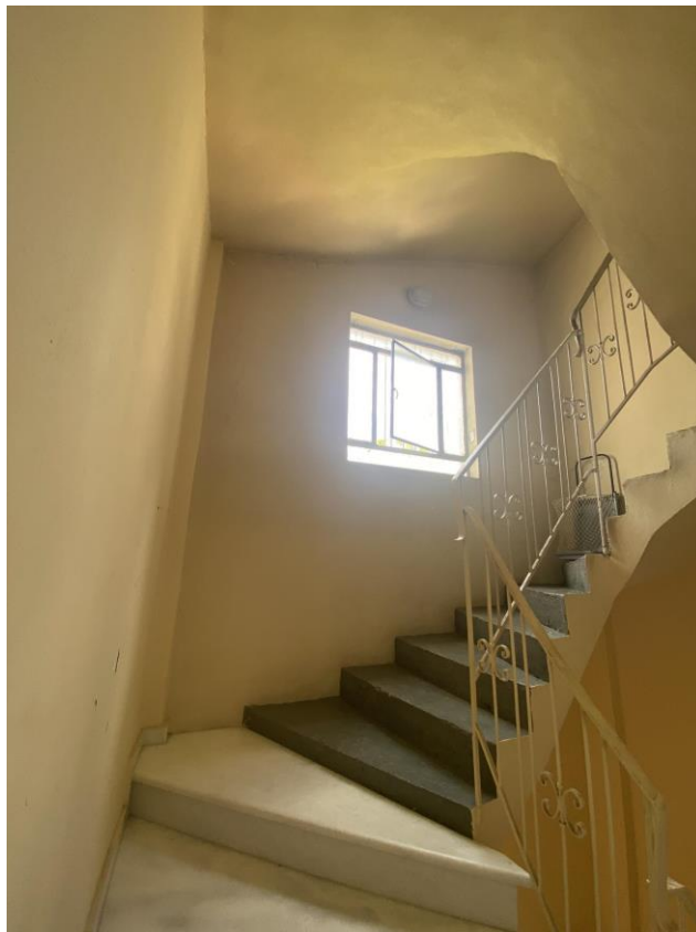
Εικόνα 5-16: Κλιμακοστάσιο. Τα παράθυρα του κλιμακοστασίου είναι επίσης μεγάλης παλαιότητας.
