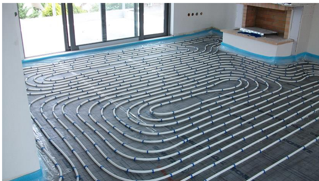
Εικόνα 4-18: Σύστημα ενδοδαπέδιας θέρμανσης [84]
