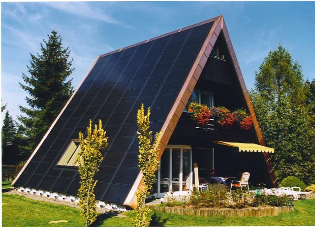
Εικόνα 4-12: Αυτόνομη «ZERO ENERGY» κατοικία στη Γερμανία, από βιώσιμα και ανακυκλωμένα υλικά, με εγκατεστημένα Φ/Β συστήματα με σκοπό τη μείωση των επιπτώσεων στο περιβάλλον [89]
