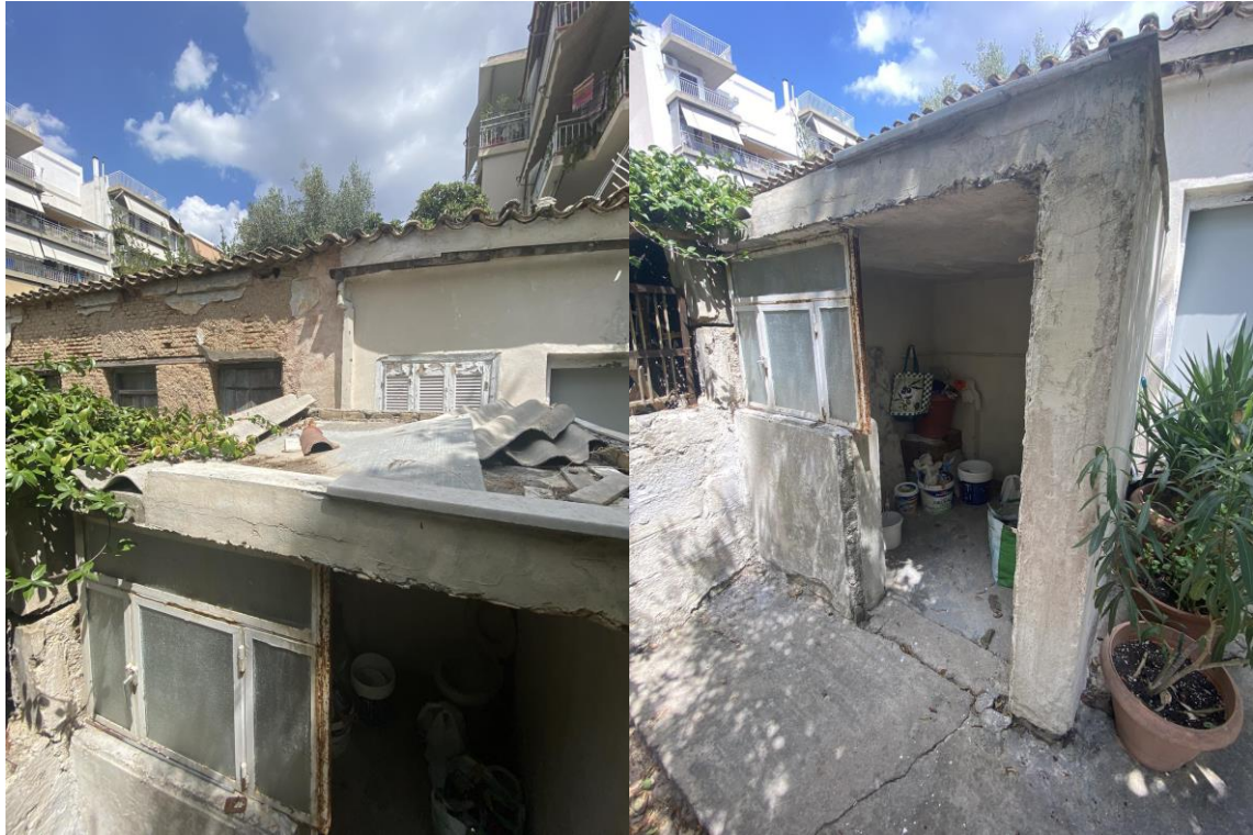
Εικόνα 5-7: Κατεδαφιστέα κτίσματα της πίσω αυλής που τώρα χρησιμοποιούνται ως αποθήκες
