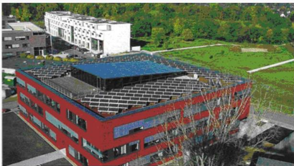
Εικόνα 4-4: Φωτοβολταϊκά συστήματα σε δώμα κτιρίου στην Κολωνία [54]
