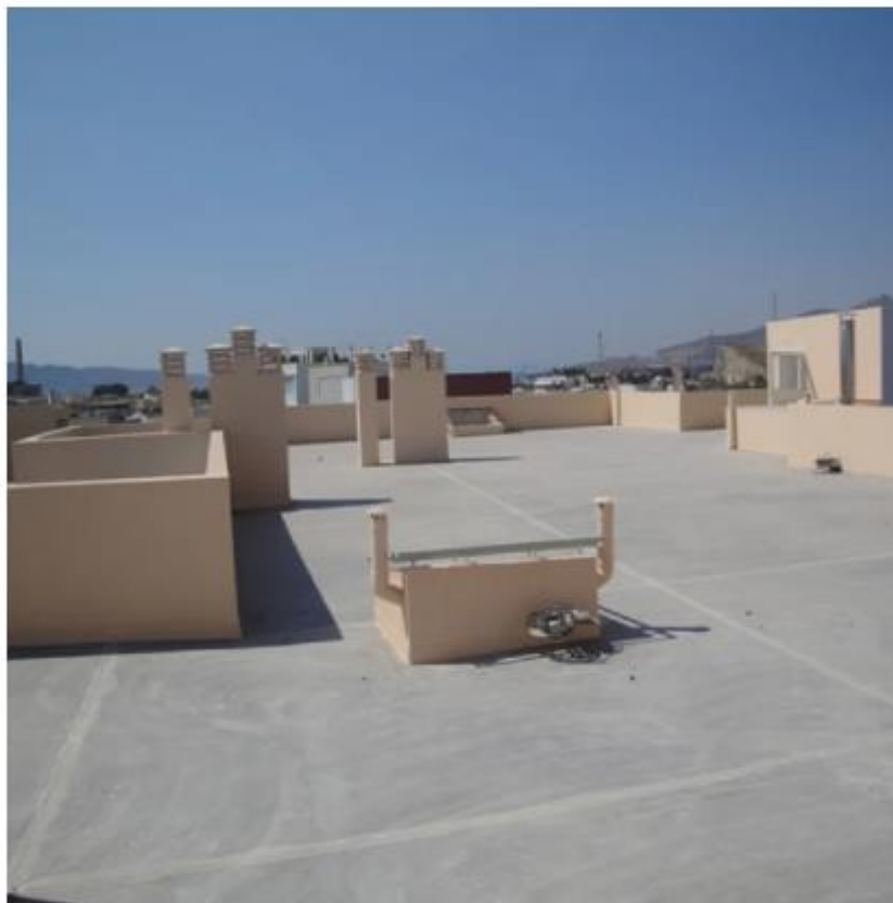
Εικόνα 6-3: Φωτογραφία εφαρμογής ανεστραμμένης θερμομόνωσης με πλήρη βατότητα και χρήση [96]
