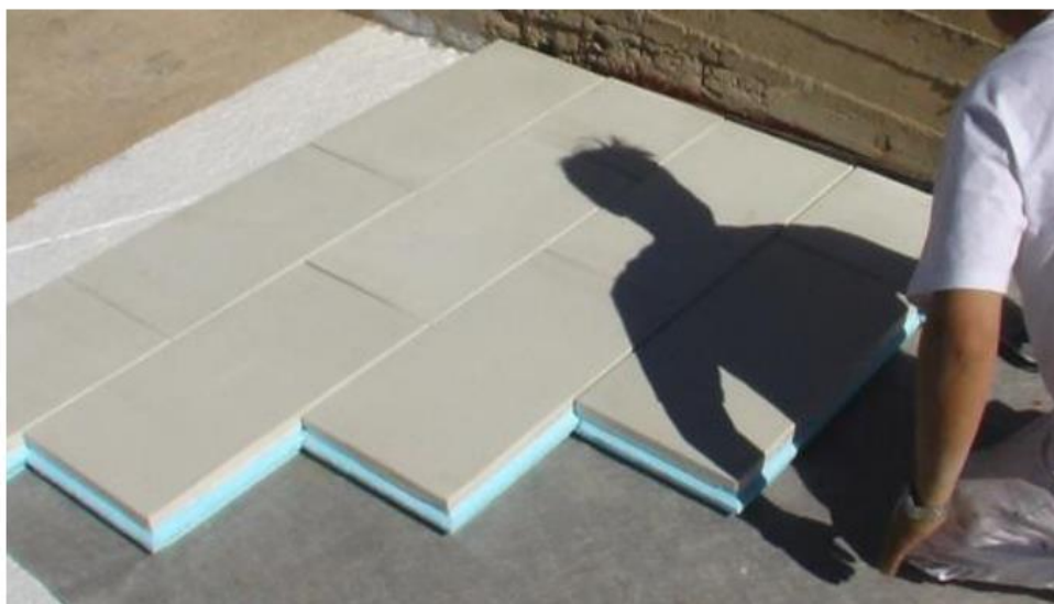
Εικόνα 6-4: Φωτογραφία εξηλασμένης πολυστερίνης σε ταράτσα, η οποία προτείνεται για την ενεργειακή αναβάθμιση του εξεταζόμενου κτιρίου [95]
