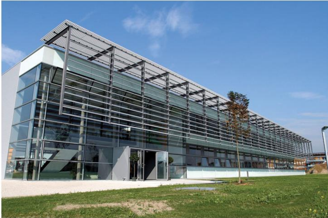
Εικόνα 4-1: Τοποθέτηση σκιάστρων σε κτίριο [37]
