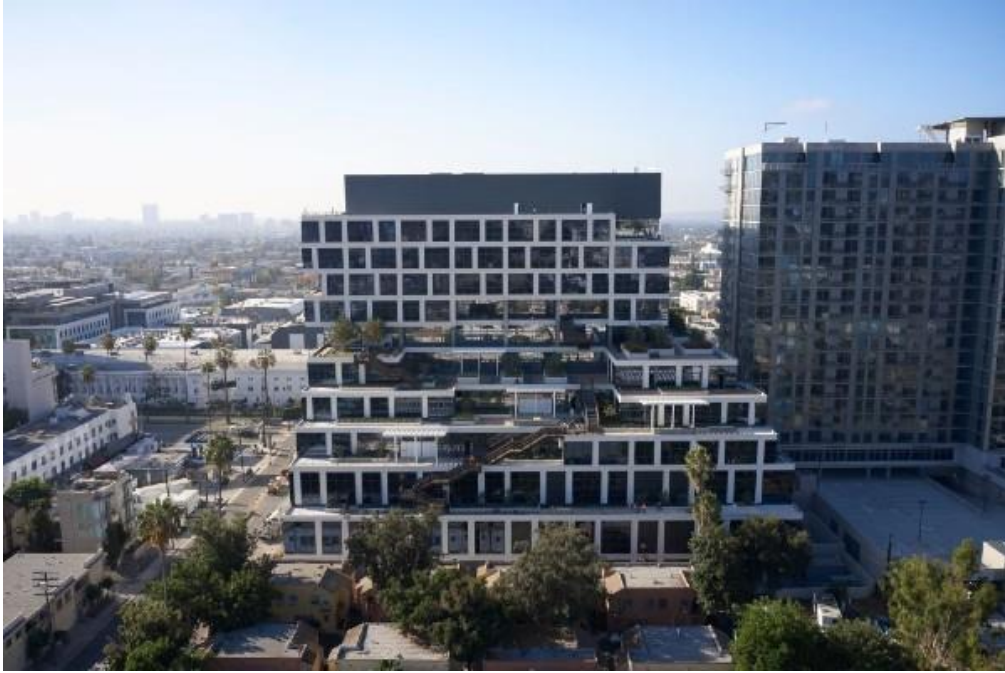
Εικόνα 4-11: Πολυώροφο κτίριο, αυτόνομο ενεργειακά, όπου τα φωτοβολταϊκά πάνελ δεν έχουν τοποθετηθεί στο δώμα αλλά αποτελούν δομικά στοιχεία του κτιρίου [89]
