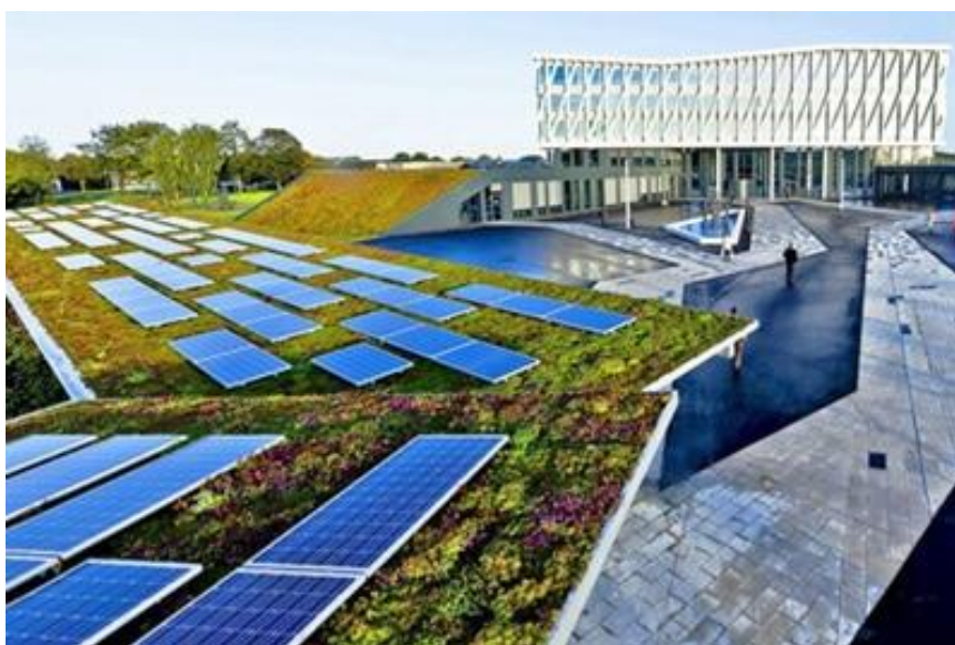
Εικόνα 4-17: Φυτεμένα δώματα με ταυτόχρονα εγκατεστημένα Φ/Β/ στη συστήματα [89]
