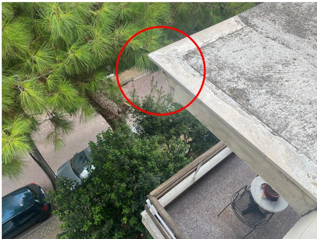
Εικόνα 5-26: Φθορά και πτώση υλικών από την μαρκίζα του εξώστη του β' ορόφου
