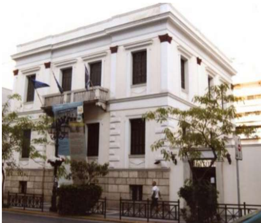
Εικόνα 13. Το ίδιο κτίριο μετά την ανακαίνιση του για ένα διάστημα (2006-- 2010) λειτουργούσε ως Δημαρχείο.
