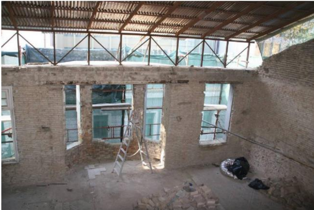
Εικόνα 66. Η προσωρινή αποκατάσταση της στέγης. Πηγή: Προσωπικό αρχείο.
