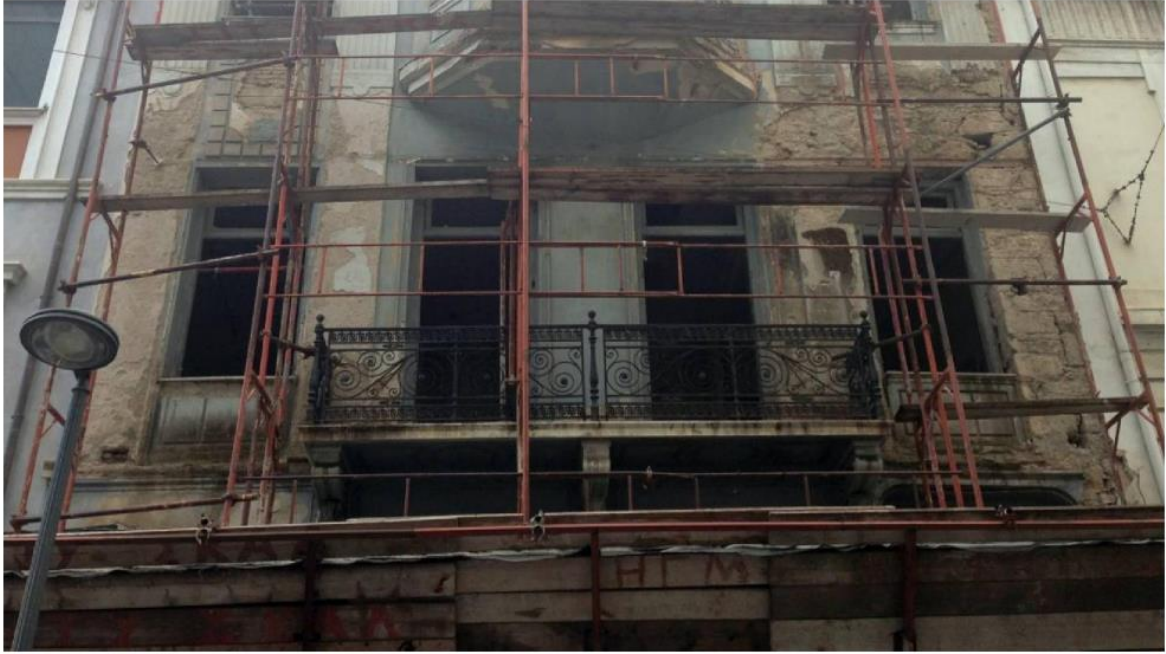
Εικόνα 30. Άποψη α' ορόφου, Πηγή: Προσωπικό αρχείο
