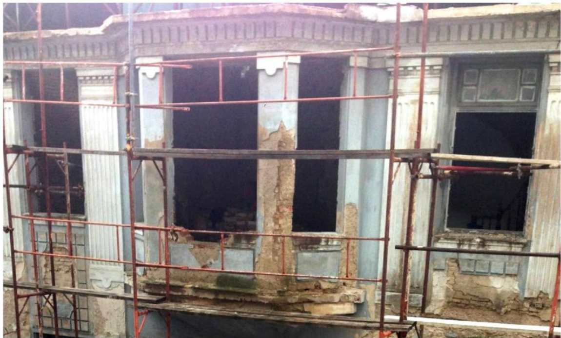
Εικόνα 31. Άποψη β' ορόφου, Πηγή: Προσωπικό αρχείο
