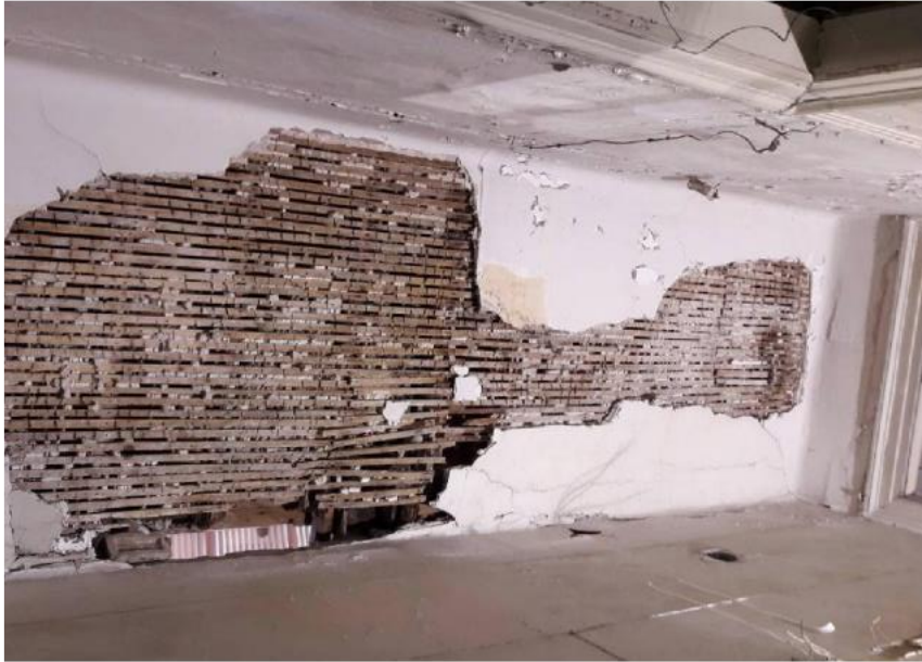
Εικόνα 48. Επεκταμένες απώλειες κονιάματος μαζί με το ζωγραφικό στρώμα. Πηγή: Προσωπικό αρχείο. Πηγή: Προσωπικό αρχείο.
