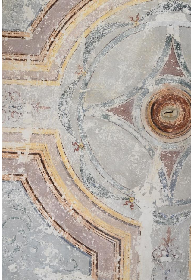
Εικόνα 65. Απολεπισμένο, κονιορτοποιημένο και αποχρωματισμένο ζωγραφικό στρώμα. Πηγή: Προσωπικό αρχείο
