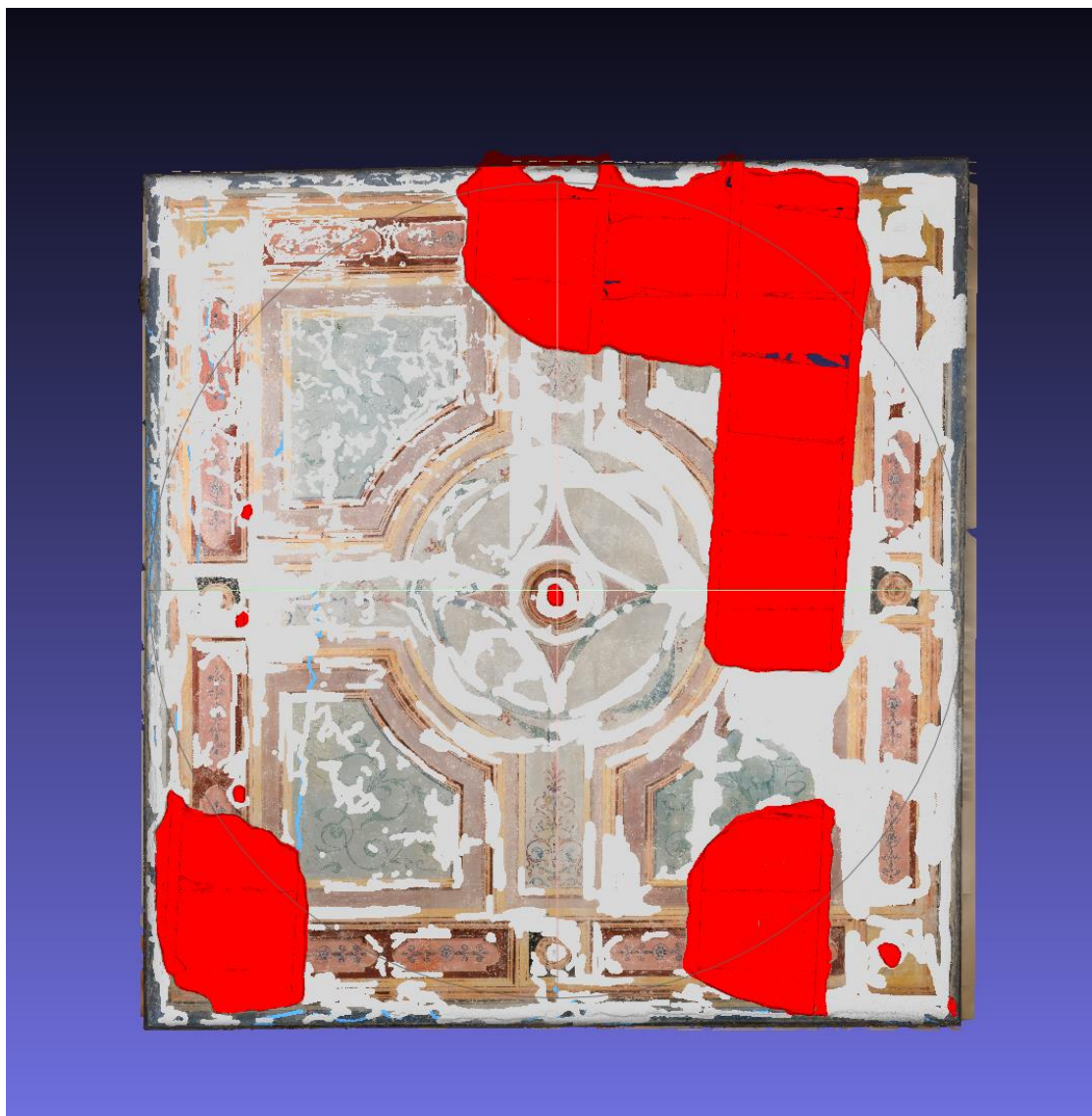
Εικόνα 130. Χαρτογράφηση όλων των φθορών της οροφograφίας, Πηγή: Προσωπικό αρχείο.
