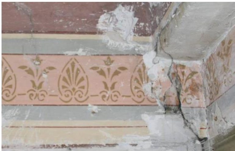
Εικόνα 49. αποχρωματισμοί του ζωγραφικού διακόσμου ρωγματώσεις και αποκολλήσεις του κονιάματος μαζί με το ζωγραφικό στρώμα. Πηγή: Προσωπικό αρχείο.
