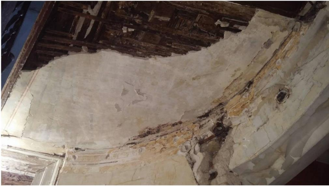
Εικόνα 44. Ρωγματώσεις, απώλειες και αποκολλήσεις κονιάματος μαζί με το ζωγραφικό στρώμα. Πηγή: Προσωπικό αρχείο.
