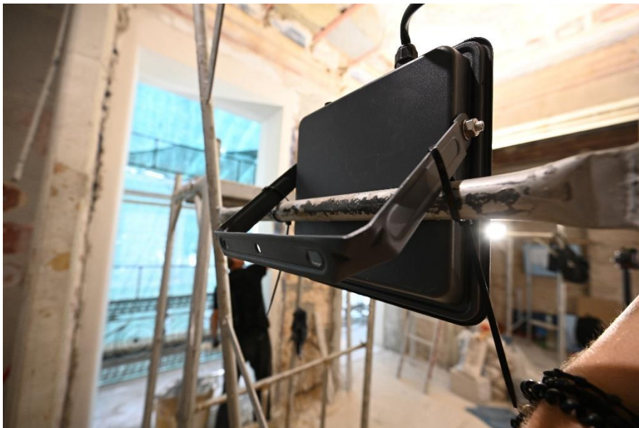
Εικόνα 89. Τοποθέτηση και σταθεροποίηση των φωτιστικών πηγών με πλαστικά δεματικά. Πηγή: Προσωπικό αρχείο.
