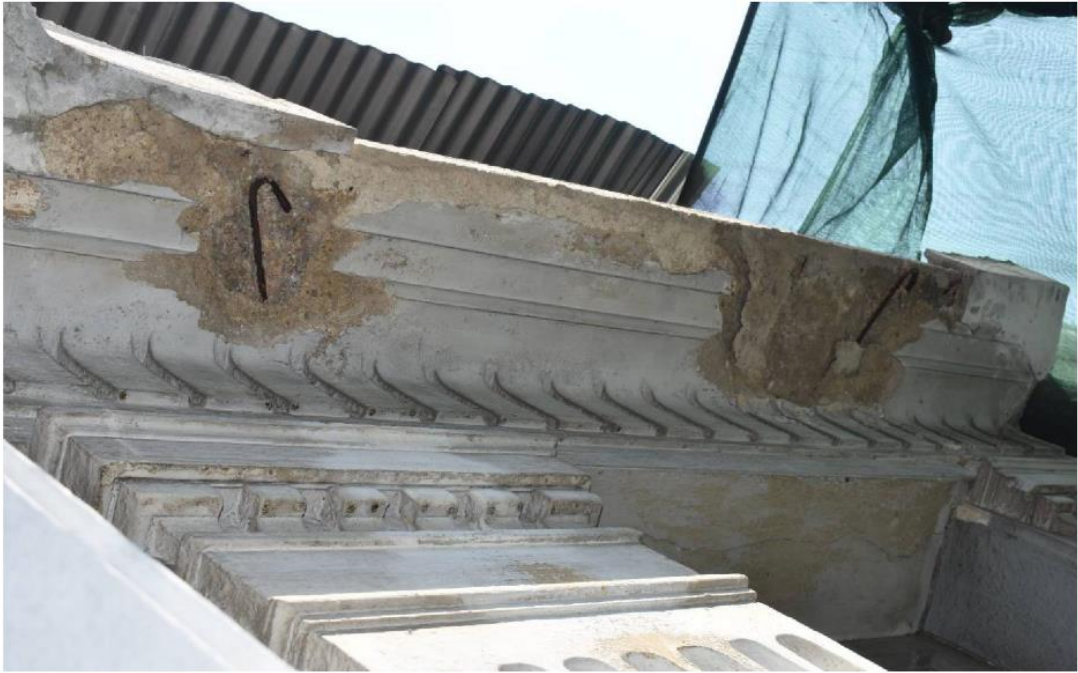
Εικόνα 37. . Κονιορτοποίηση, απώλειες κονιαμάτων και οξείδωση των μεταλλικών συνδέσμων στην επίστεψη. Πηγή: Προσωπικό αρχείο
