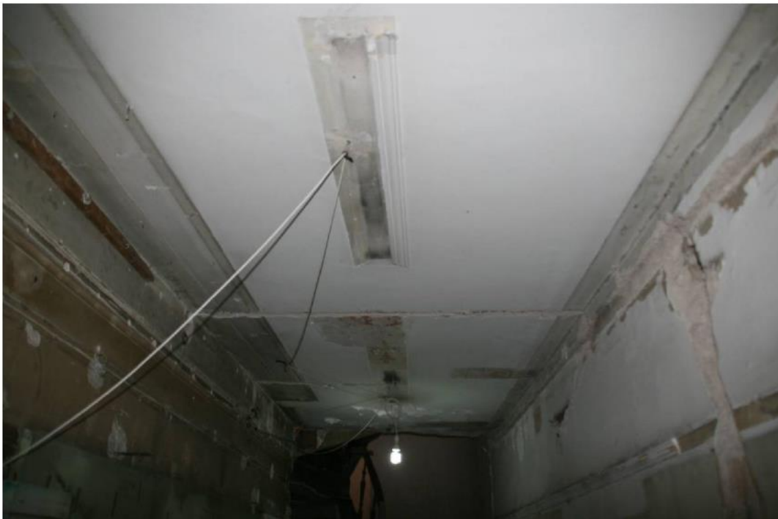
Εικόνα 43. Άποψη ισογείου α' ορόφου. Πηγή: Προσωπικό αρχείο.
