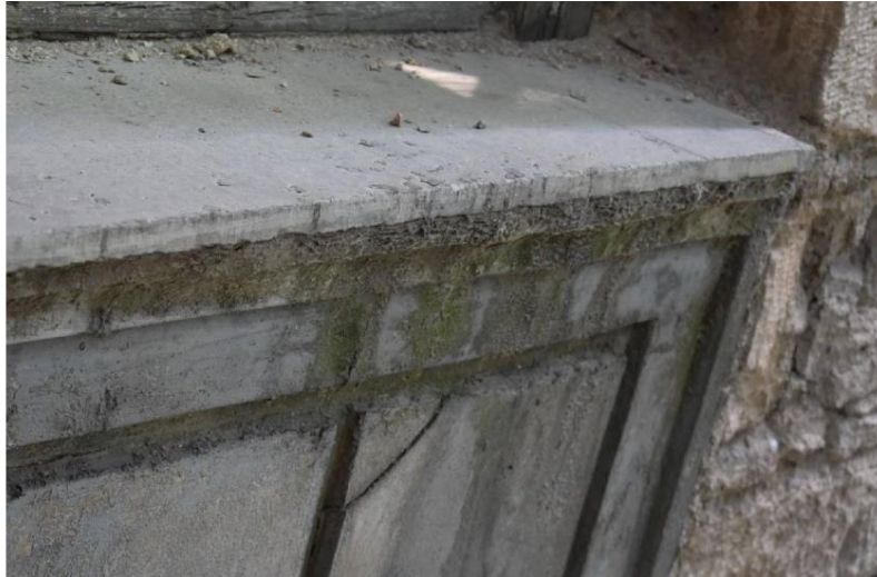
Εικόνα 39. Ύπαρξη βιολογικών επικαθήσεων κάτω από τα ανοίγματα του β' ορόφου, Πηγή: Προσωπικό αρχείο.
