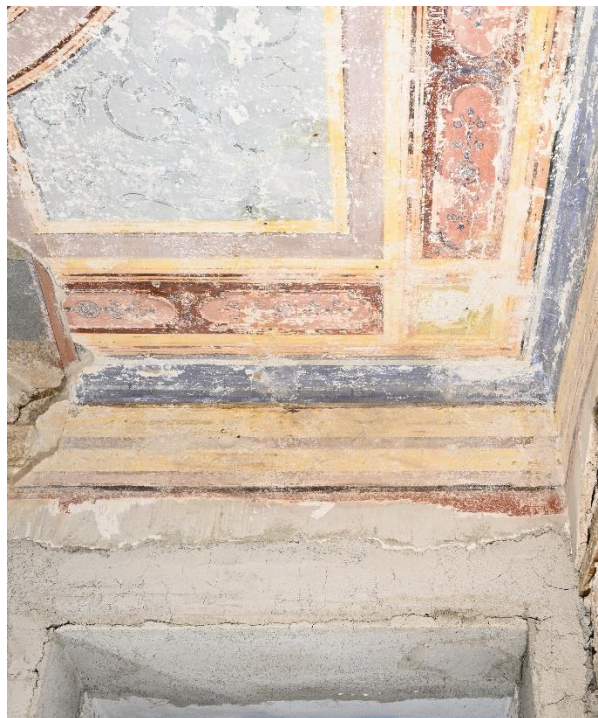
Εικόνα 57. Η διακόσμηση στη φρίζα και στο κατακόρυφο τοιχο. Πηγή: Προσωπικό αρχείο.
