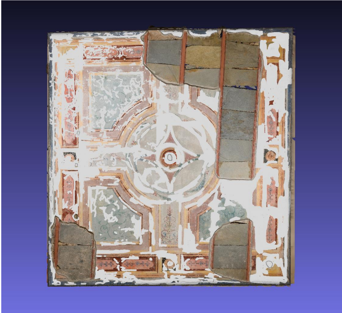
Εικόνα 126. Χαρτογράφηση των αποχρωματισμών της οροφογραφίας με ανοιχτό – γκρι χρώμα μέσω της εφαρμογής Meshlab, Πηγή: Προσωπικό αρχείο.
