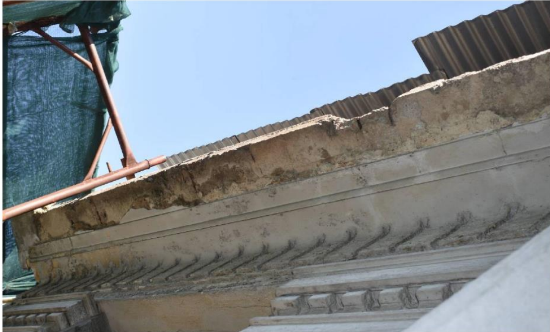
Εικόνα 38. . Κονιορτοποίηση, απώλειες κονιαμάτων και οξείδωση των μεταλλικών συνδέσμων στην επίστεψη. Πηγή: Προσωπικό αρχείο
