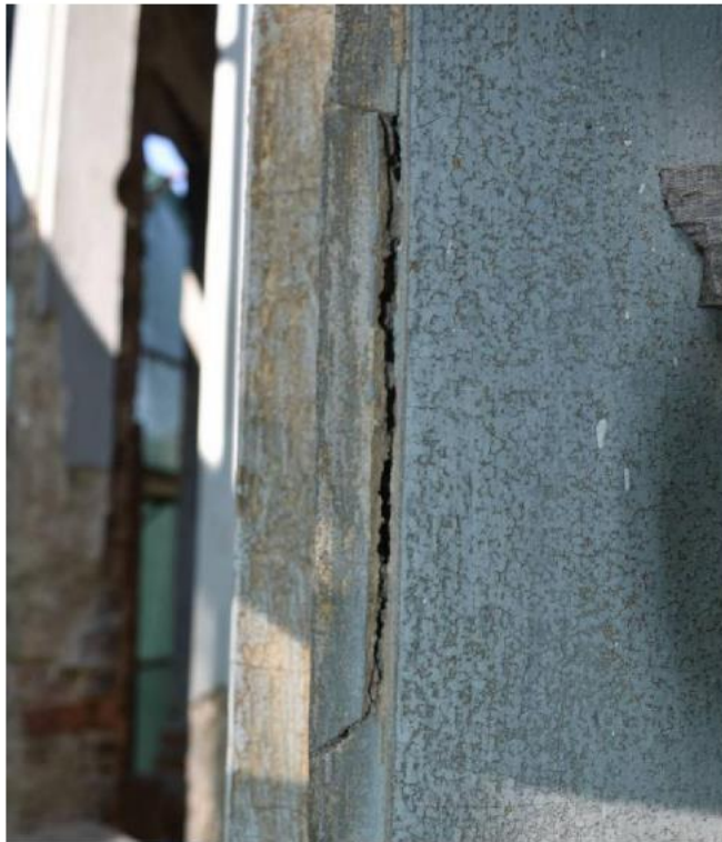
Εικόνα 40. Ρωγματώσεις και αποκολλήσεις στα «τραβηχτά» των παραθύρων του β' ορόφου. Πηγή: Προσωπικό αρχείο.
