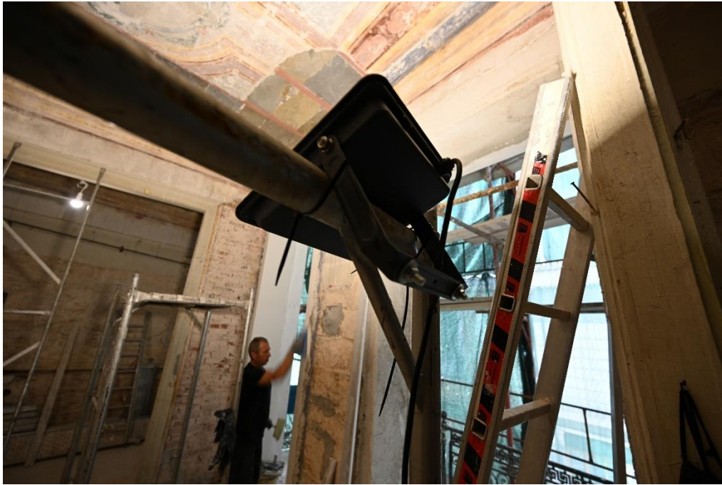
Εικόνα 90. Τοποθέτηση και σταθεροποίηση των φωτιστικών πηγών με πλαστικά δεματικά. Πηγή: Προσωπικό αρχείο.
