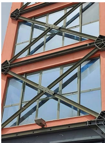
Εικόνα 4.9: Τοποθέτηση μεταλλικού εξωσκελετού στην όψη του κτιρίου
