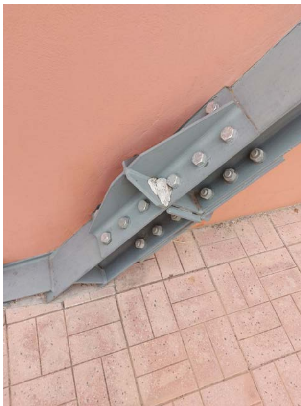
Εικόνα 4.7: Λεπτομέρεια συγκόλλησης μεταλλικού χιαστί συνδέσμου
