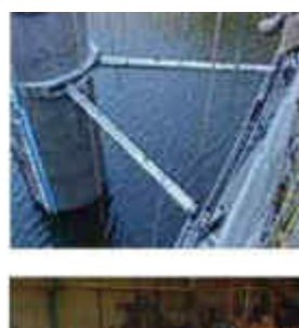
Εικόνα 2.4: Χρήση αντιλυγισμικών συνδέσμων στην γεφυροποιία και όπου απαιτείται προστασία έναντι λυγισμού.[15].
