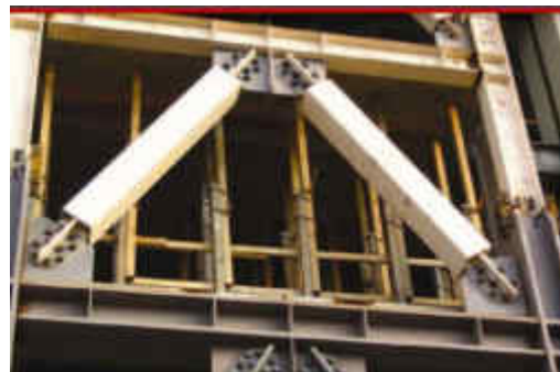
Εικόνα 2.3: Χρήση αντιλυγισμικών συνδέσμων στην ενίσχυση φορέων απο Ω/Σ[15].
