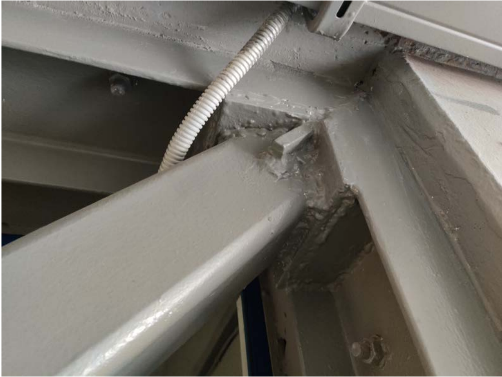
Εικόνα 4.4: σύνδεση μεταλλικού συνδέσμου με τον μεταλλικό εξωσκελετό (άνω μέρος)
