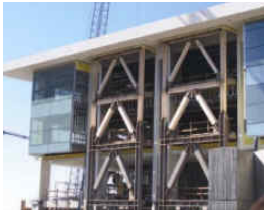
Εικόνα 2.3: Χρήση αντιλυγισμικών συνδέσμων στην ενίσχυση φορέων απο Ω/Σ[15].
