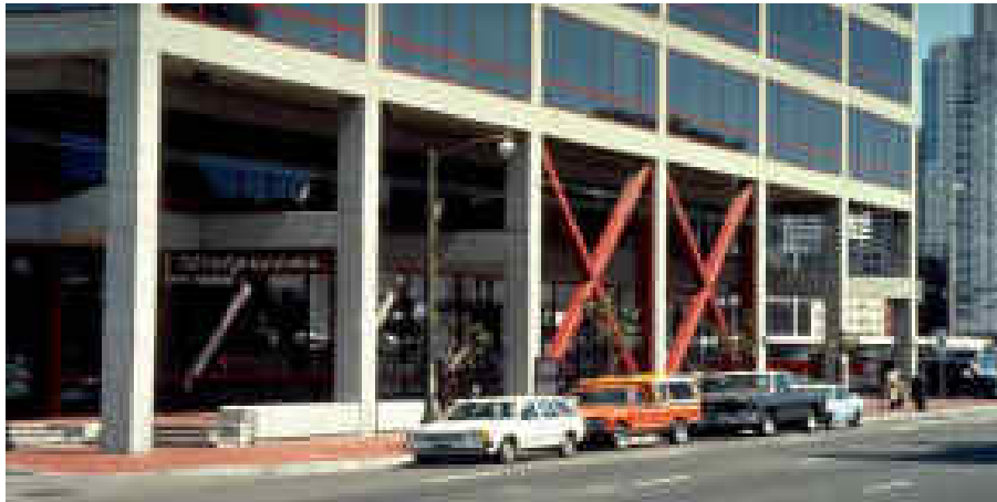
Εικόνα 1.3: Χρήση δικτυωτού χιαστί συνδέσμου σε πολυώροφο κτίριο[11]
