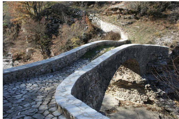
6.33: Γεφύρι της Νονούλως Πηγή: https://apeirosgaia.wordpress.com/
