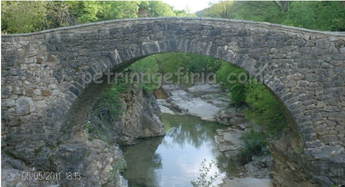
4.13: Τοιχοποιία γεφυριού από φυσικούς λίθους Πηγή: www.petrinagefiria.com
