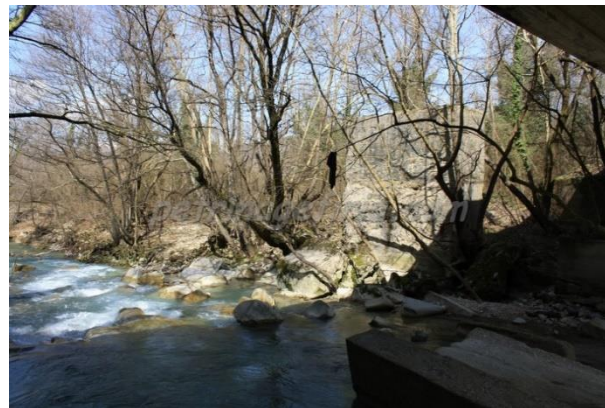
6.28: Γέφυρα Γκόλα Πηγή: www.petrinagefiria.com
