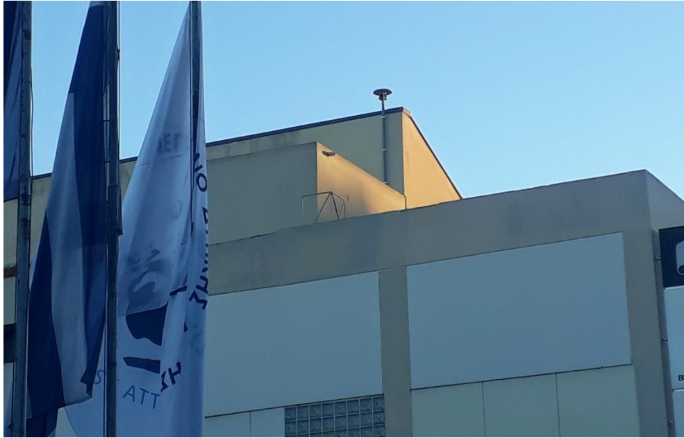
Εικόνα 4.14 Κεραία μόνιμου σταθμού UNIWA1.
