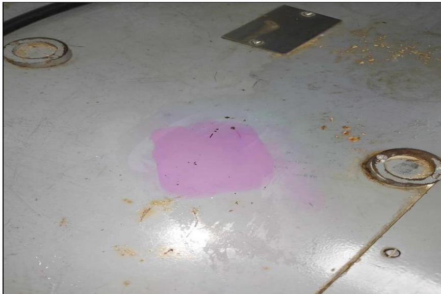
Εικόνα 17: Γεννήτρια, εργαστήριο επεξεργασίας τροφίμων, Πανεπιστήμιο Δυτικής Αττικής
