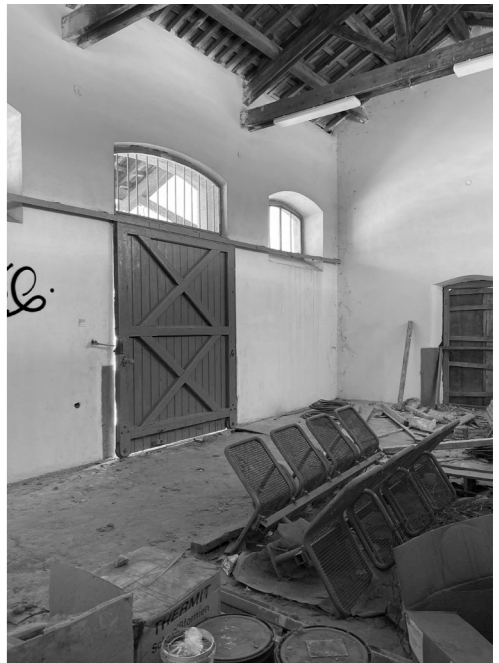
Εικόνα 54. Εσωτερική άποψη κτιρίου μελέτης (Μπελίας Μ., 2024)
