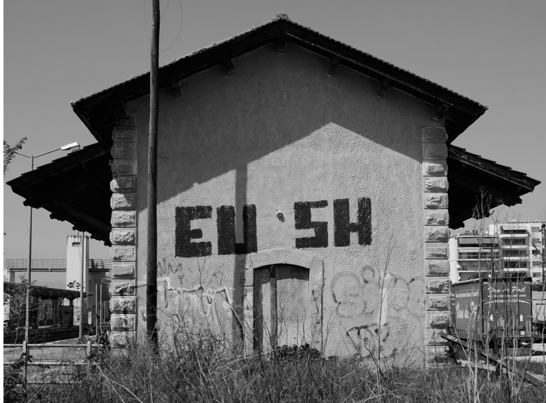
Εικόνα 52. Δυτική οψη κτιρίου μελέτης (Παπακωνσταντίνου Κ., 2024)
