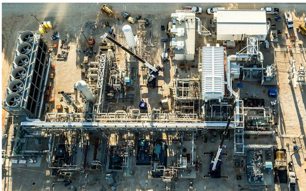
Εικόνα 2.1.3.1: Το δοκιμαστικό εργοστάσιο παραγωγής ενέργειας της NET Power στο La Porte του Τέξας συλλαμβάνει το CO_2 που παράγει πριν εισέλθει στην ατμόσφαιρα (Sonal Patel, 2022).
