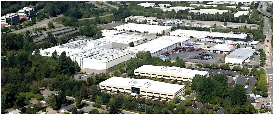
Σχήμα 2.12 Intergate Seattle data center.
