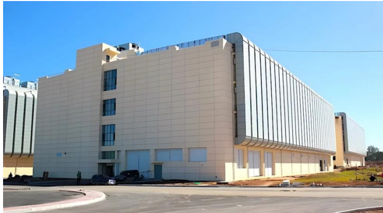
Σχήμα 2.16: China Telecom data center.
