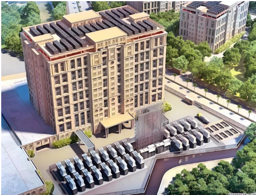
Σχήμα 2.11:Yotta NM1 data center.
