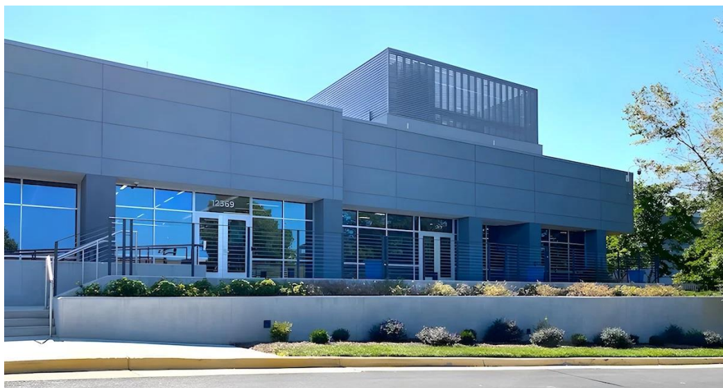
Σχήμα 2.13: Core Site Reston VA3 data center.
