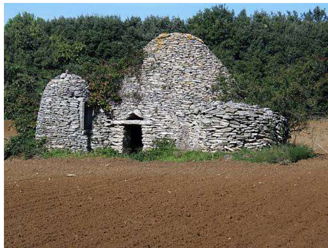
Εικόνα 14. Καλύβα αποθήκευσης στη Γαλλία, κατασκευασμένη με την τεχνική της ξηρής πέτρας. Από την επίσημη ιστοσελίδα της UNESCO (UNESCO 2019α, πρόσβαση: 08/07/2020)
