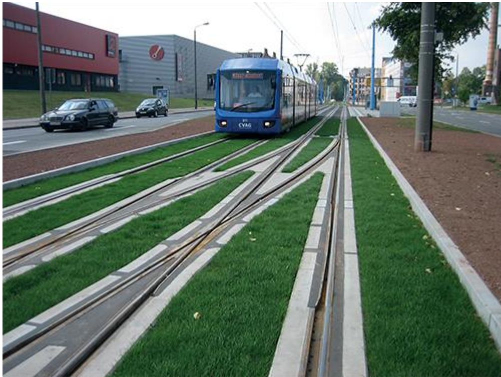
Εικόνα 4.5 Γραμμές σιδηροδρομικού δικτύου με χλοοτάπητα
