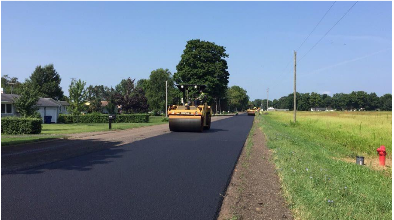
Εικόνα 4.2 Στρώση ασφάλτου με RARx στο Μίσιγκαν της Αμερικής
