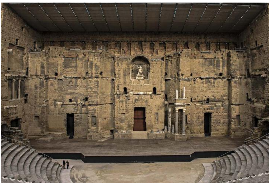
Εικόνα 15 The stage front of the Orange theater: current state. Phot. P. Disdier, CNRS (Bartette και Rosso, 2019, σελ. 2)
