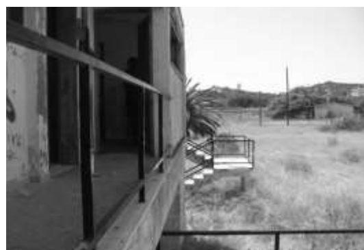
(Εικόνα 4): Άποψη της βόρειας όψης του ξενοδοχείου.
