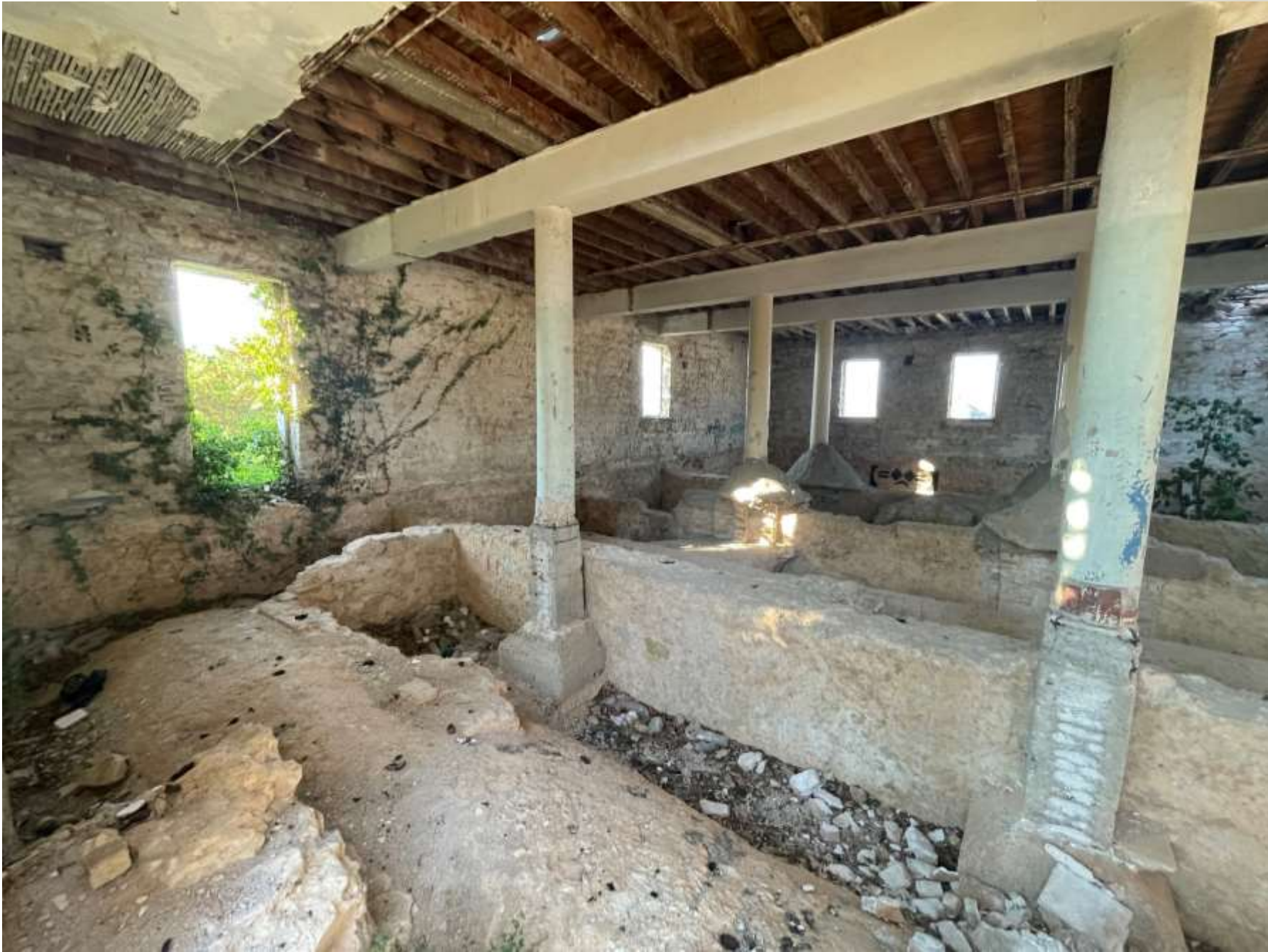
Εικόνα 11. Εσωτερική φωτογραφία υφιστάμενης κατάστασης στάθμης γ-δ
