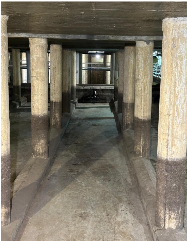
Σχήμα 25: Υπόγεια δεξαμενή στη Βαρκελώνη (Πηγή: προσωπικό αρχείο Φελώνη Ε.).
