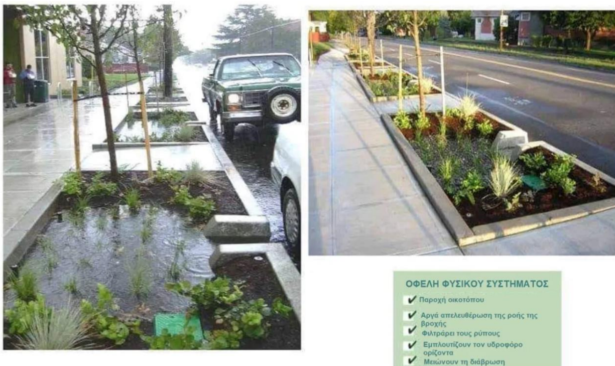
Σχήμα 23: Κήπος βροχής σε περιβάλλον βροχόπτωσης (Πηγή: dasarxeio.com ).
