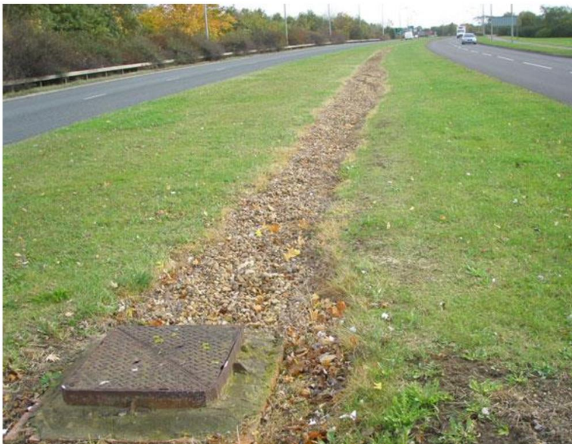
Σχήμα 28: Τάφος διήθησης σε κύριο οδικό άξονα της Αγγλίας (Πηγή: Πριάρη, 2016; Yu 2013).
