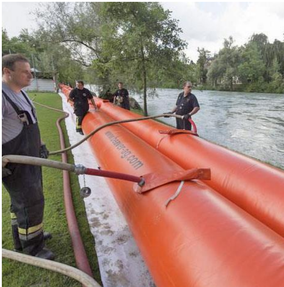
Σχήμα 45: Το φουσκωτό φράγμα Beaver (Πηγή: ivator.gr ).
