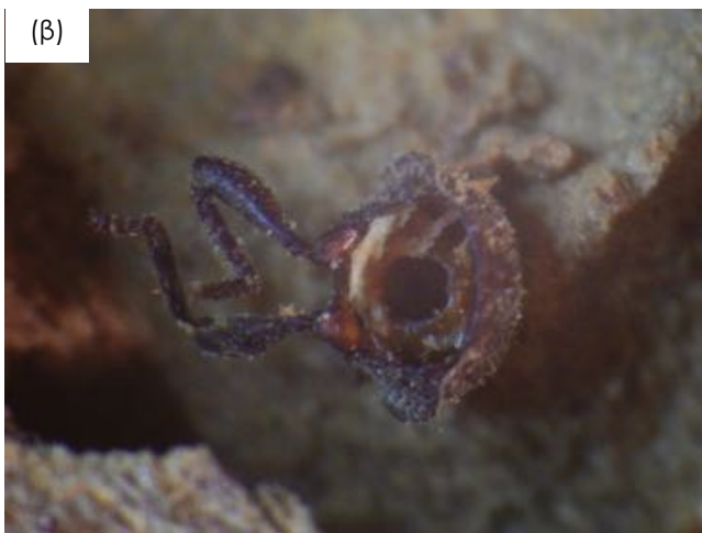
Εικ. 22: Ξυλοφάγο έντομο σε σπή του ξύλινου φορέα (α) του σώματος του εντόμου, (β) του κεφαλιού του εντόμου στο σημείο που βρέθηκε
